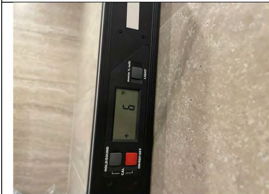
Фото №11. Измерения уровня стен в ванной комнате.
