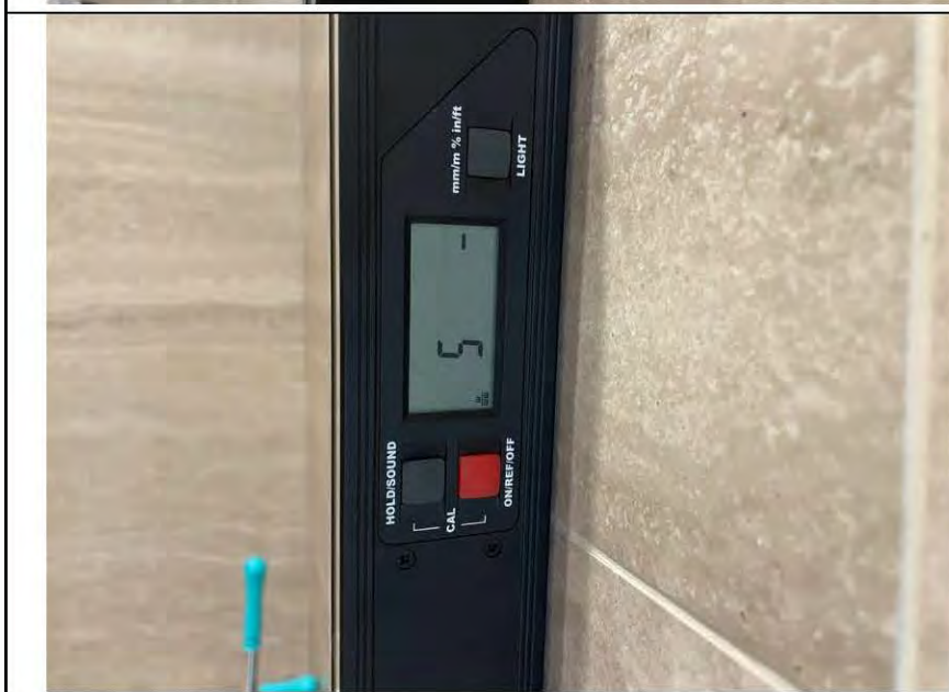
Фото №12. Измерения уровня стен в санузле.
