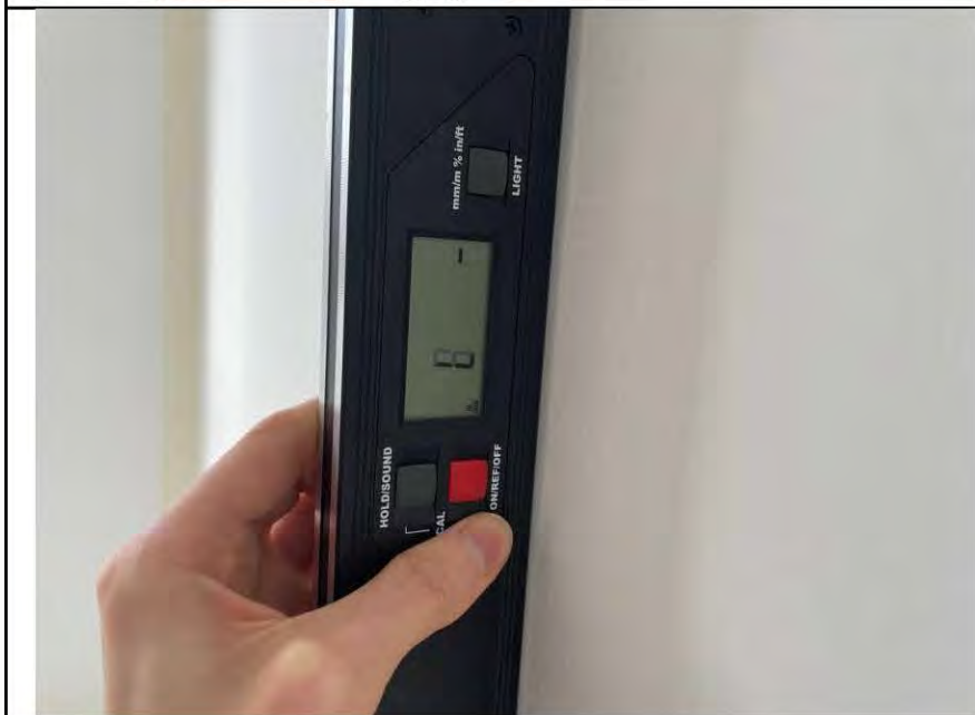
Фото №8. Измерения уровня стен в спальне.
