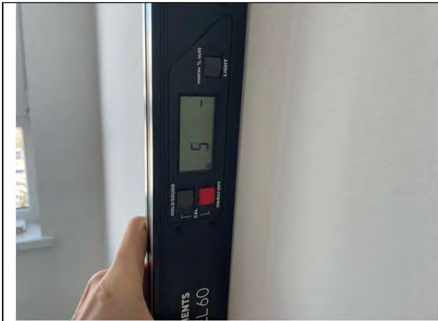
Фото №7. Измерения уровня стен в кухне.
