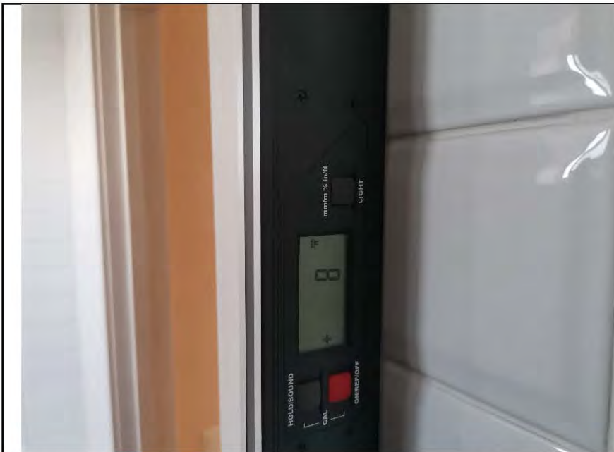
Фото №13. Измерения уровня стен в ванной комнате.
