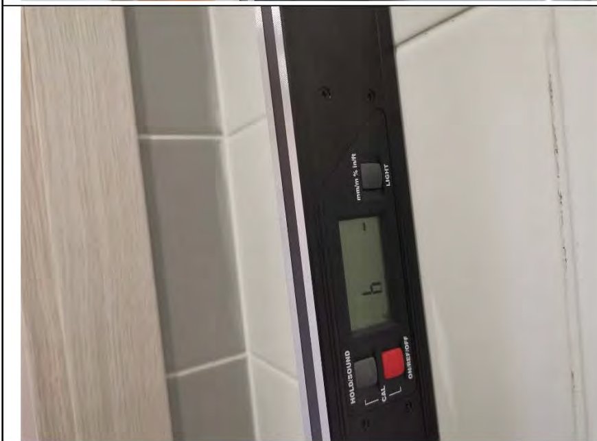
Фото №14. Измерения уровня стен в санузле.
