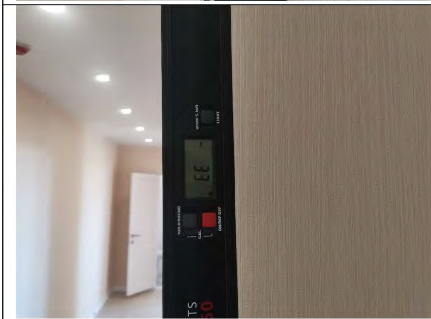
Фото №12. Измерения уровня стен в коридоре.
