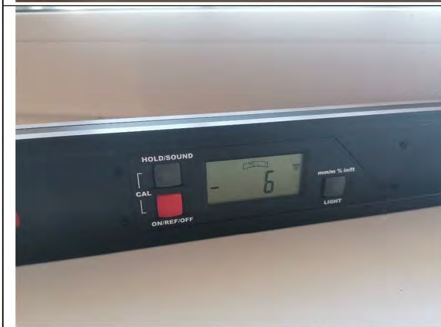
Фото №62. Отклонение подоконной доски по горизонтали в гостиной.
