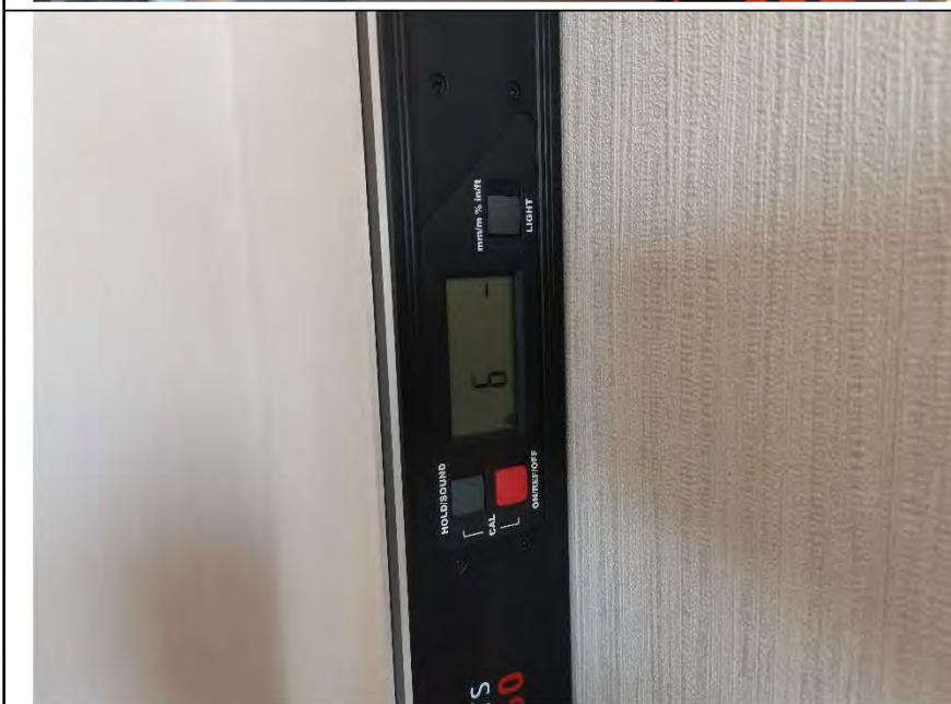
Фото №9. Измерения уровня стен в кухне.
