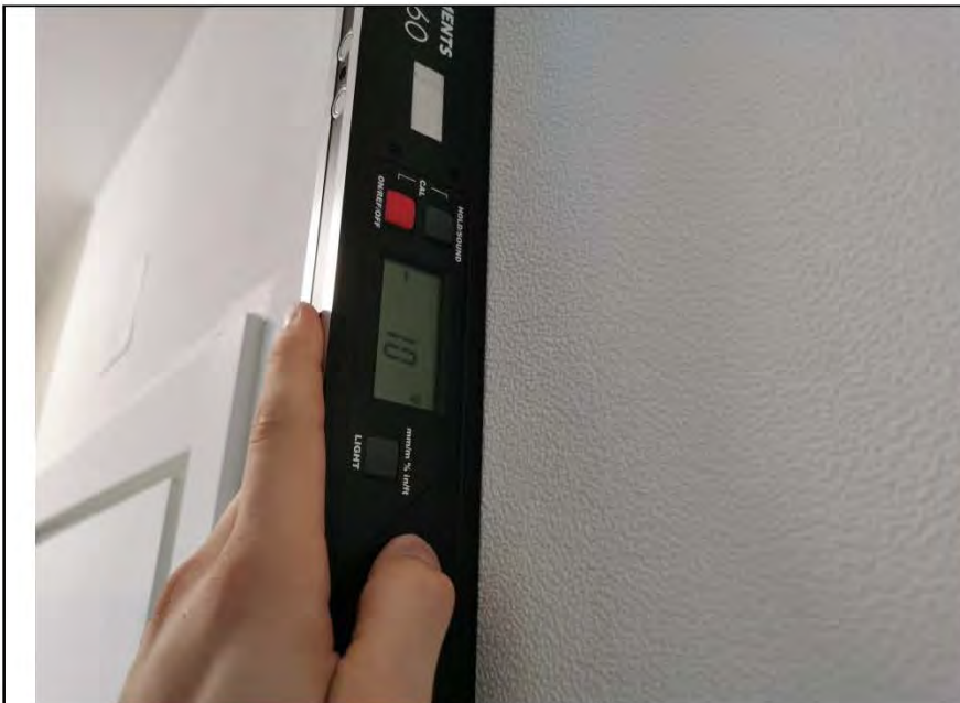
Фото №7. Измерение уровня стен в коридоре.
