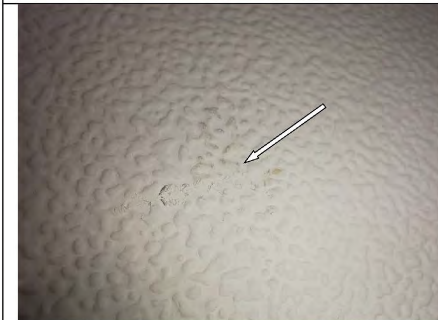
Фото №14. Потертости на поверхности обойного полотна в кухне-гостиной.
