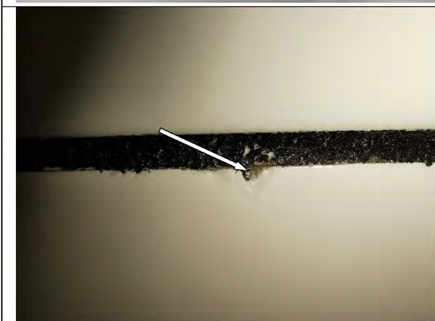
Фото №18. Отбитости на настенной плитке в ванной комнате.
