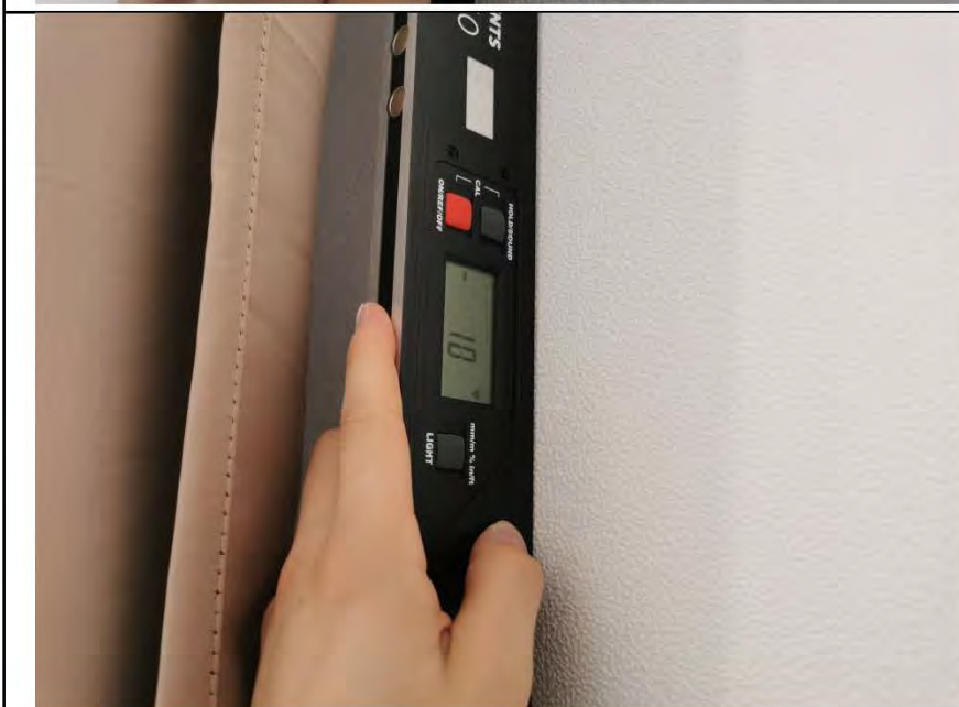
Фото №8. Измерение уровня стен в спальне.
