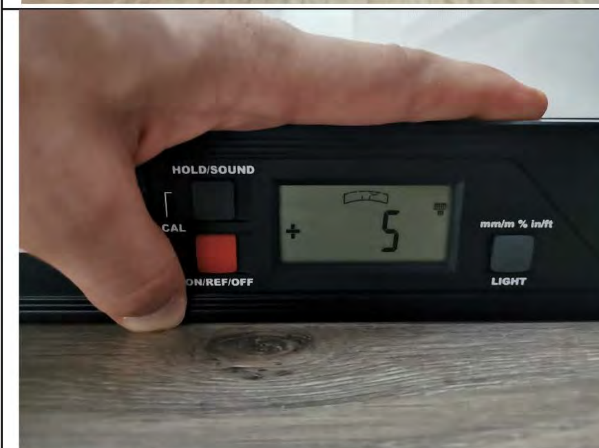
Фото №20. Измерение уровня пола в спальне.
