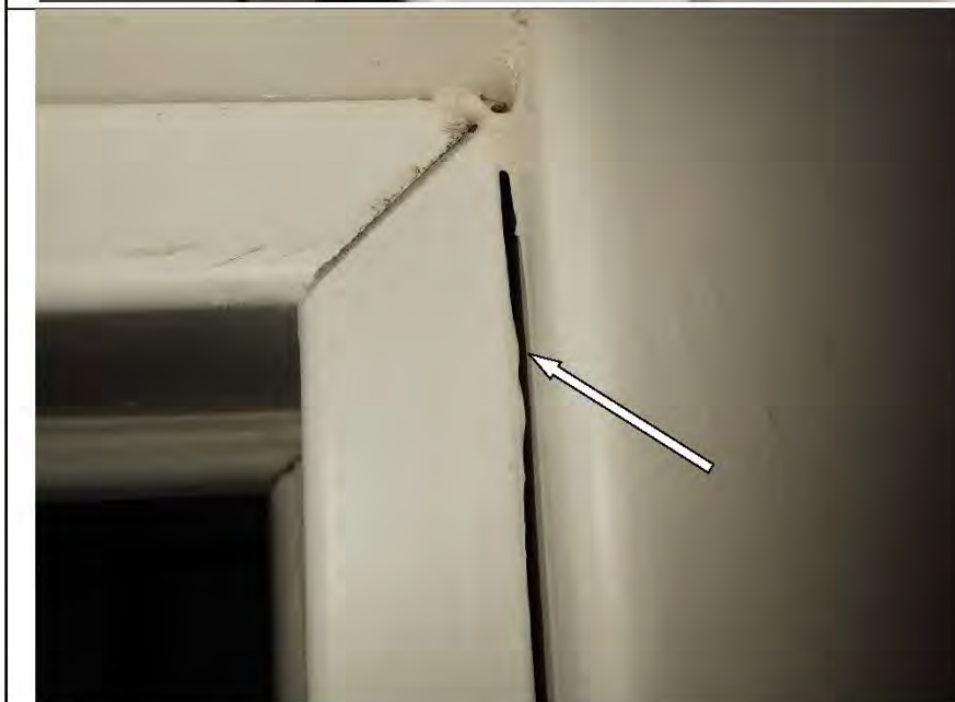
Фото №44. Ненадежное соединение элементов короба деревянного дверного блока, загрязнение короба дверного блока в спальне.
