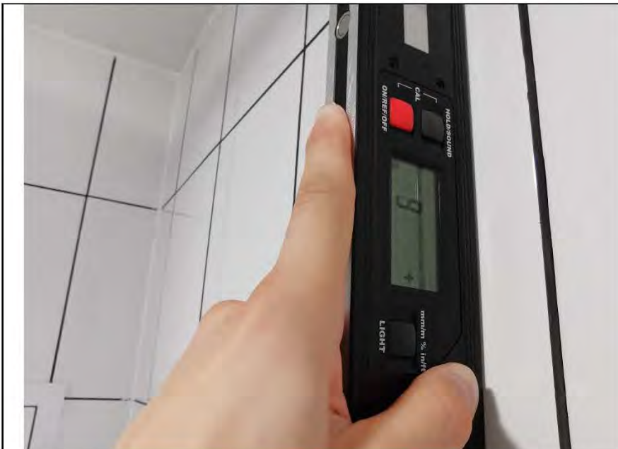
Фото №16. Измерение уровня стен в ванной комнате.
