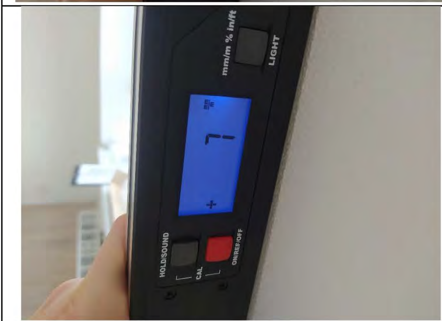
Фото №6. Измерение уровня стен в кухне.
