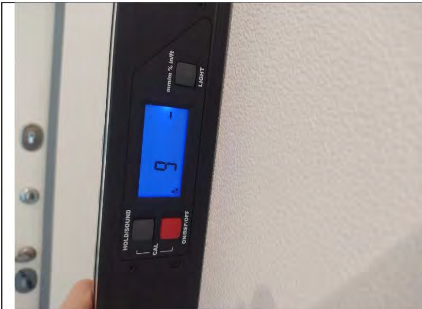
Фото №7. Измерение уровня стен в прихожей.
