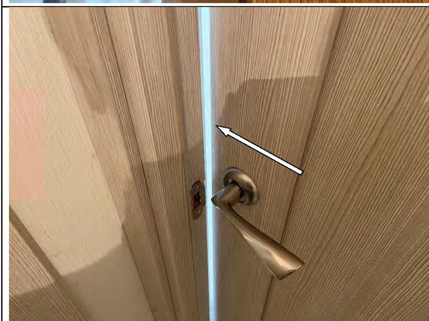
Фото №78. Не закрывается/открывается свободно дверь в кухне.
