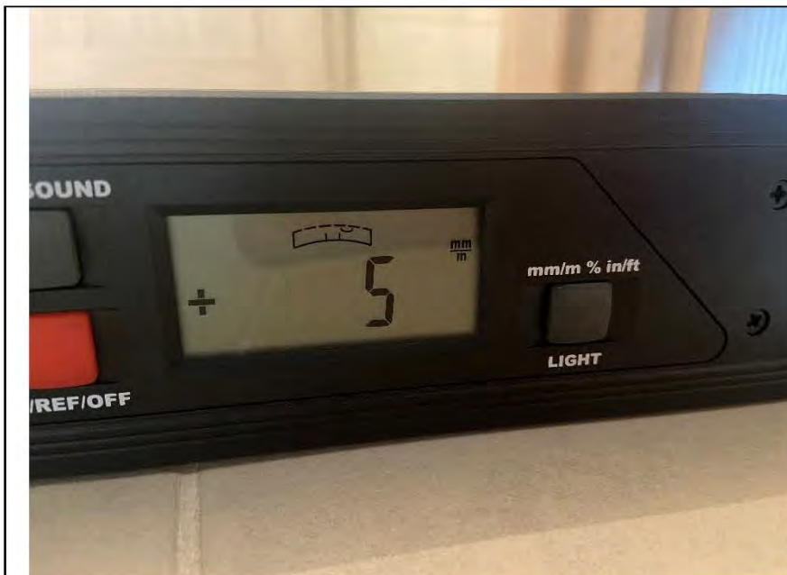
Фото №22. Отклонение поверхности напольного покрытия из керамической плитки в кухне.
