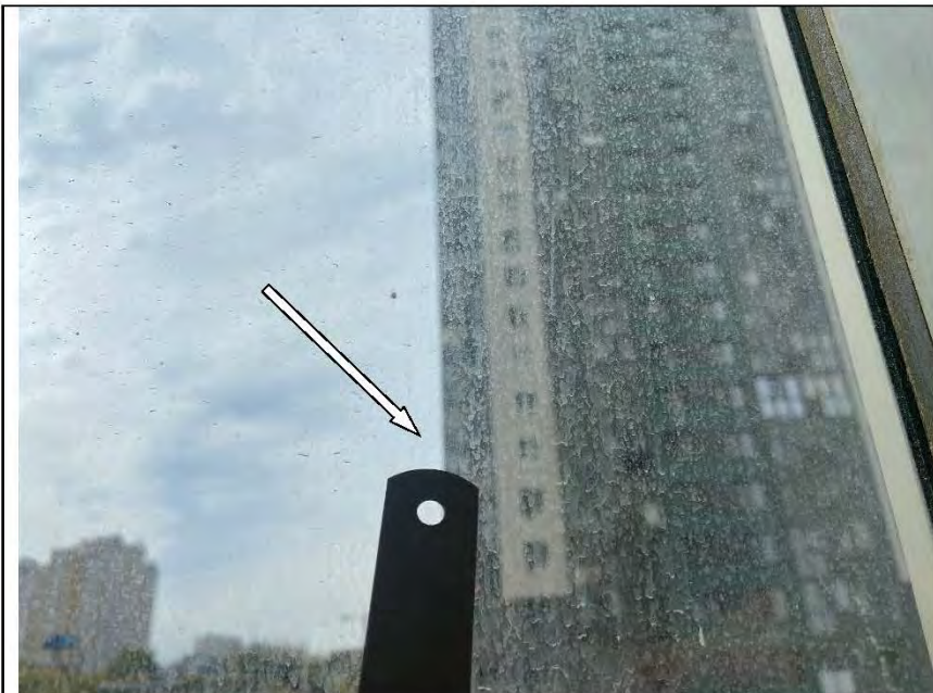
Фото №49. Окарины на стеклопакете алюминиевого оконного блока на лоджии.
