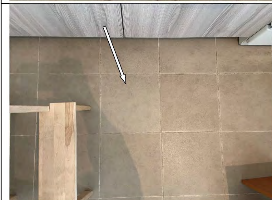
Фото №17. Разный цвет напольной керамической плитки в кухне.
