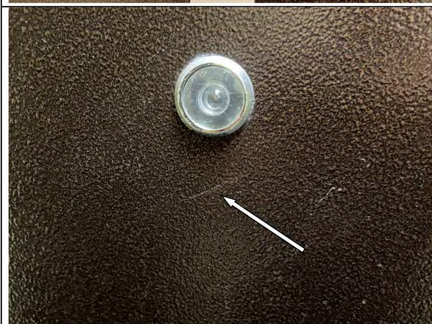
Фото №65. Дефект на полотне входного дверного блока в коридоре.
