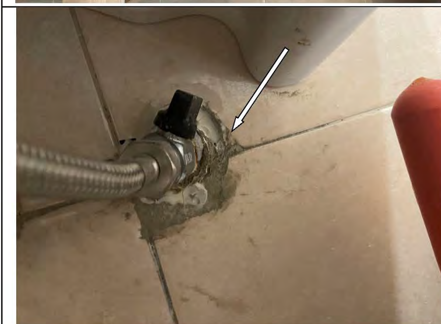
Фото №18. Сколы на настенной керамической плитке в ванной комнате.
