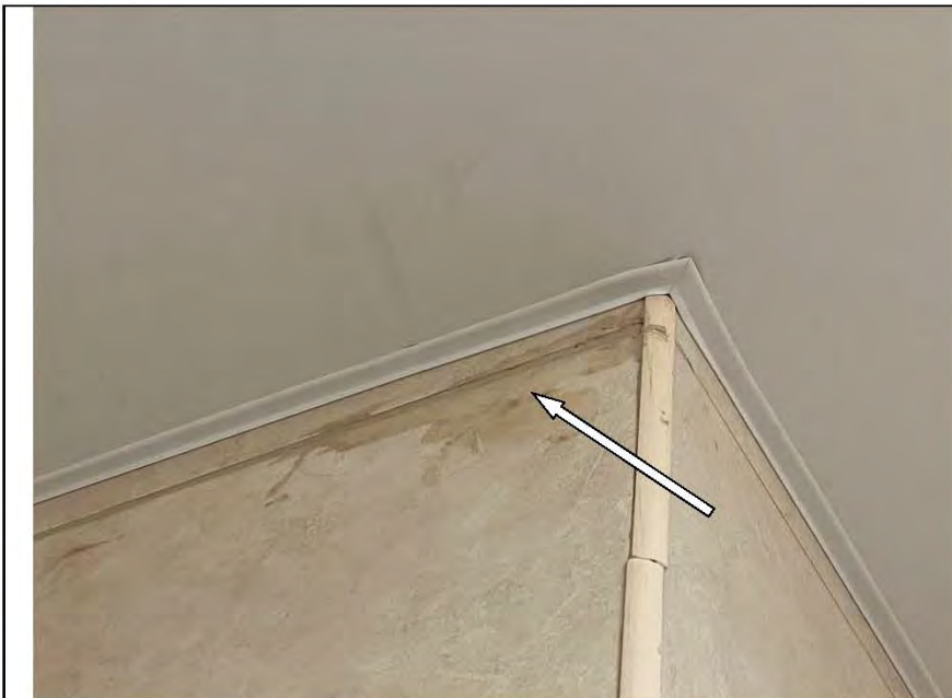
Фото №13. Загрязнения на настенной керамической плитке в ванной комнате.
