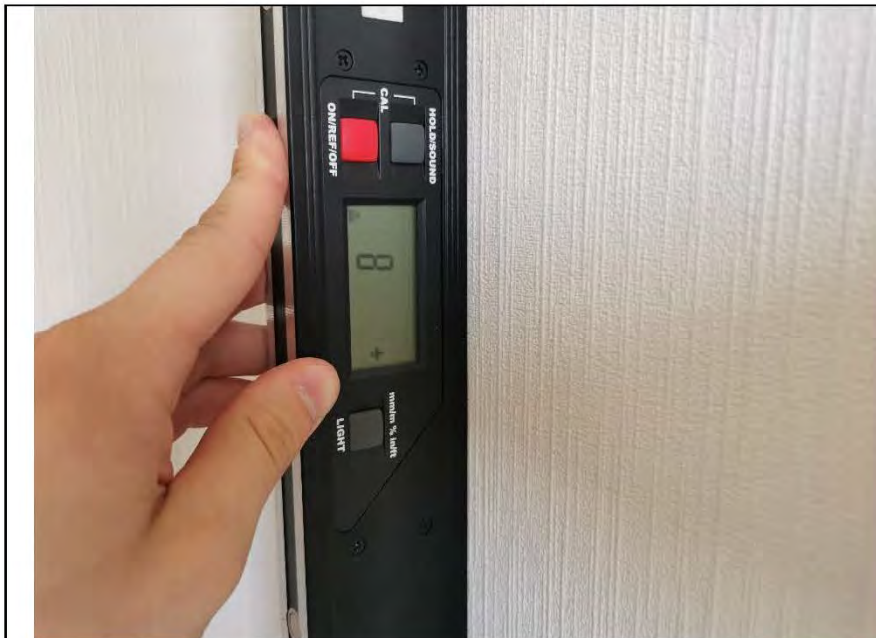
Фото №10. Измерение уровня стен в кухне.
