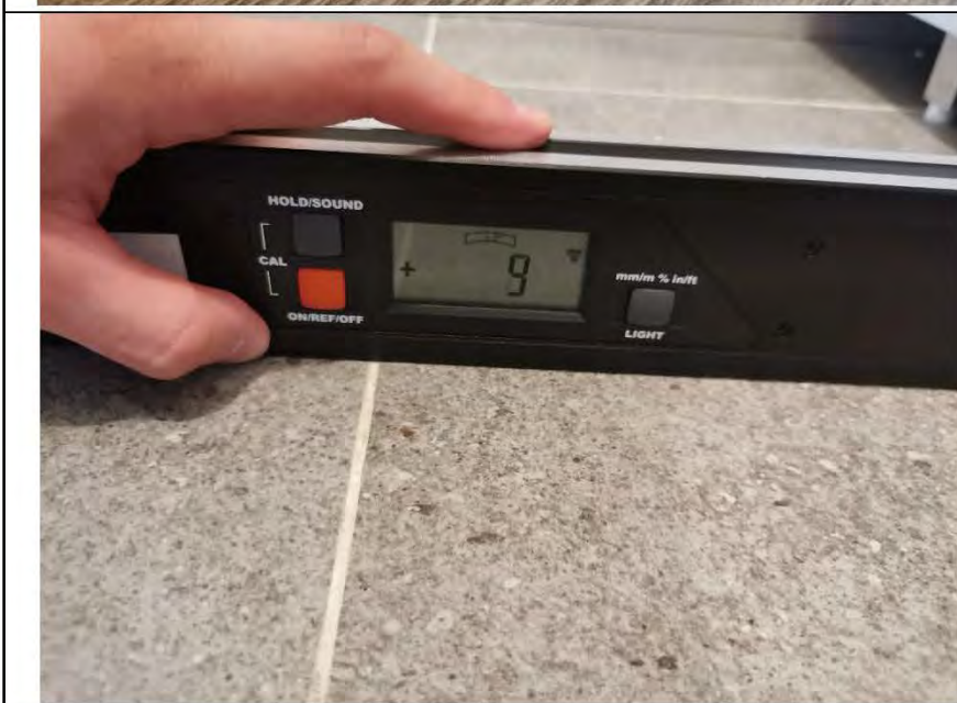
Фото №30. Измерение уровня пола в ванной комнате.
