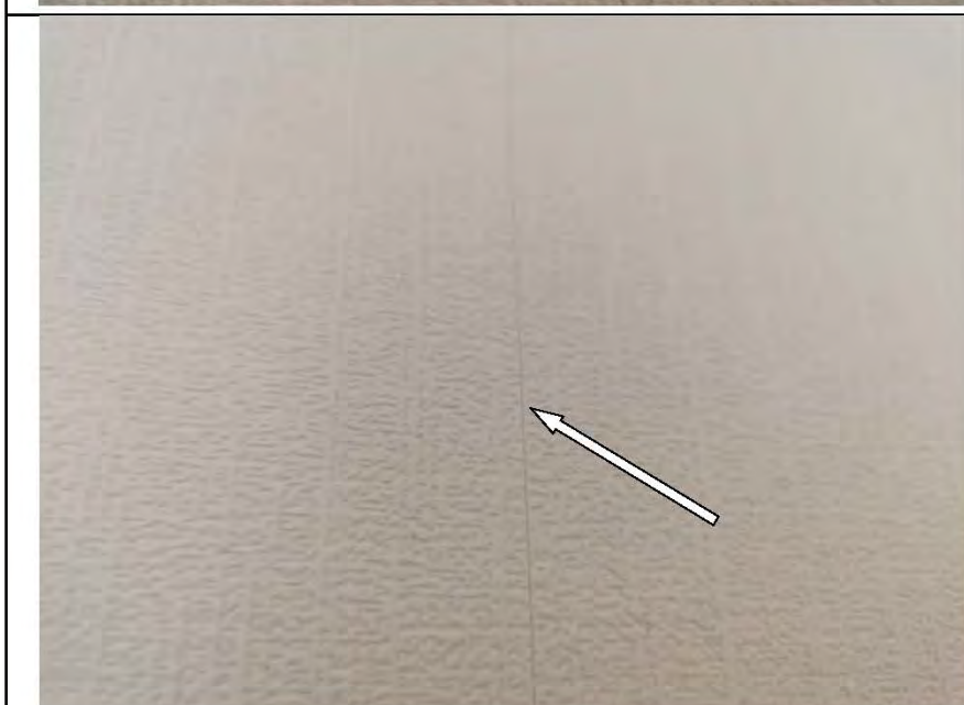
Фото №12. Читаемые обойные стыки в коридоре.
