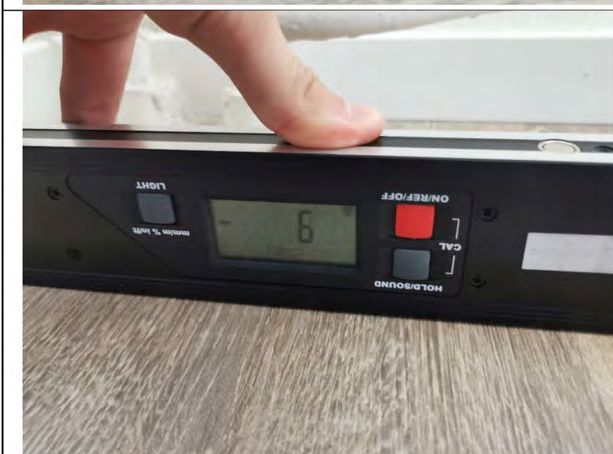
Фото №24. Измерение уровня пола в кухне.
