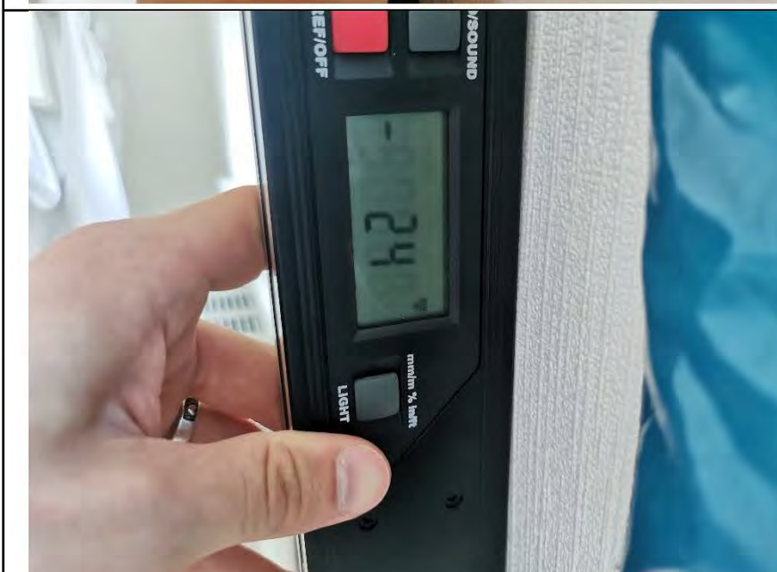
Фото №9. Измерение уровня стен в спальне.
