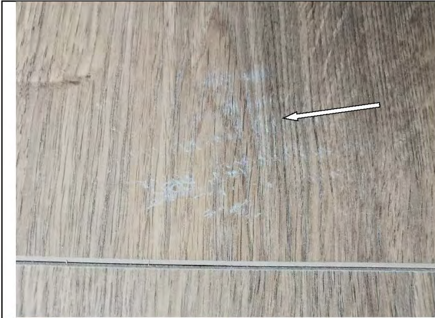
Фото №19. Загрязнения на поверхности ламината в комнате.
