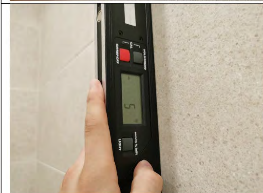
Фото №11. Измерение уровня стен в ванной комнате.
