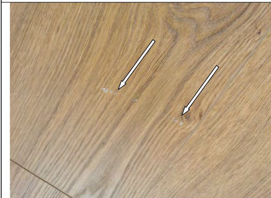
Фото №20. Загрязнения на поверхности ламината в комнате.
