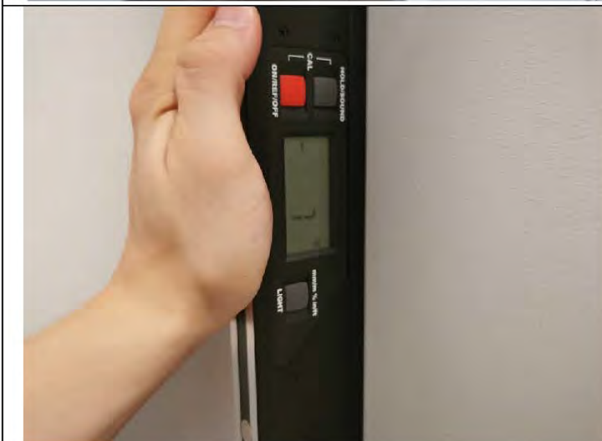
Фото №5. Измерение уровня стен в коридоре.
