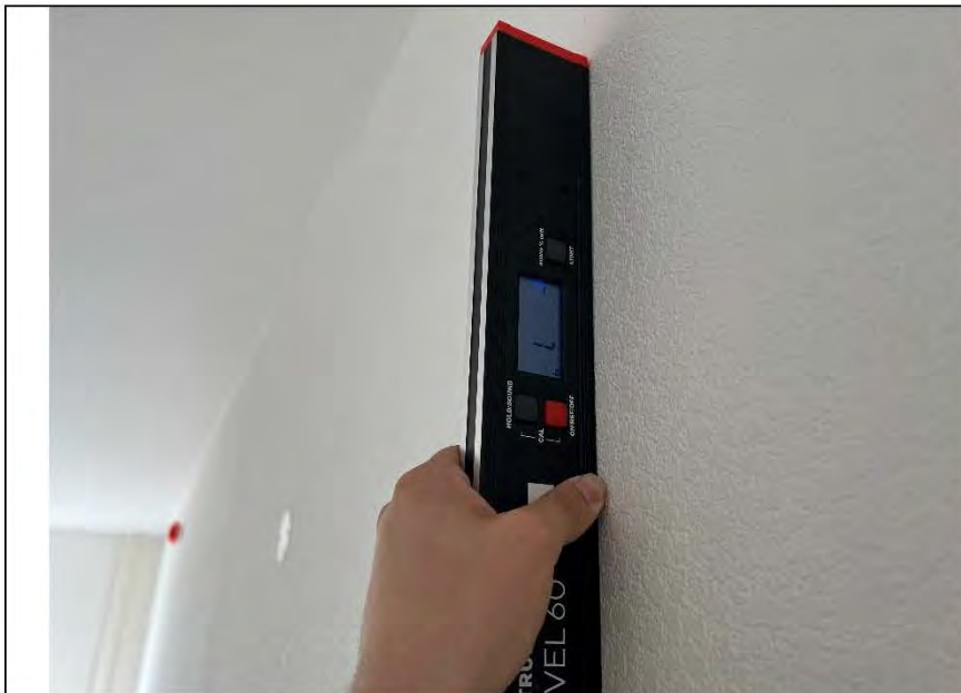
Фото №10. Измерение уровня стен в кухне.
