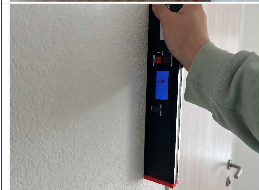
Фото №8. Измерение уровня стен в прихожей.
