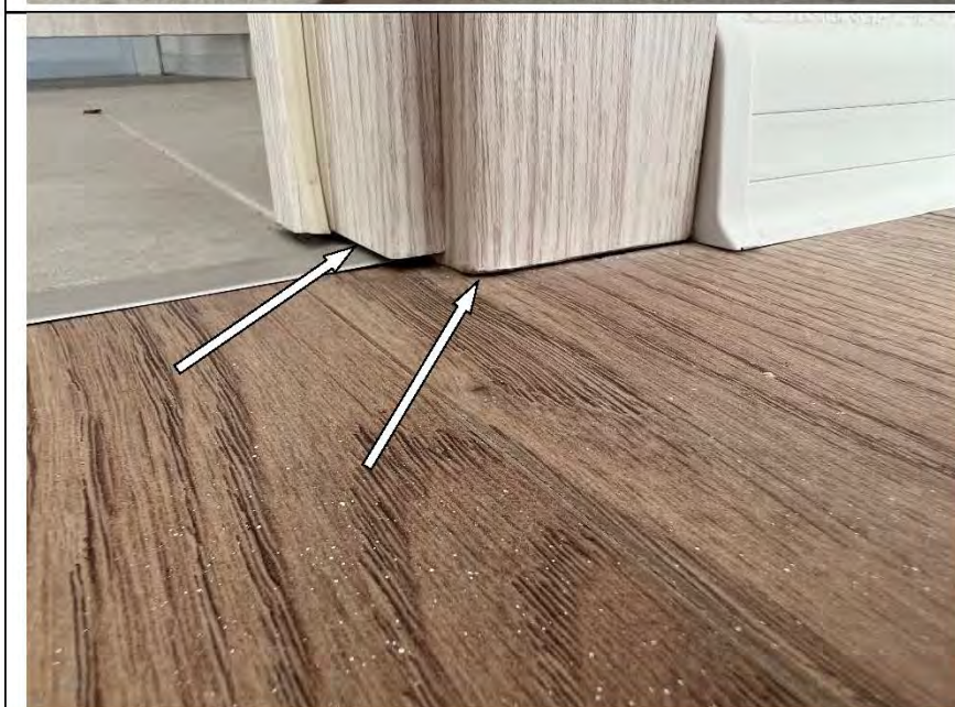
Фото № 53. Короткая подрезка наличников и дверного короба в спальне.
