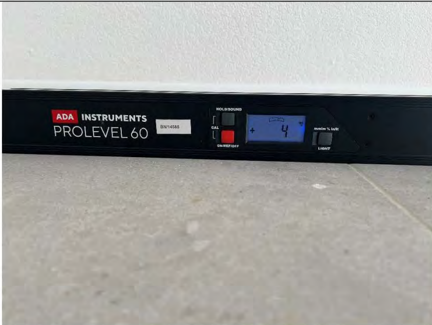
Фото №25. Измерение уровня напольного покрытия в кухне.
