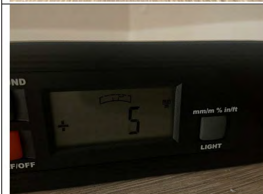
Фото №14. Отклонение поверхности напольного покрытия из ламината в кухне.
