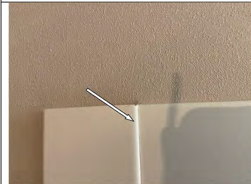
Фото №44. Дефект на наличниках деревянного дверного блока в спальне.
