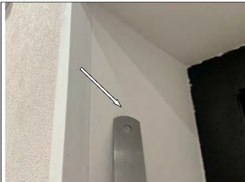
Фото №49. Неровности, выбоины, раковины на окрашенных откосах входного дверного блока в коридоре.
