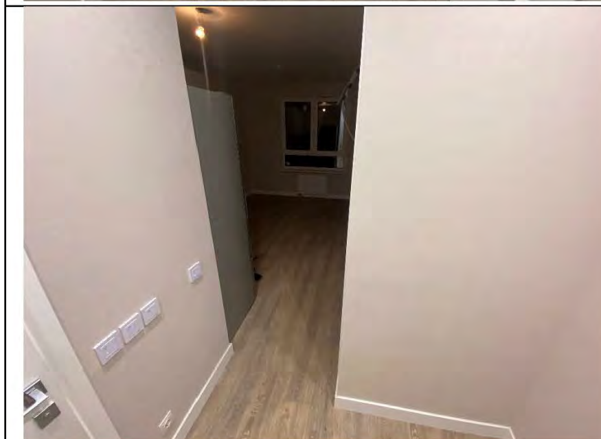
Фото №2. Общий вид коридора.
