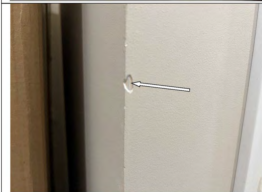
Фото №11. Скол краски на поверхности стен в прихожей.
