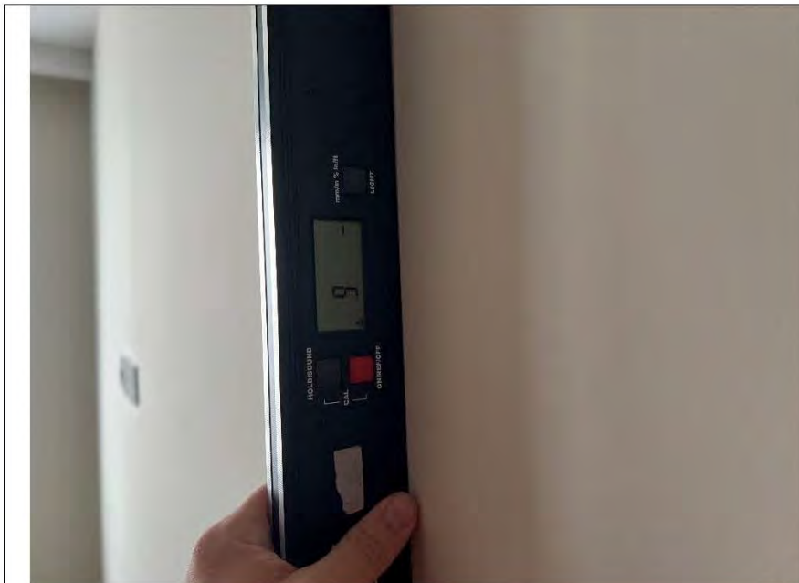
Фото №7. Измерение уровня стен в кухне.
