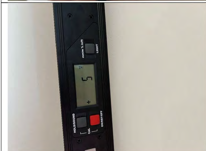
Фото №8. Измерение уровня стен в спальне.
