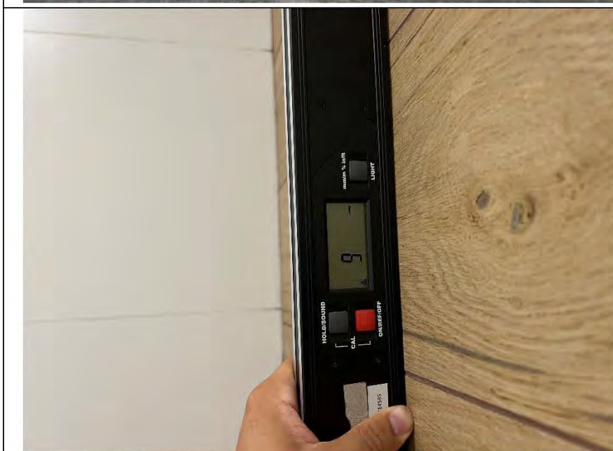
Фото №21. Измерение уровня стен в ванной комнате.
