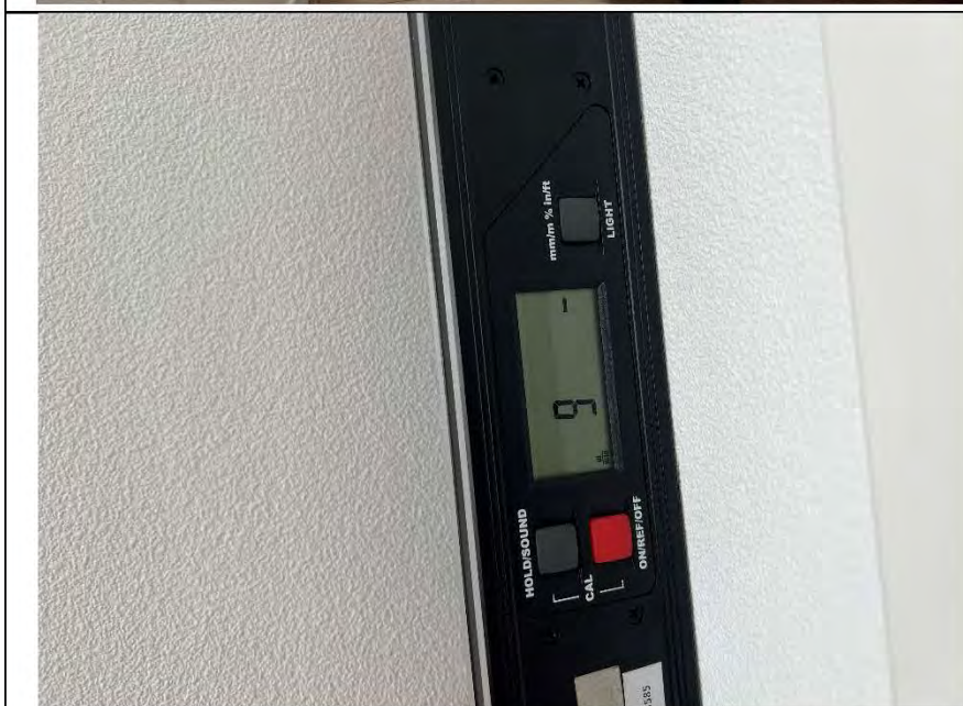
Фото №11. Измерение уровня стен в гостиной.
