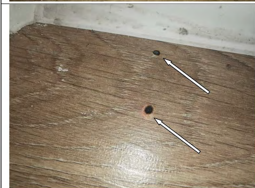
Фото №27. Повреждения (следы обжига) на поверхности напольного покрытия из ламината в кухне.
