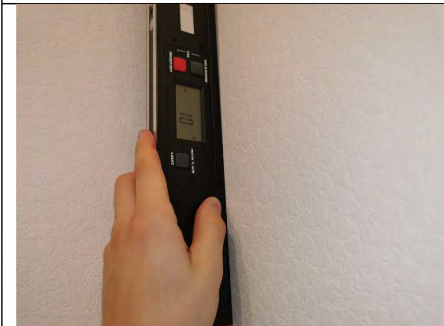
Фото №8. Измерение уровня стен в прихожей.
