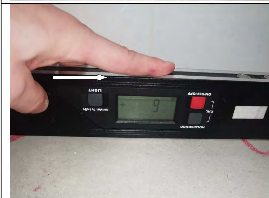
Фото №33. Измерение уровня пола в ванной комнате.
