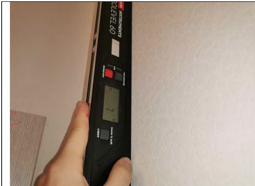
Фото №10. Измерение уровня стен в коридоре.
