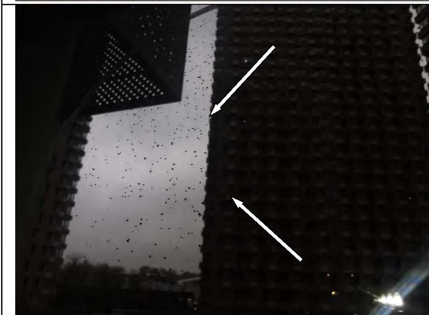
Фото №54. Окалины на стеклопакете оконного блока в спальне.
