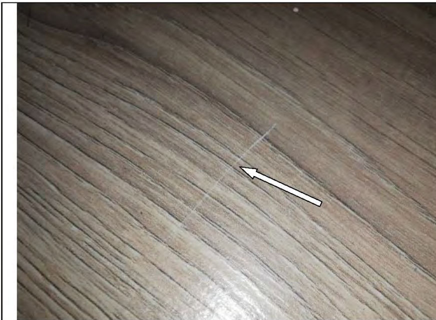
Фото №28. Царапины на поверхности напольного покрытия из ламината в спальне.
