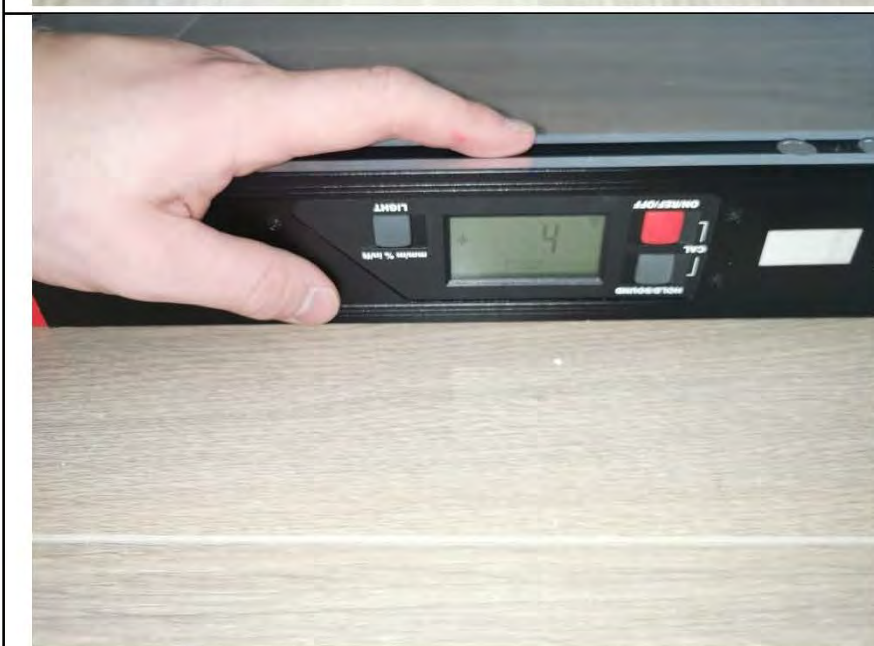
Фото №24. Измерение уровня пола в спальне.
