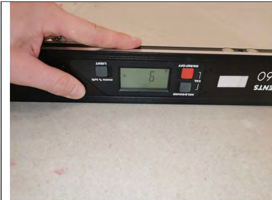
Фото №31. Измерение уровня пола в кухне.
