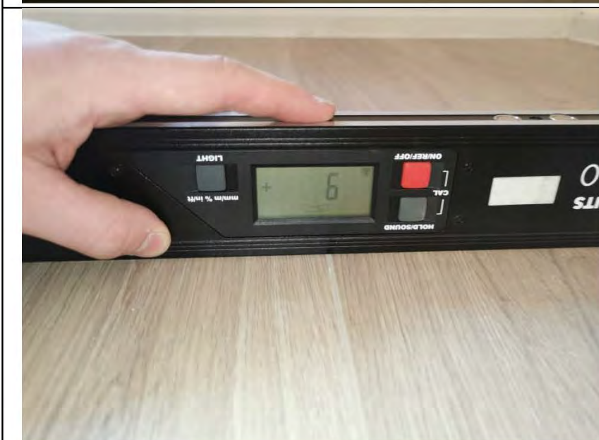
Фото №23. Измерение уровня пола в кухне.
