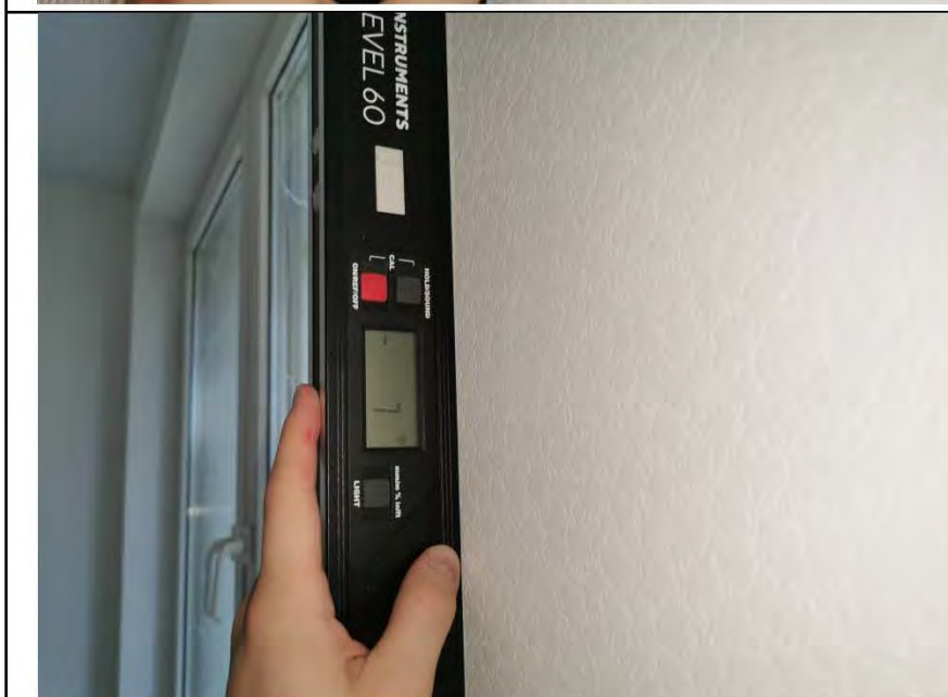
Фото №11. Измерение уровня стен в спальне.
