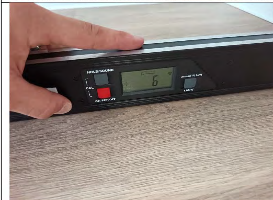
Фото №23. Измерение уровня пола в спальне.
