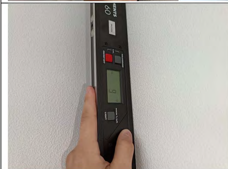
Фото №12. Измерение уровня стен в спальне.
