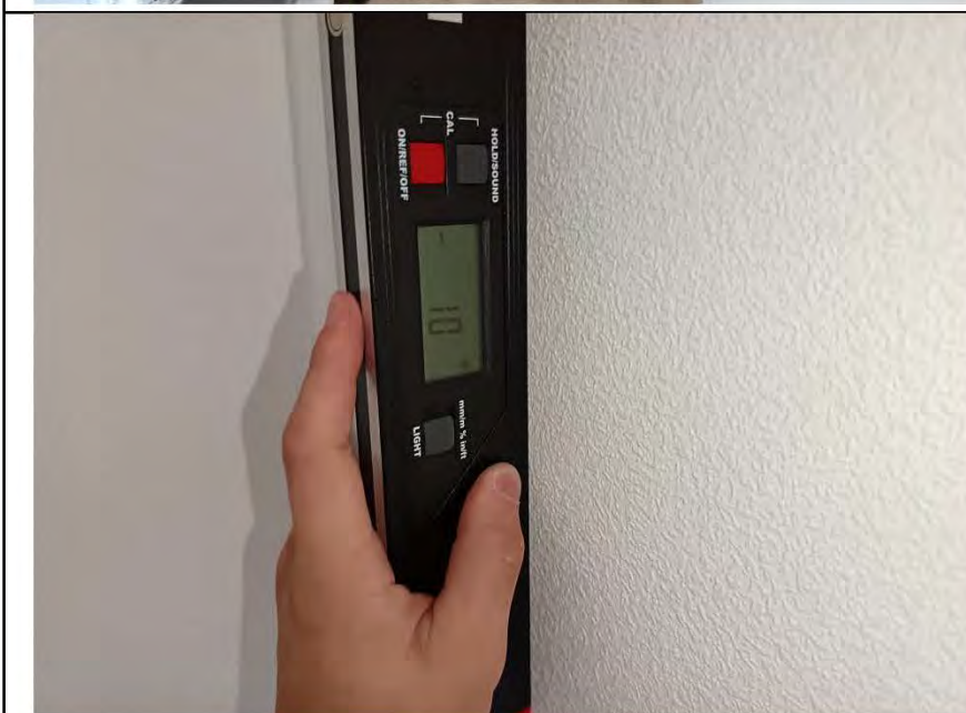
Фото №8. Измерение уровня стен в коридоре.
