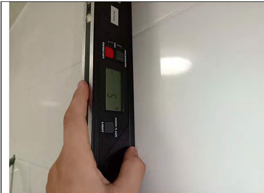
Фото №13. Измерение уровня стен в санузле.
