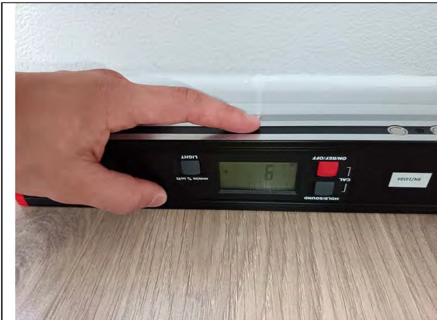
Фото №22. Измерение уровня пола в кухне.
