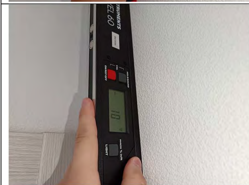
Фото №9. Измерение уровня стен в коридоре.
