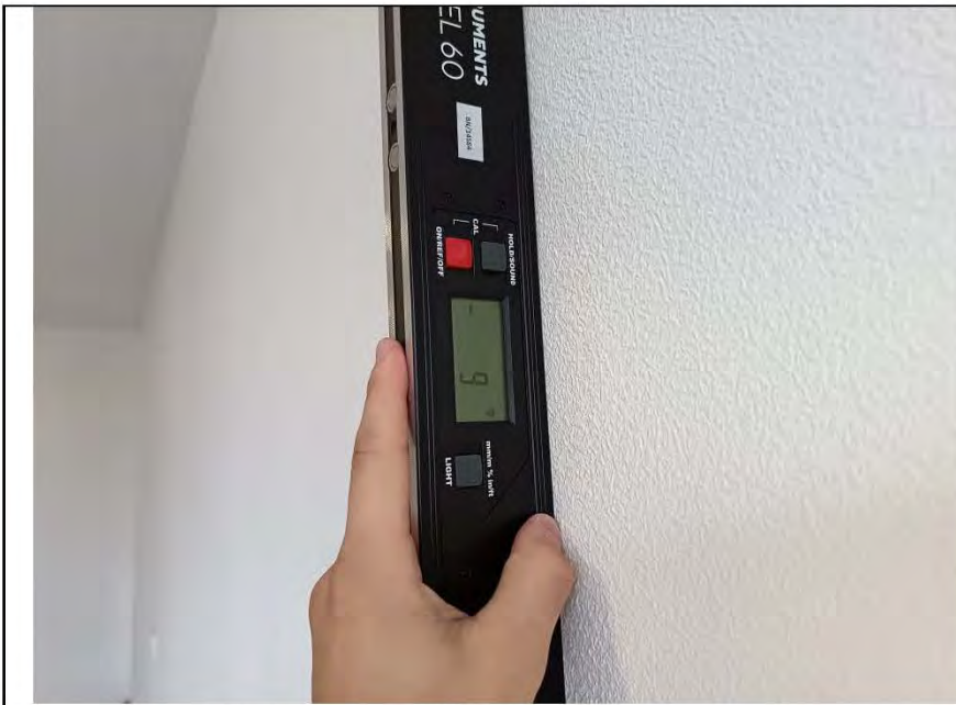
Фото №10. Измерение уровня стен в кухне.
