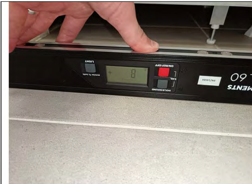
Фото №25. Измерение уровня пола в санузле.
