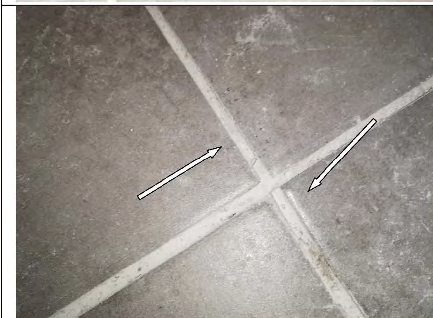
Фото №23. Измерение уровня пола на балконе.
