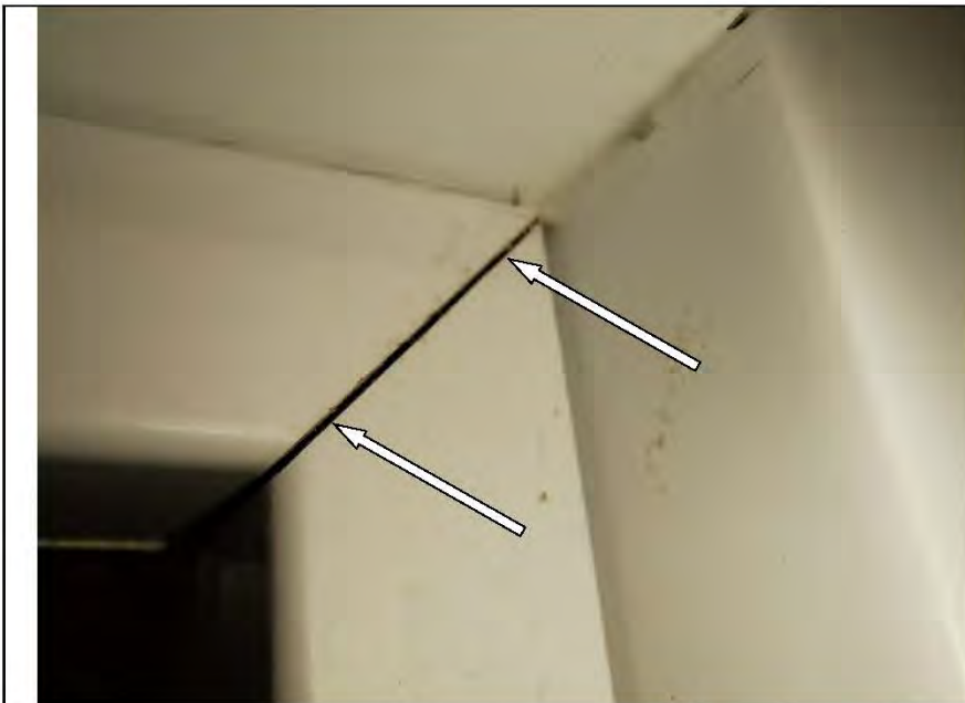
Фото №43. Ненадежное соединение элементов короба деревянного дверного блока в санузле.
