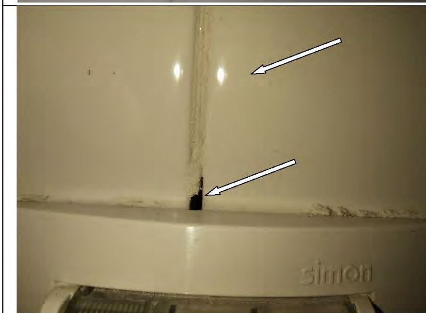
Фото №15. Читаемые обоечные стыки в кухне-гостиной.
