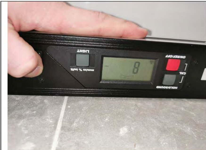
Фото №22. Измерение уровня пола в санузле.
