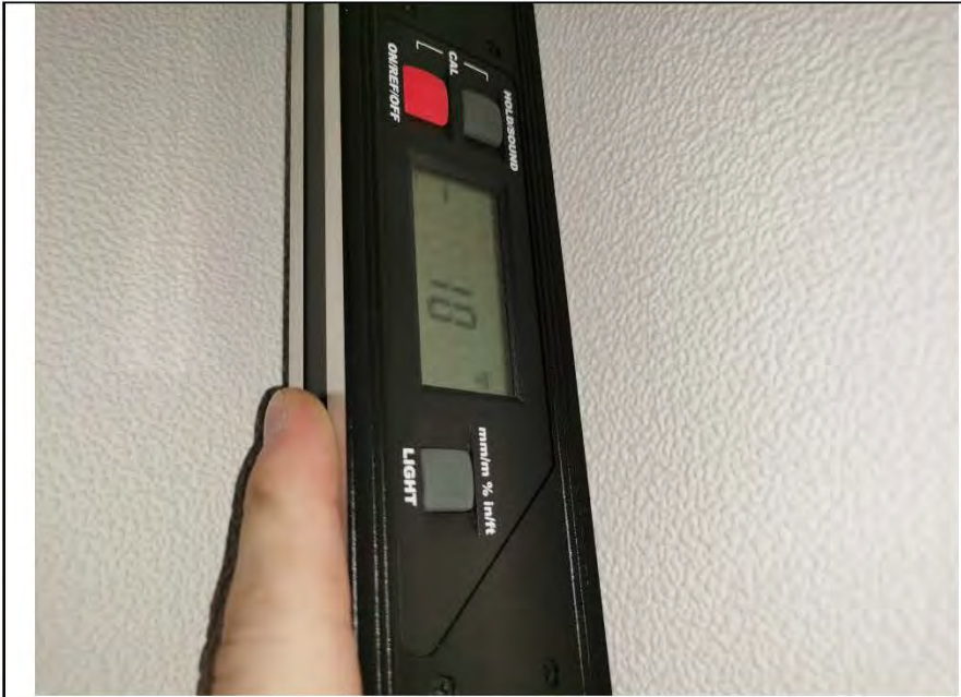
Фото №7. Измерение уровня стен в коридоре.
