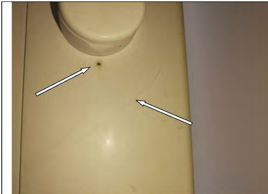
Фото №28. Царапины и окалины на профиле ПВХ оконного блока в комнате.
