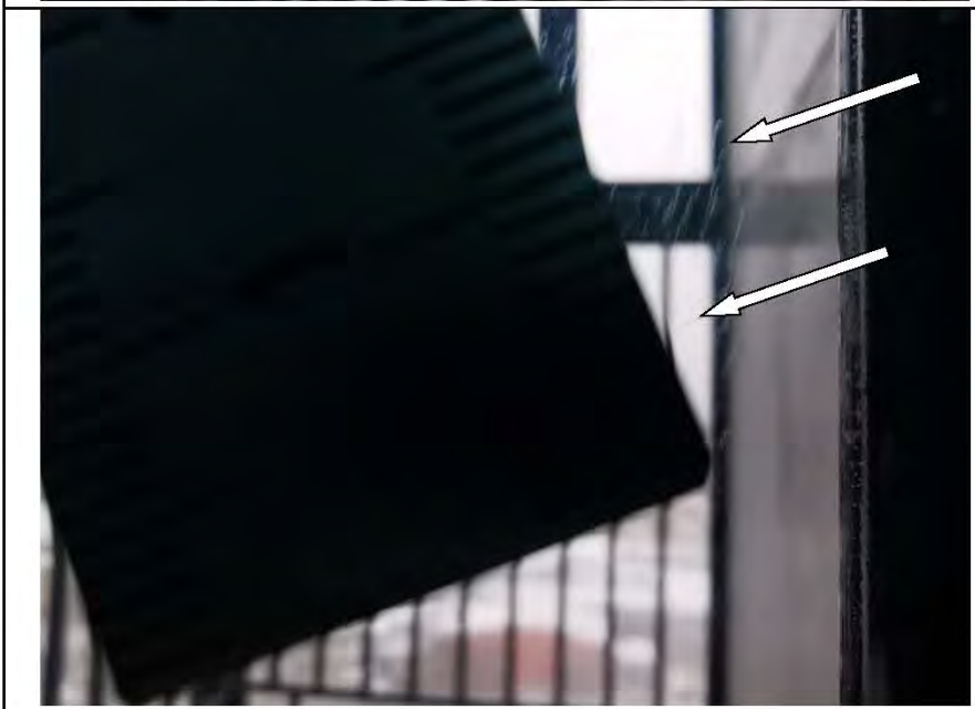
Фото №33. Царапины на стеклопакете дверного блока ПВХ в комнате.
