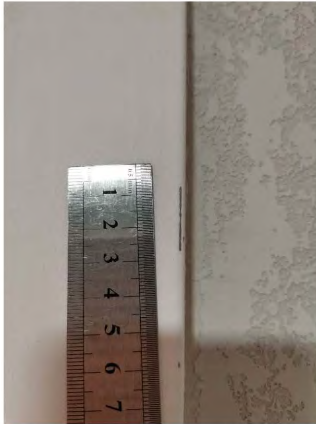
Фото 8-10. Коридор 1.2 На входной двери имеются царапины, сколы
