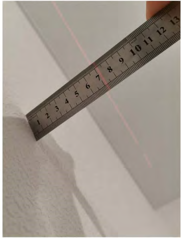
Фото 31, 32. Кухня-Комната 3.2 Отклонения участка стены от вертикали 8 мм
