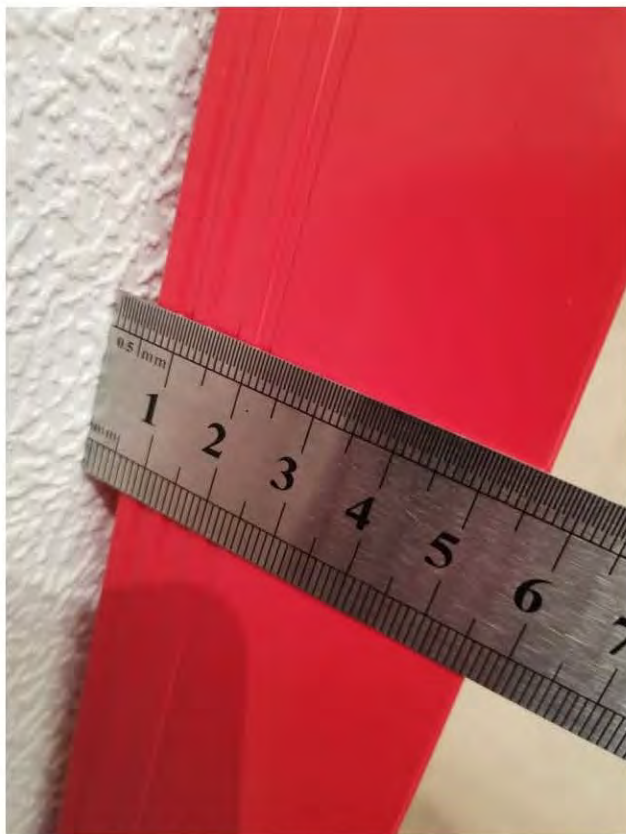
Фото 47-50. Гардеробная 4.2 Отклонения участков стен от горизонтали 4,5 мм, 5 мм, 6 мм, 5 мм
