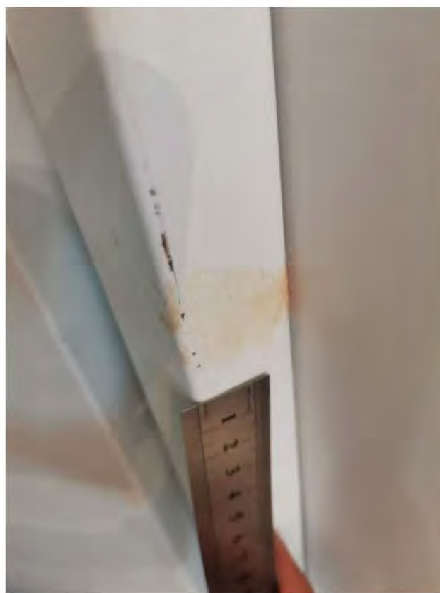
Фото 7. Коридор 1.1 Дверной блок имеет отклонение от вертикали 5 мм
