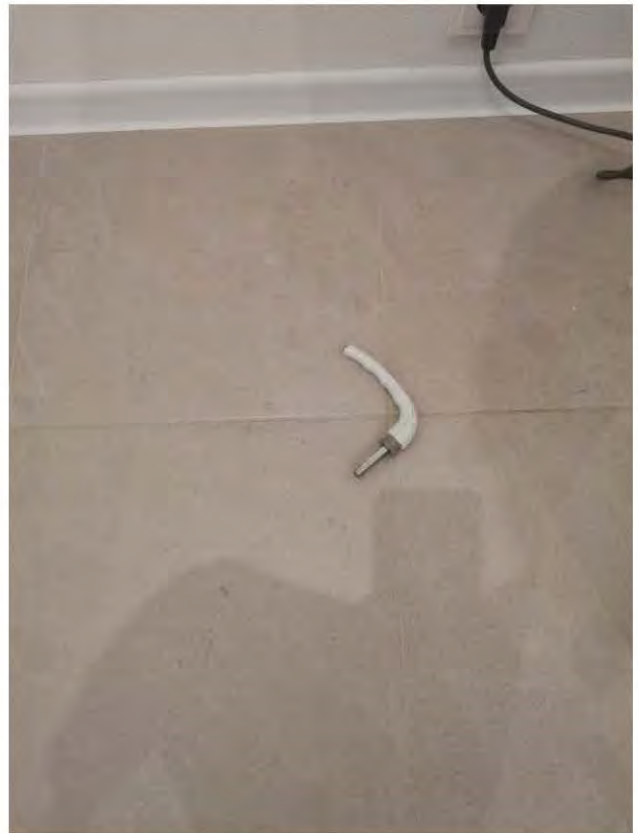
Фото 33, 34. Кухня-Комната 3.3 Изменение характера звука при простукивании плитки (пустоты)
