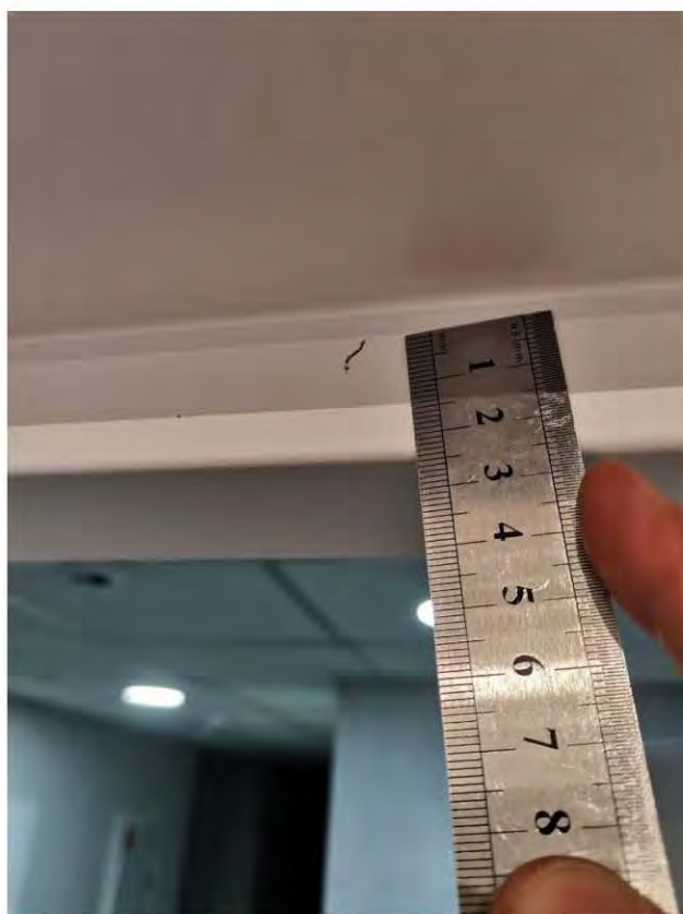
Фото 7. Коридор 1.1 Дверной блок имеет отклонение от вертикали 5 мм
