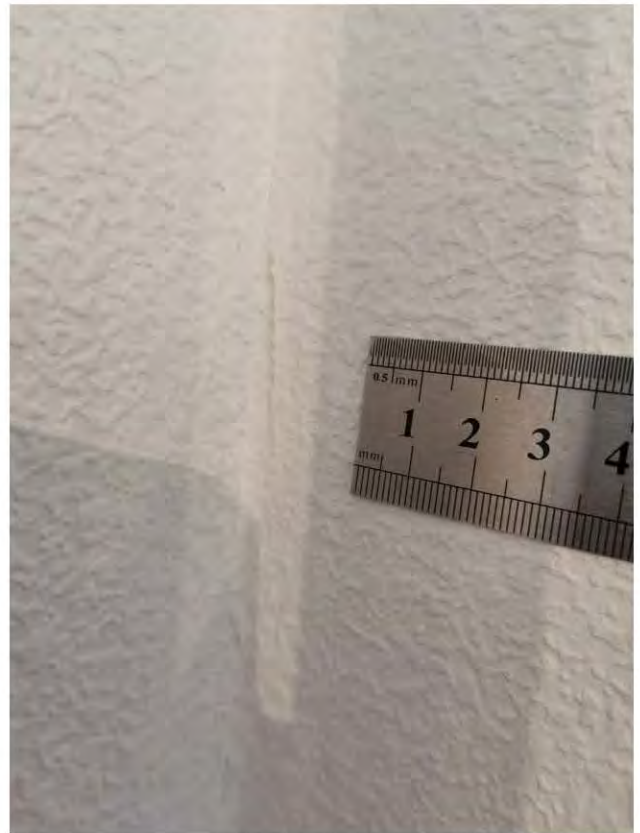
Фото 8-10. Коридор 1.2 На входной двери имеются царапины, сколы
