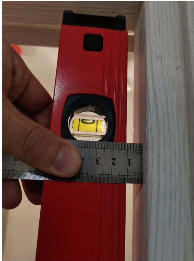
Фото 19. Санузел 2.1 Дверной блок имеет отклонение от вертикали 10,5 мм
