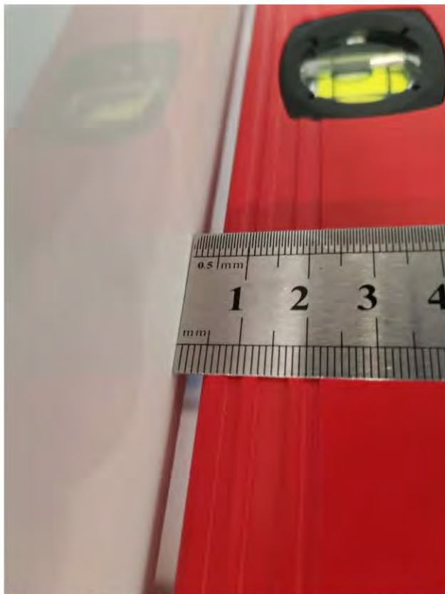
Фото 23, 24. Санузел 2.3 Отклонение настенной плитки от плоскости на участках стен 5 мм, 5 мм
