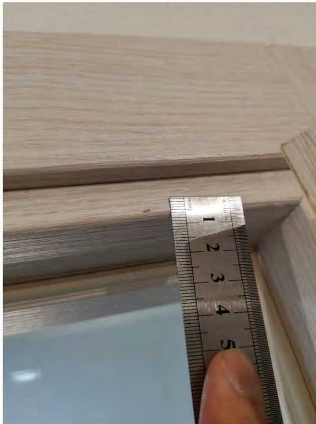
Фото 19. Санузел 2.1 Дверной блок имеет отклонение от вертикали 10,5 мм
