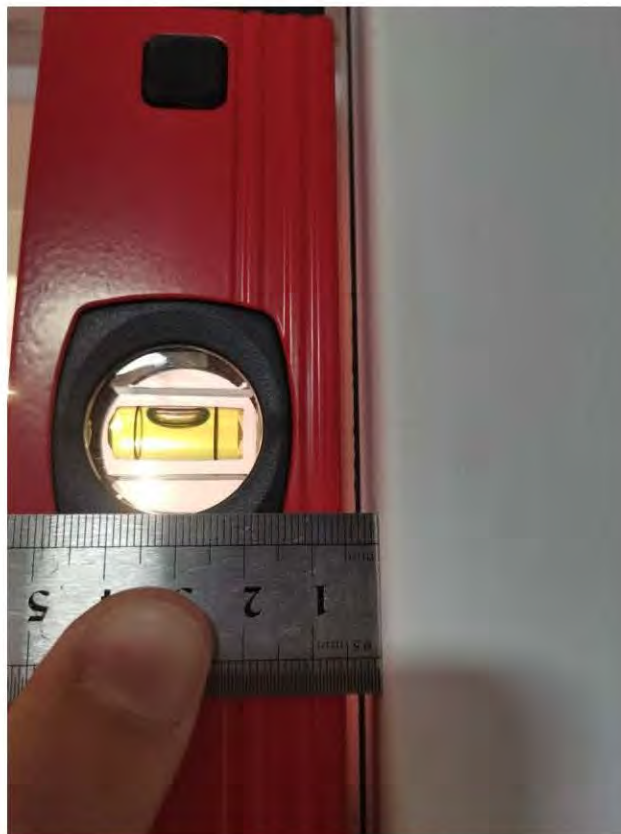
Фото 7. Коридор 1.1 Дверной блок имеет отклонение от вертикали 5 мм
