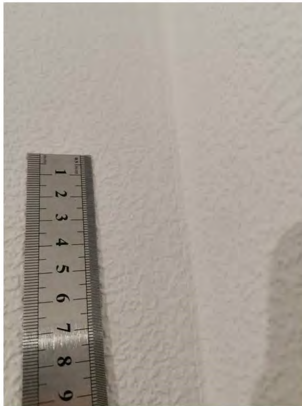
Фото 11-13. Коридор 1.3 Локальные участки имеют: замятины, пятна, загрязнения, отслоения обоев
