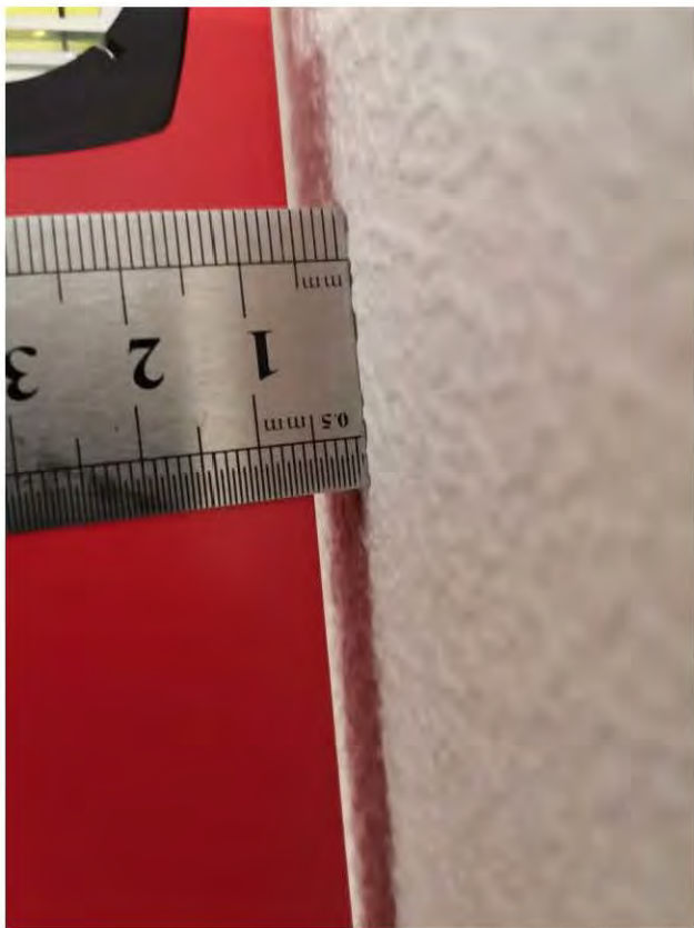
Фото 11-13. Коридор 1.3 Локальные участки имеют: замятины, пятна, загрязнения, отслоения обоев
