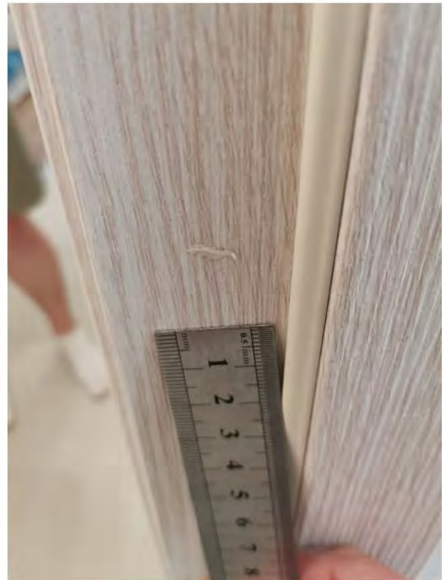
Фото 19. Санузел 2.1 Дверной блок имеет отклонение от вертикали 10,5 мм
