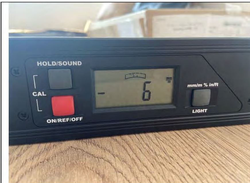
Фото №22. Неровные швы напольной керамической плитки в ванной комнате.
