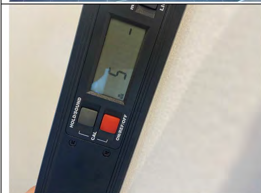
Фото №8. Измерение уровня стен в спальне.
