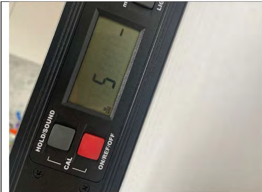
Фото №10. Измерение уровня стен в ванной комнате.
