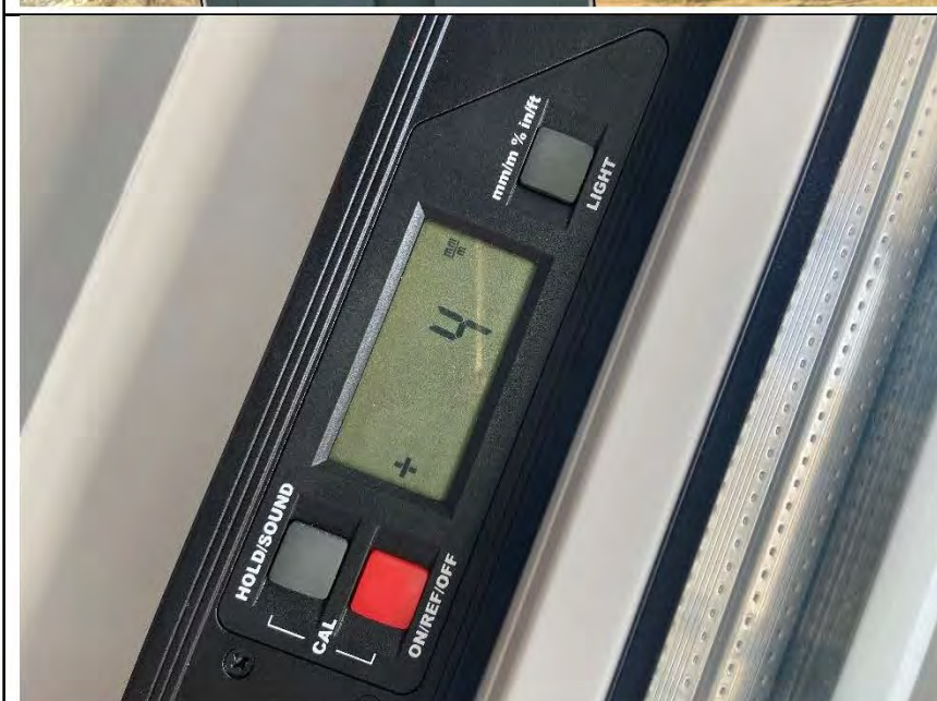
Фото №54. Скол на наличнике входного дверного блока в коридоре.
