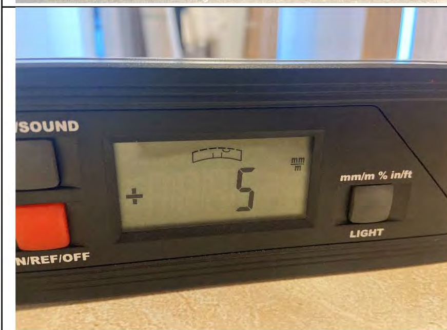
Фото №18. Отклонения напольного покрытия из ламината в спальне.
