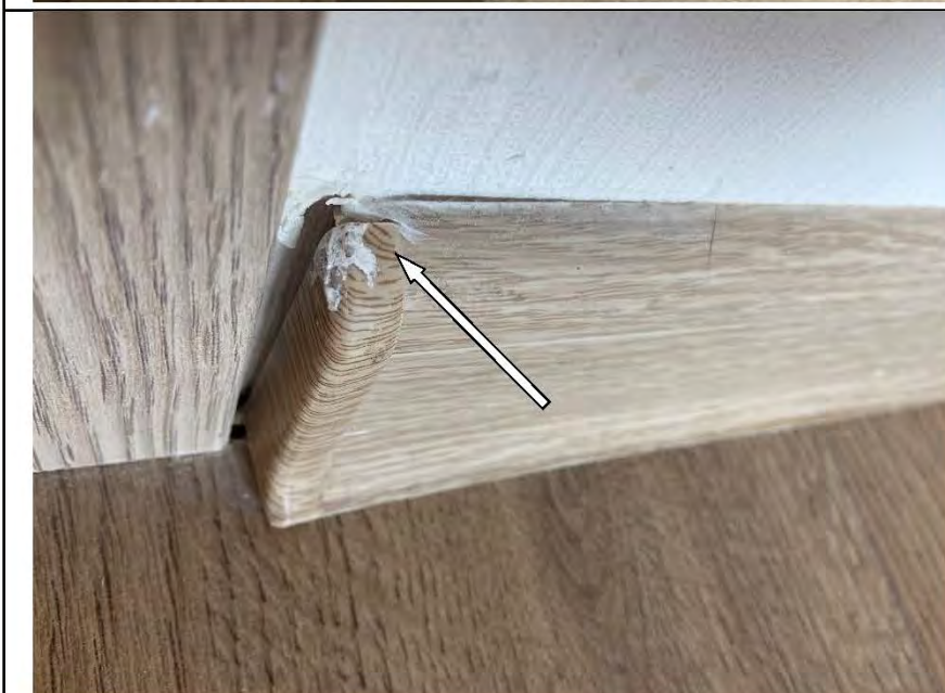
Фото №36. Неровности, выбоины, раковины на окрашенных откосах оконного блока ПВХ в кухне.
