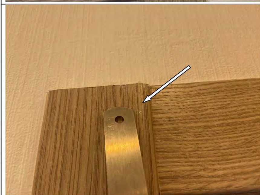
Фото №63. Дефект вставки труб отопления в напольное покрытие из ламината в спальне.
