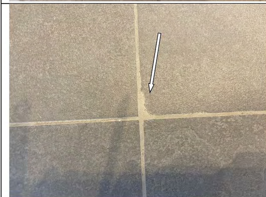
Фото №30. Царапины на напольном металлическом порошке в коридоре.
