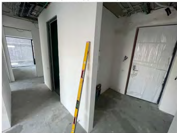
Фото №2. Общий вид помещения.
