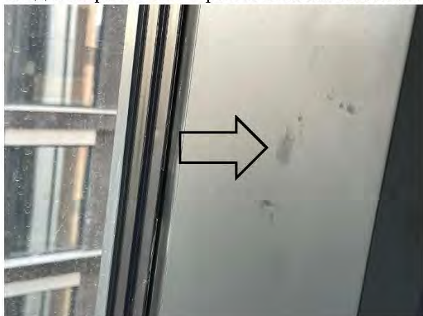
Фото №21. Оконные блоки из алюминиевых профилей имеют царапины, следы загрязнения строительными смесями.
