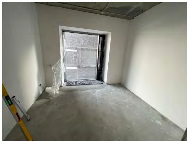
Фото №6. Стены, шпатлевочные работы, выполнены с нарушениями, имеют царапины, раковины, следы от инструмента.
