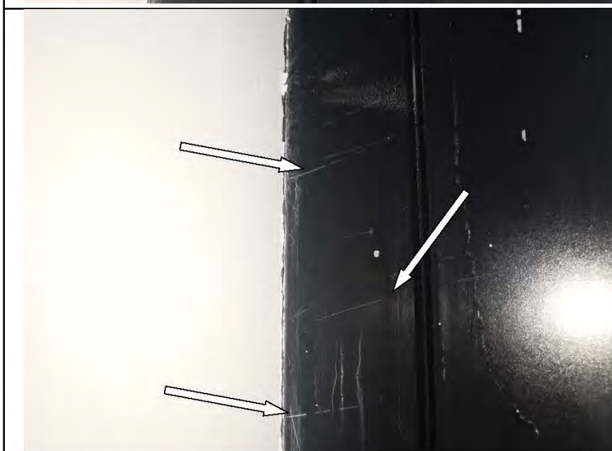
Фото №36. Царапины на профиле металлического оконного блока в кухне.
