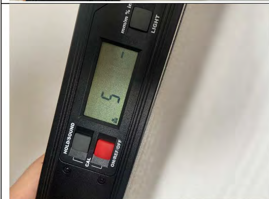
Фото №11. Отклонение поверхности стен от вертикали в кабинете.
