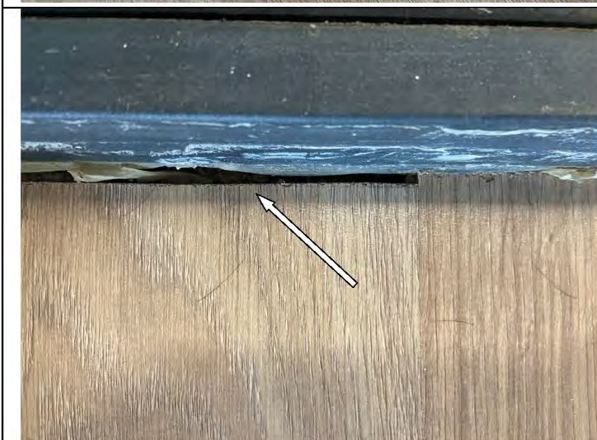
Фото №38. Коротко подрезан ламинат на стыке элементов в коридоре.
