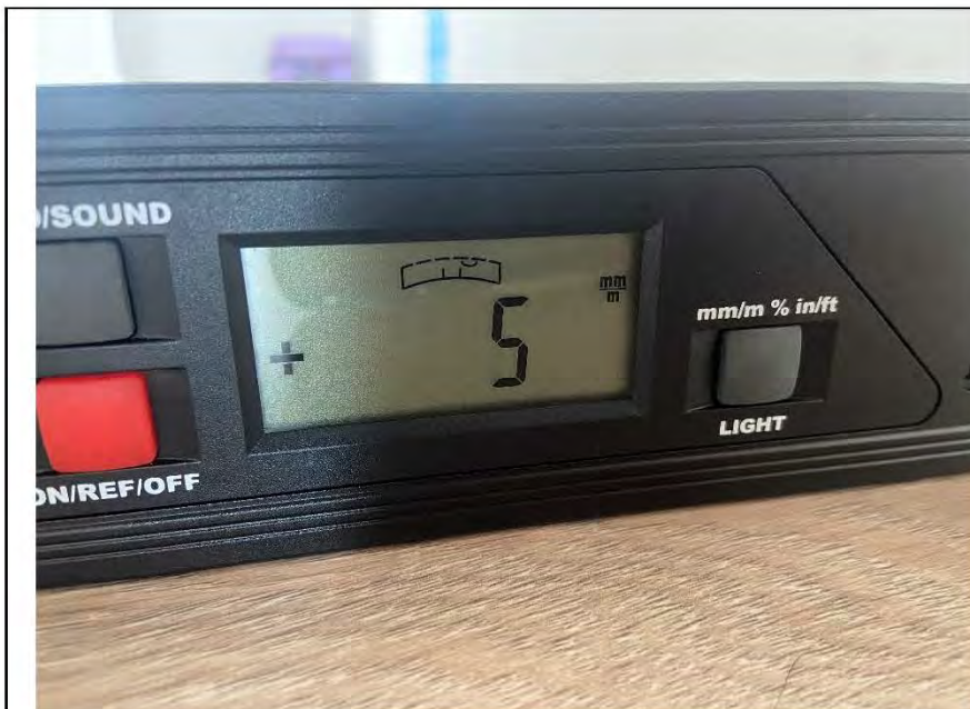
Фото №19. Отклонение поверхности напольного покрытия из ламината в коридоре.
