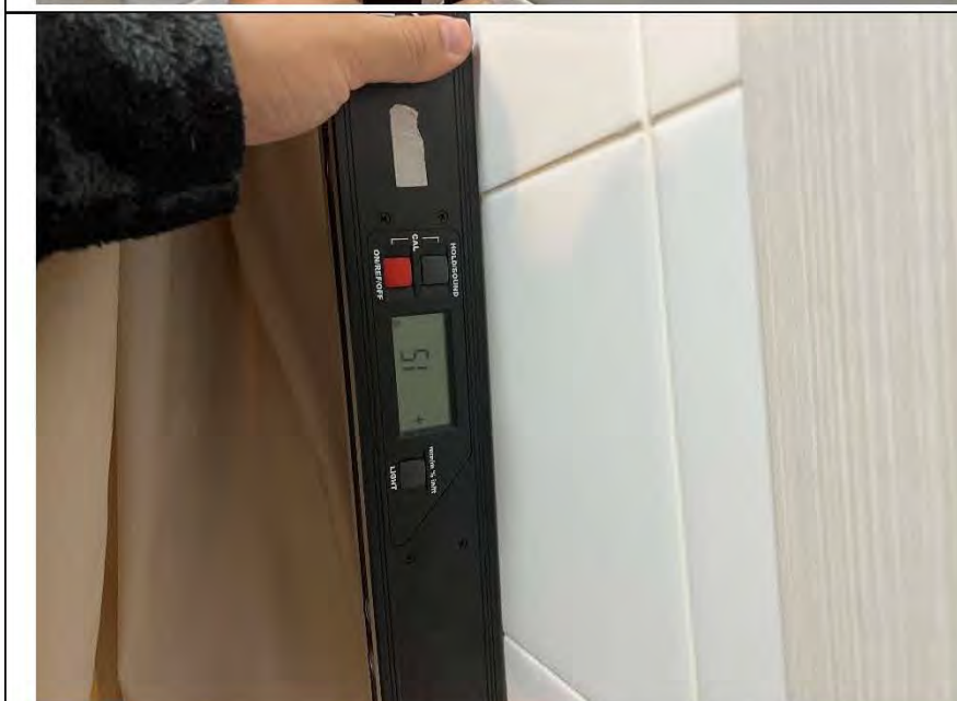
Фото №24. Измерение уровня стен в ванной комнате.
