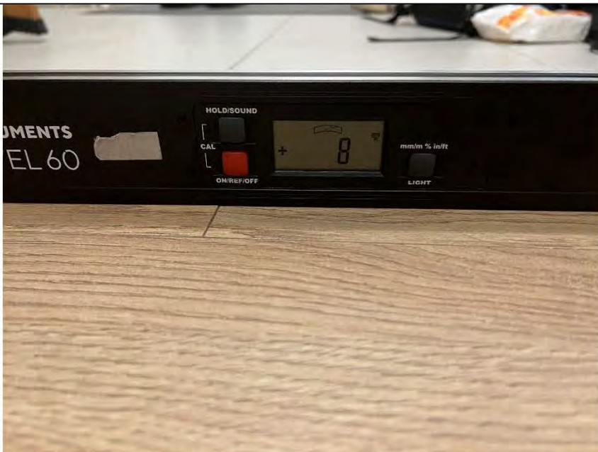
Фото №28. Измерение уровня напольного покрытия в коридоре.
