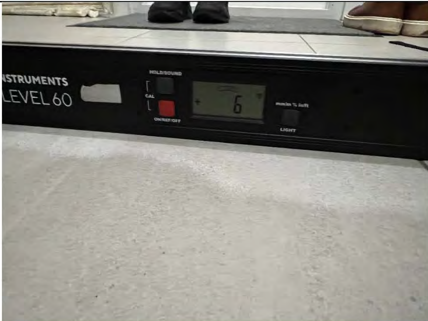
Фото №32. Измерение уровня напольного покрытия в коридоре.
