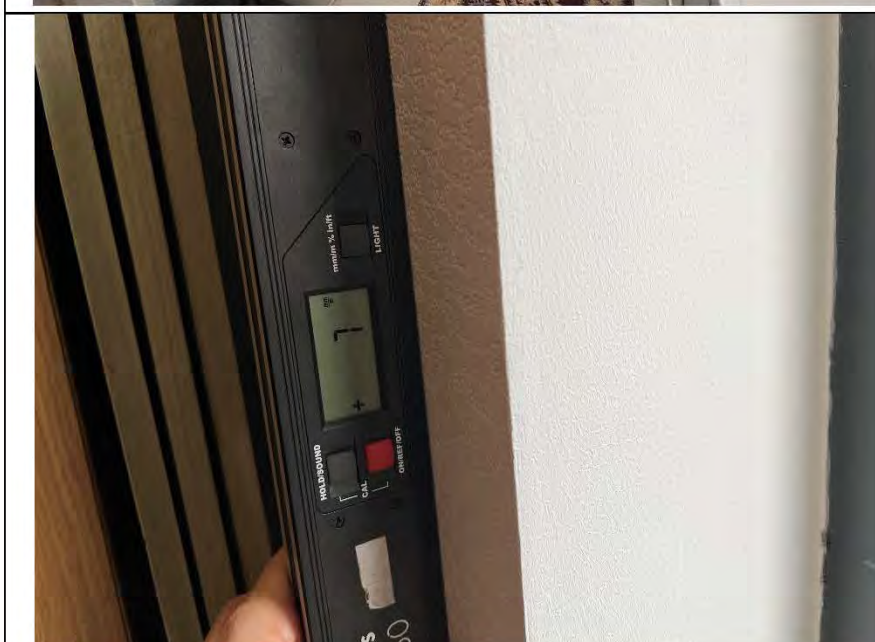
Фото №11. Измерение уровня стен в спальне.
