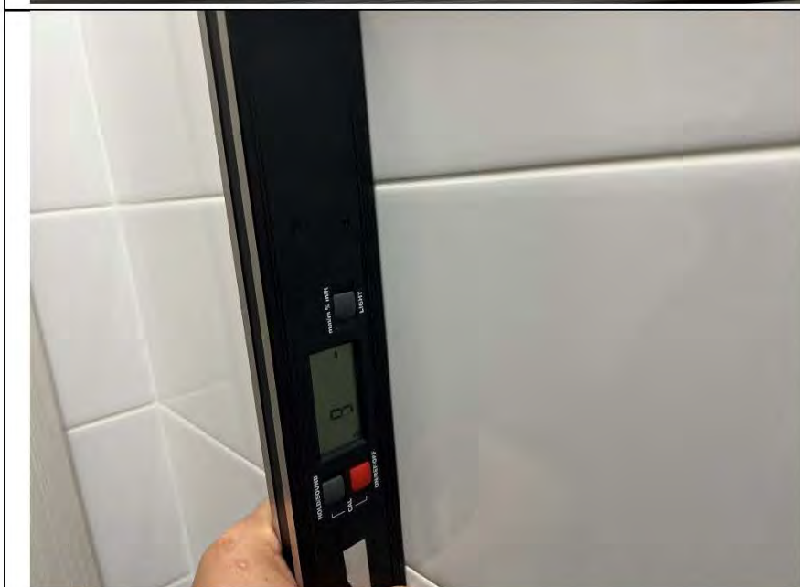
Фото №23. Измерение уровня стен в санузле.
