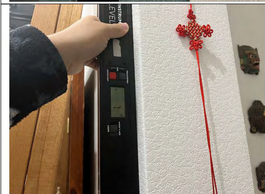
Фото №14. Измерение уровня стен в коридоре.
