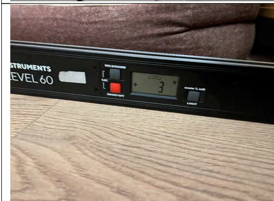
Фото №26. Измерение уровня напольного покрытия в спальне.
