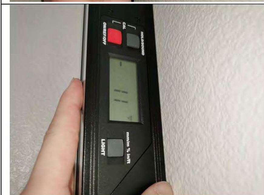
Фото №21. Измерение уровня стен в кухне.
