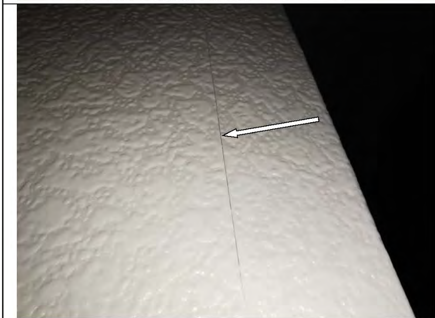
Фото №27. Читаемые обойные стыки в коридоре.
