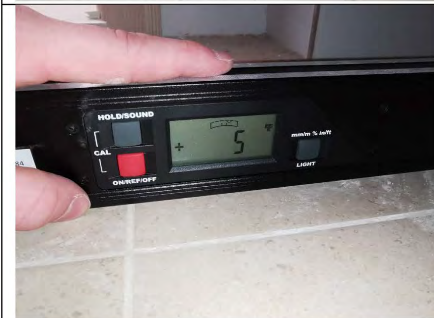
Фото №68. Измерение уровня пола в ванной комнате
