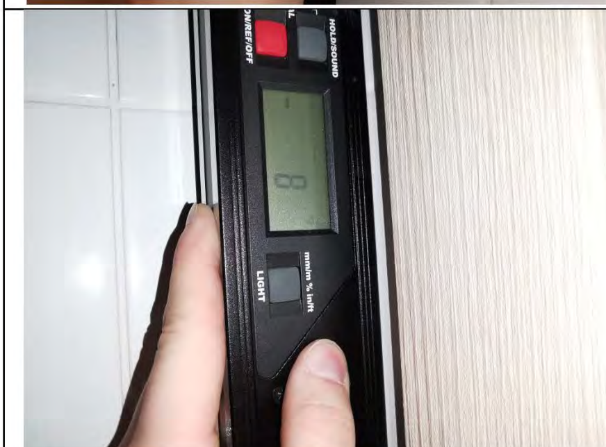
Фото №38. Измерение уровня стен в ванной комнате.
