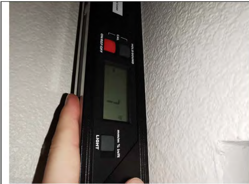
Фото №16. Измерение уровня стен в прихожей.
