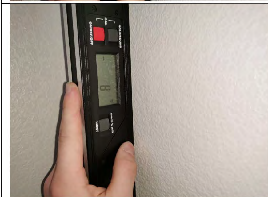
Фото №20. Измерение уровня стен в кухне.
