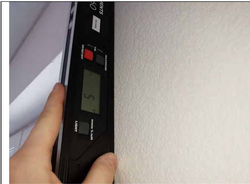
Фото №22. Измерение уровня стен в спальне.
