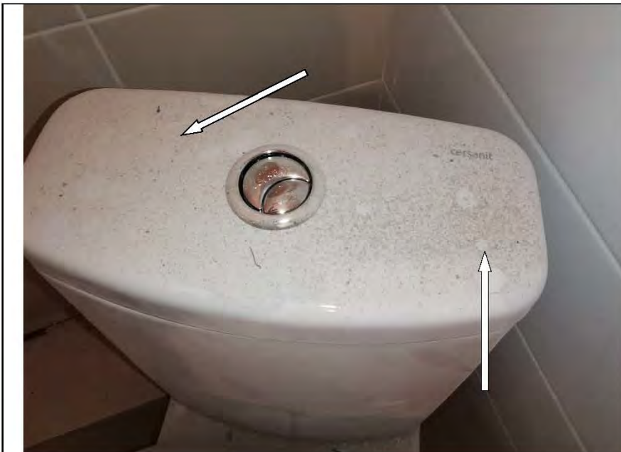
Фото №139. Загрязнение сантехнических приборов в санузле.
