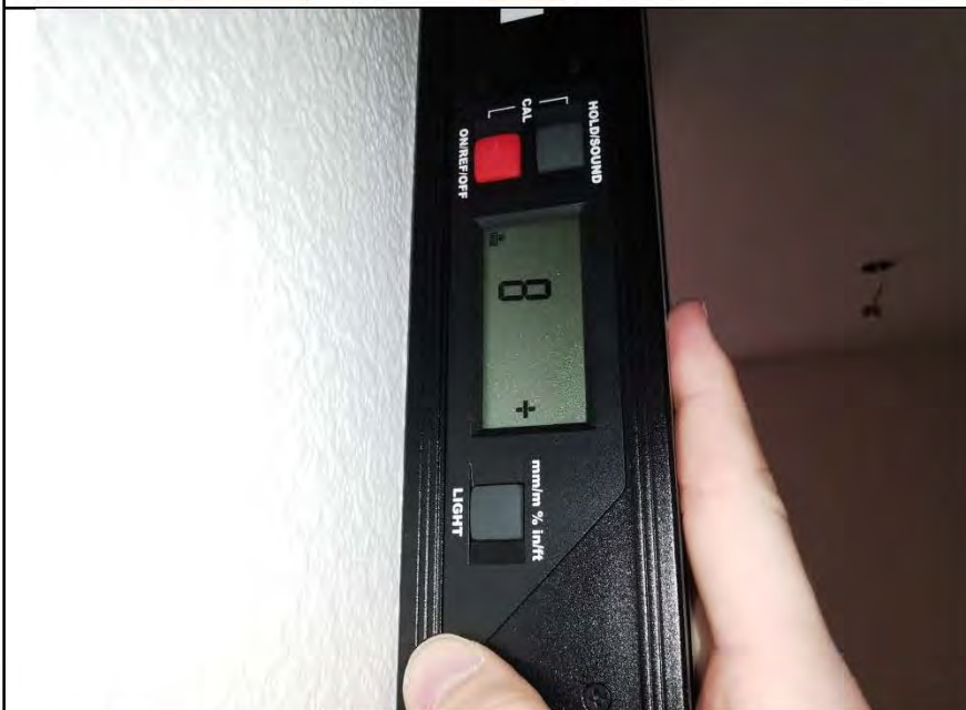
Фото №17. Измерение уровня стен в прихожей.
