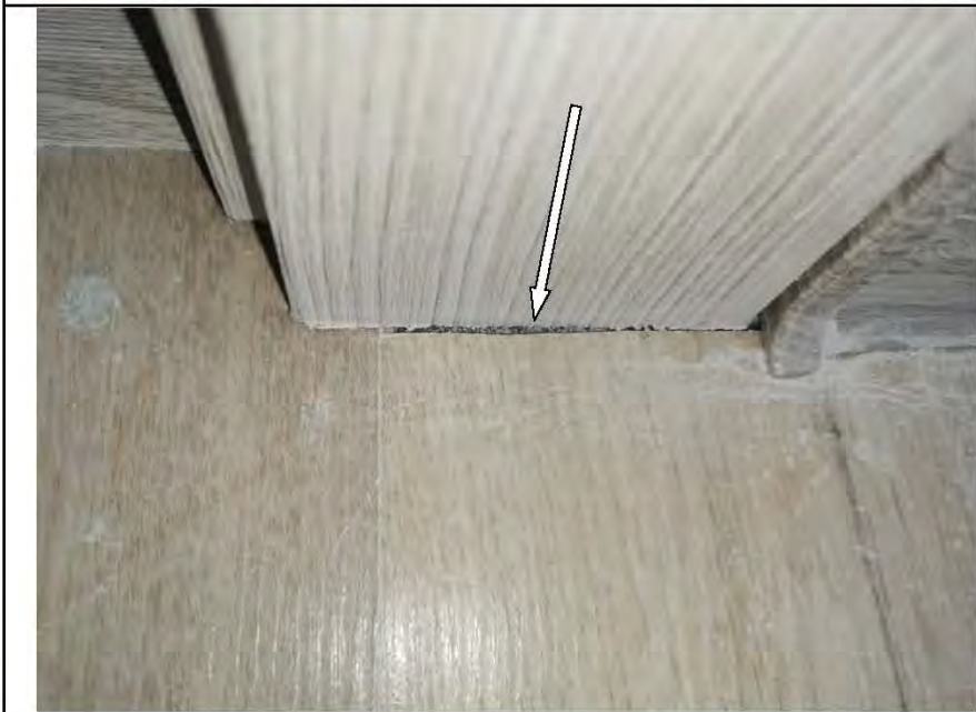
Фото №65. Коротко подрезан ламинат на стыке элементов в спальне.
