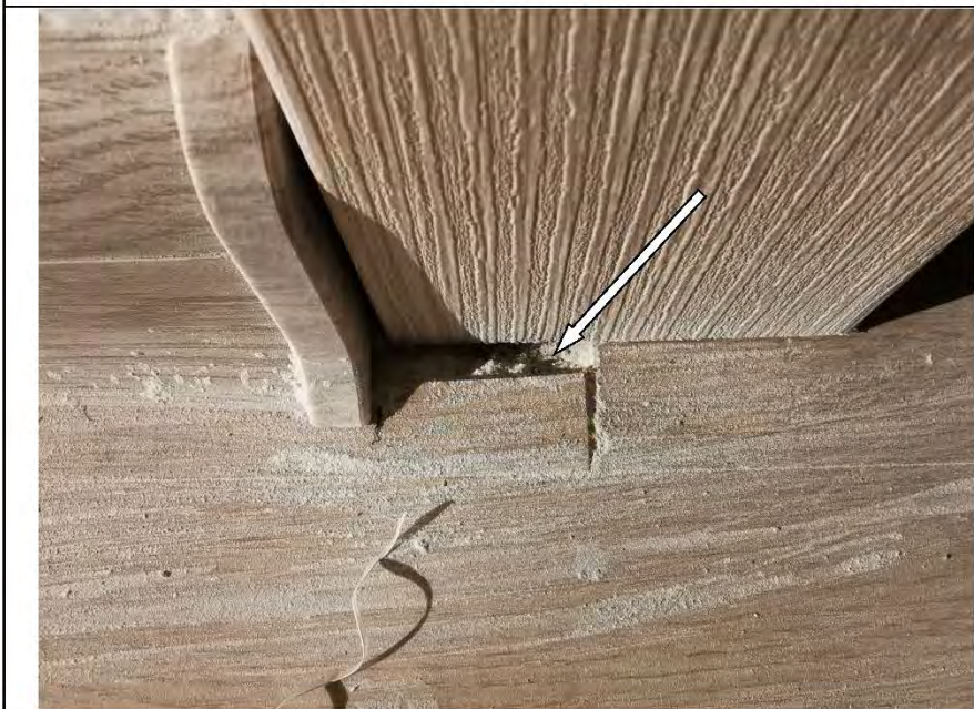
Фото №66. Коротко подрезан ламинат на стыке элементов в детской.
