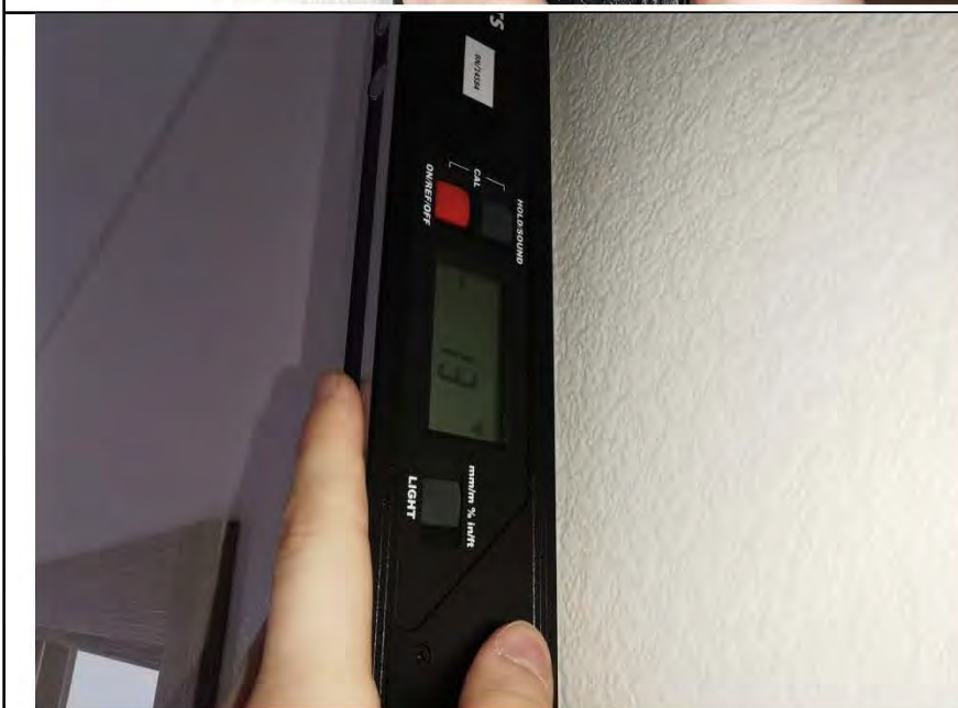
Фото №18. Измерение уровня стен в коридоре.
