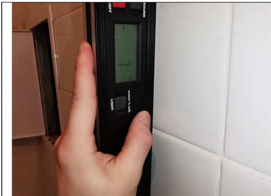
Фото №37. Измерение уровня стен в санузле.
