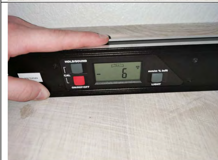
Фото №47. Измерение уровня пола в кухне.
