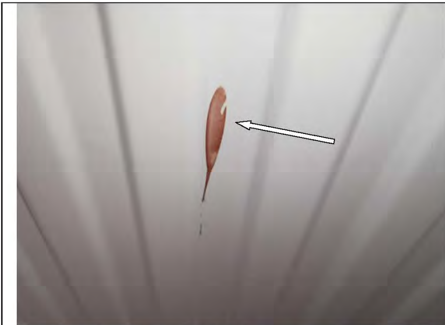
Фото №136. Загрязнение на радиаторе в спальне.
