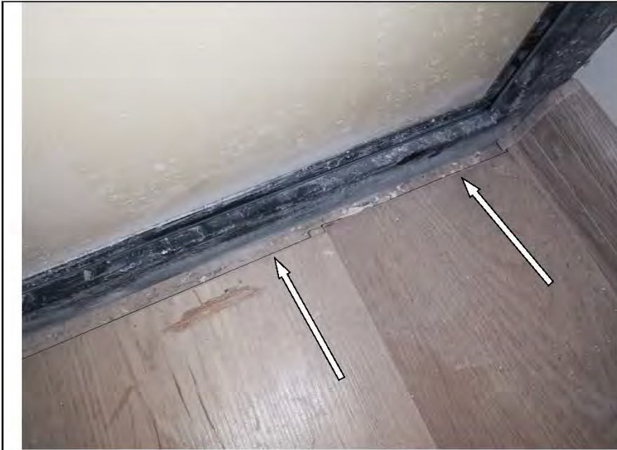
Фото №64. Коротко подрезан ламинат на стыке элементов в прихожей.
