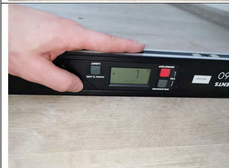
Фото №48. Измерение уровня пола в спальне.
