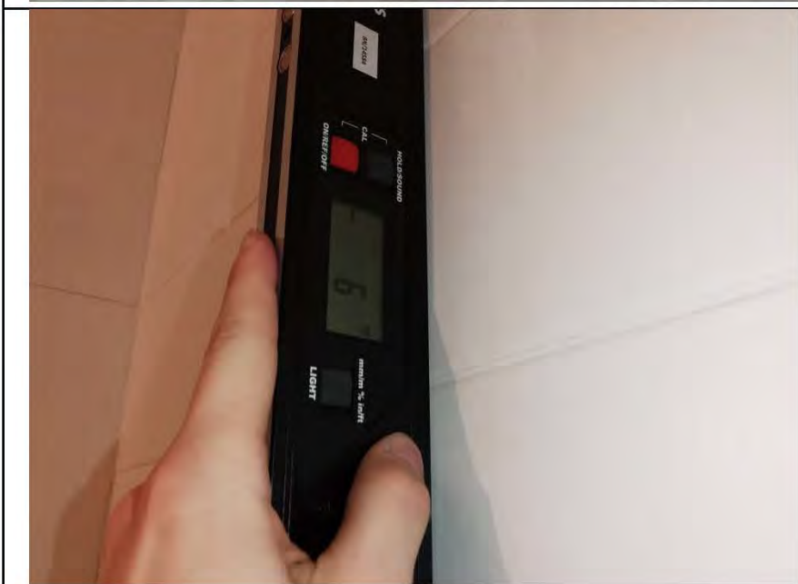
Фото №36. Измерение уровня стен в санузле.
