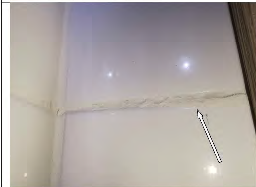
Фото №41. Неравномерное заполнение шовного пространства настенной керамической плитки затирочным составом в ванной комнате.
