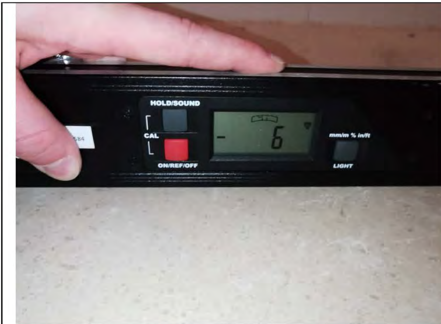
Фото №67. Измерение уровня пола в санузле
