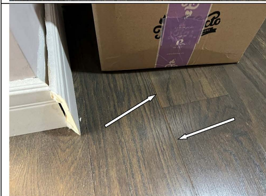
Фото №8. Вздутие и поднятые кромки паркетных досок в гардеробной.
