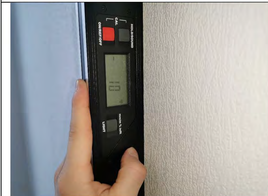
Фото №14. Измерение уровня стен в спальне.
