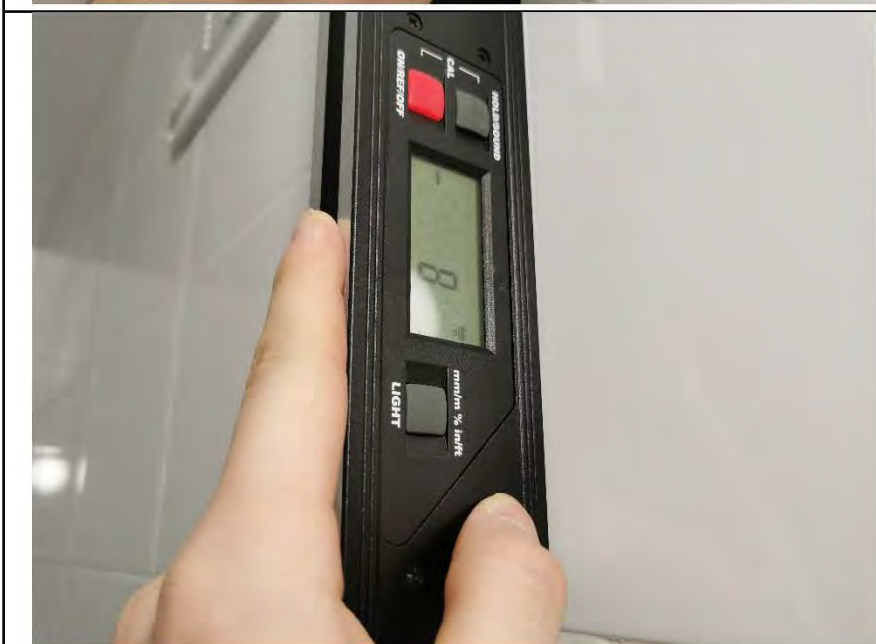
Фото №18. Измерение уровня стен в ванной комнате.
