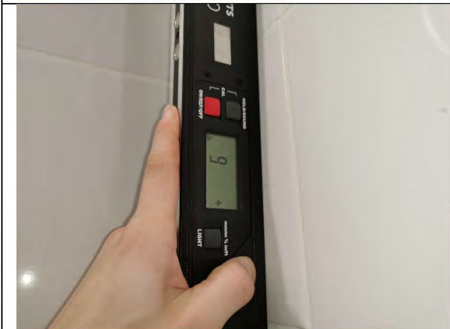
Фото №17. Измерение уровня стен в санузле.
