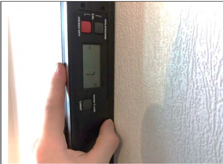
Фото №16. Измерение уровня стен в кухне.
