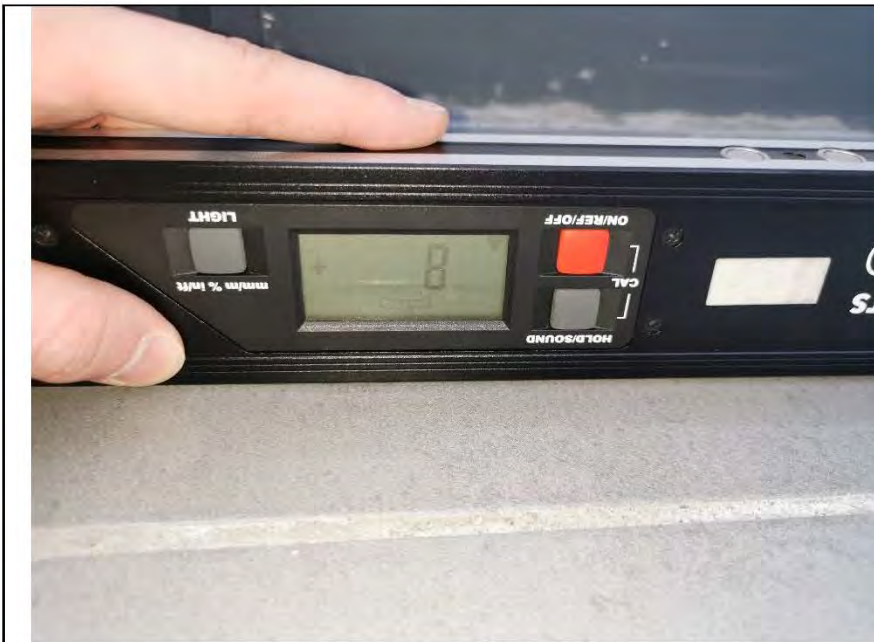
Фото №79. Измерение уровня пола на лоджии.
