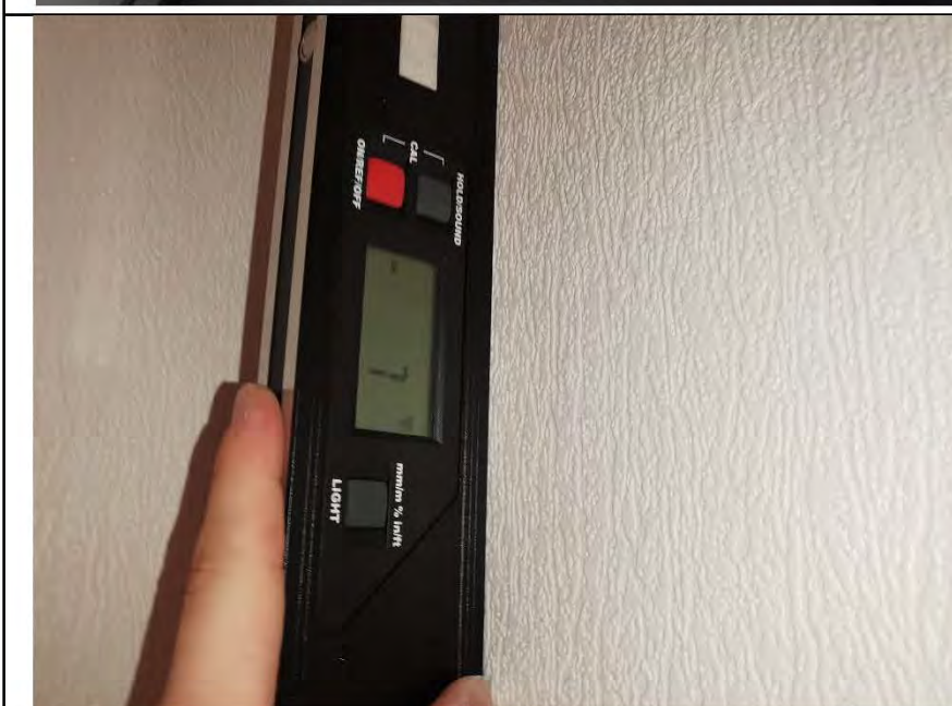
Фото №12. Измерение уровня стен в коридоре.
