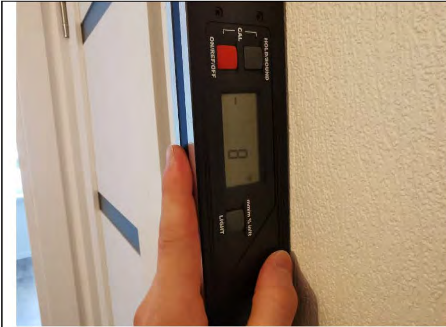
Фото №13. Измерение уровня стен в коридоре.
