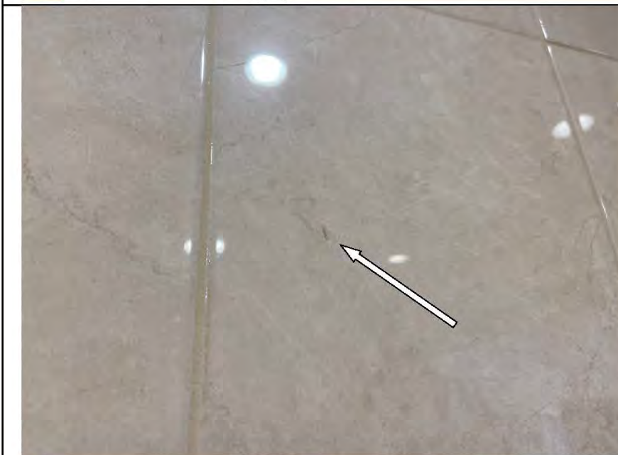
Фото №14. Загрязнения на настенной керамической плитке в ванной комнате.
