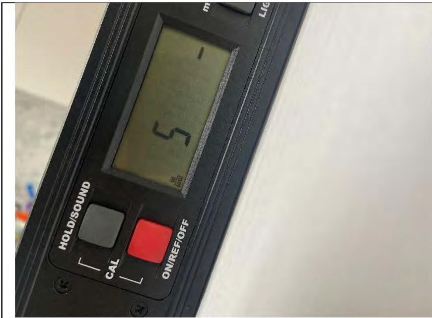
Фото №10. Измерение уровня стен в кухне.
