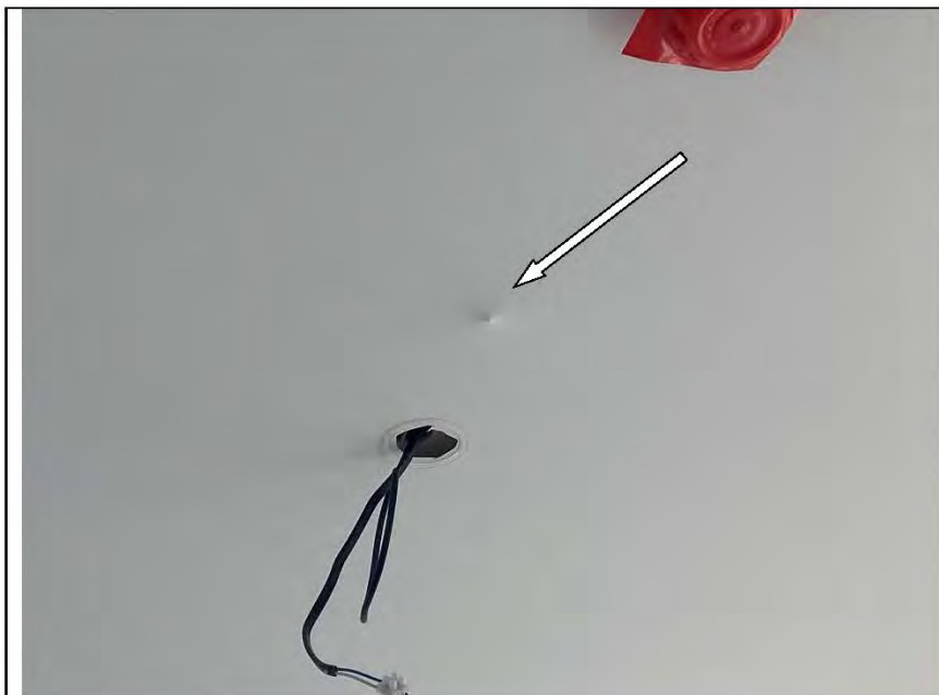
Фото №76. Видны инженерные сети на полотне натяжного потолка в спальне.
