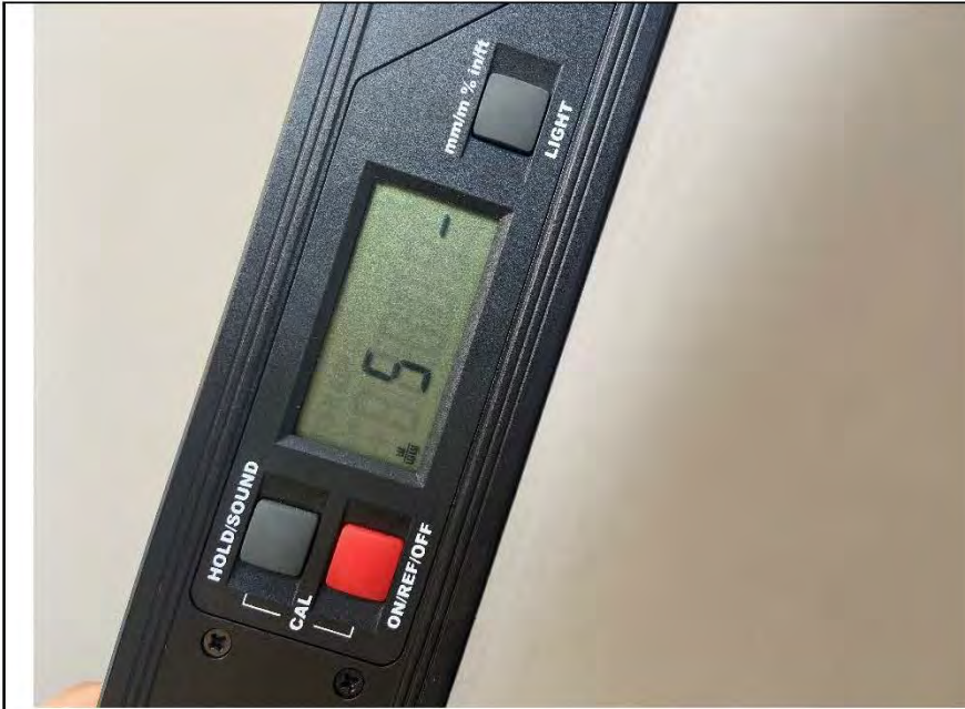
Фото №13. Измерение уровня стен на лоджии.
