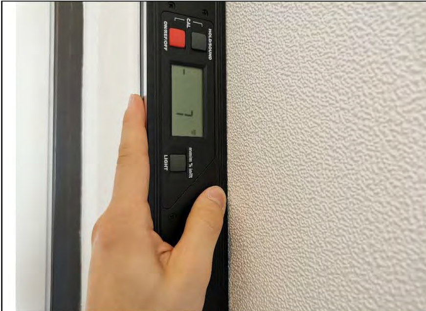
Фото №7. Измерение уровня стен в коридоре.
