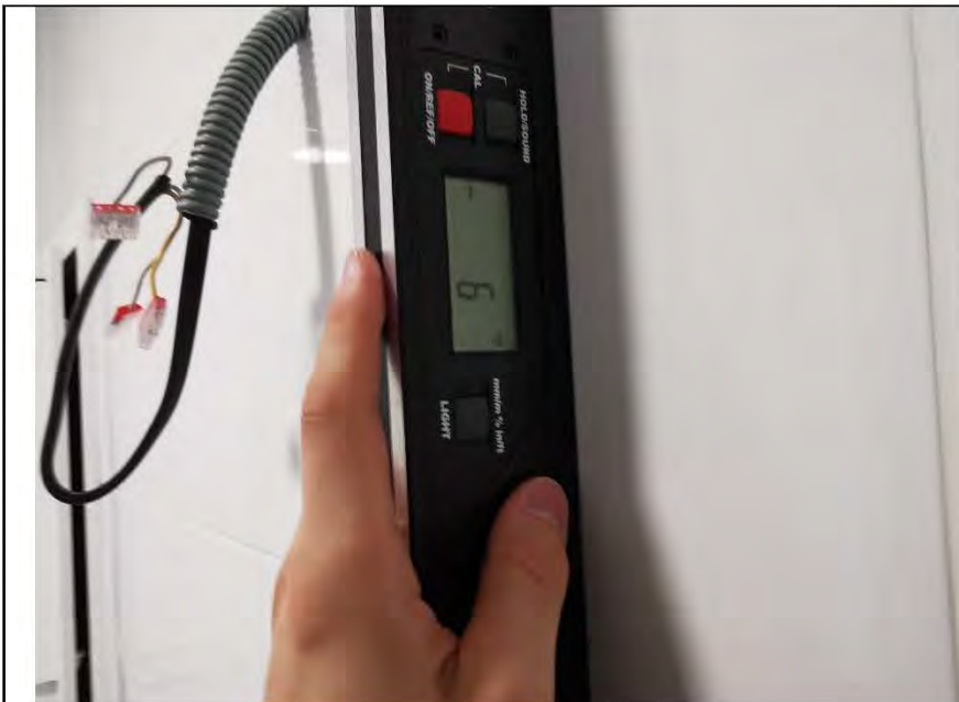
Фото №13. Измерение уровня стен в ванной комнате.
