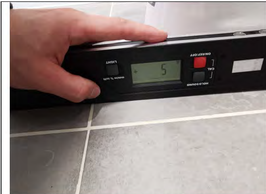
Фото №22. Измерение уровня пола в ванной комнате
