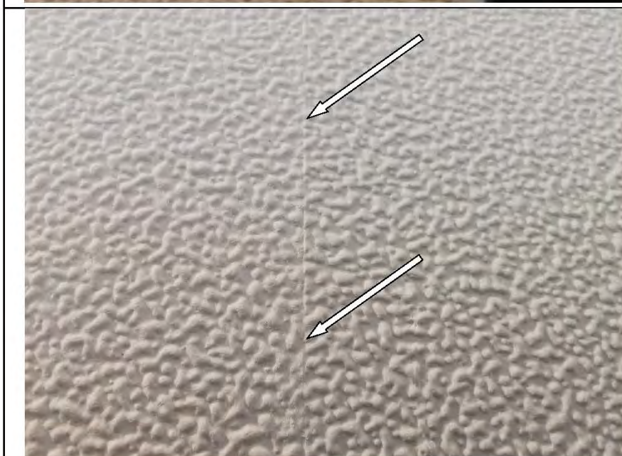
Фото №11. Читаемые обойные стыки в коридоре.
