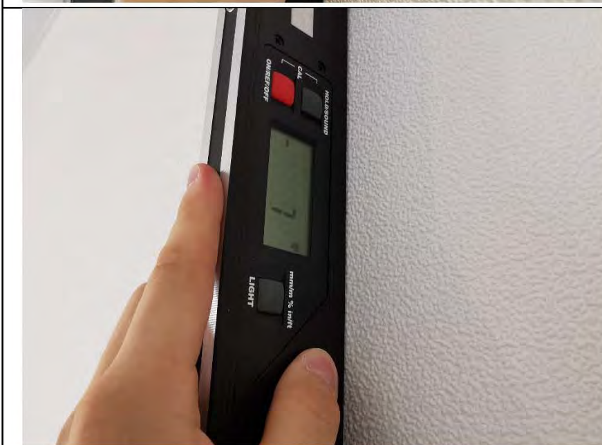
Фото №8. Измерение уровня стен в спальне.
