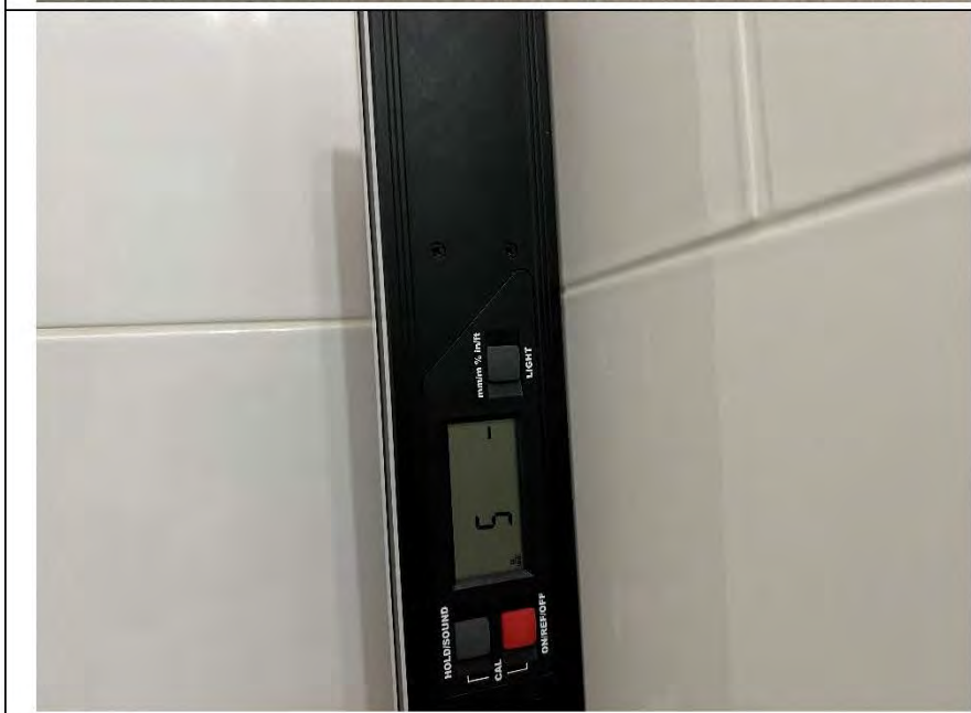
Фото №18. Измерение уровня стен в ванной комнате.
