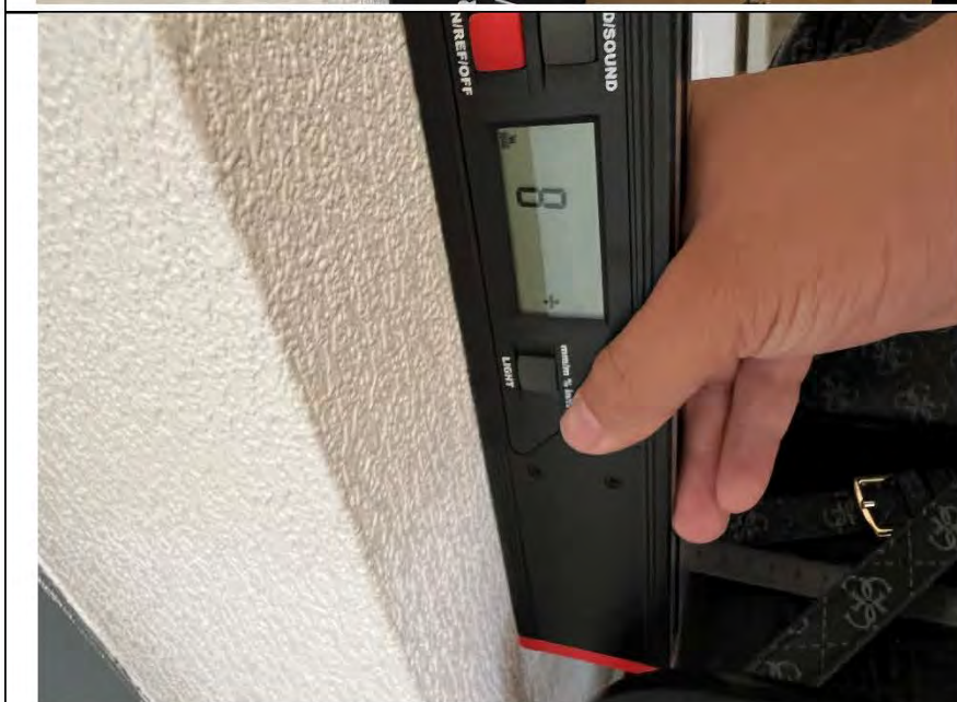
Фото №11. Измерение уровня стен в коридоре.
