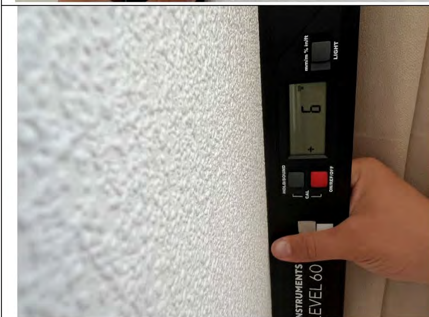
Фото №9. Измерение уровня стен в спальне.
