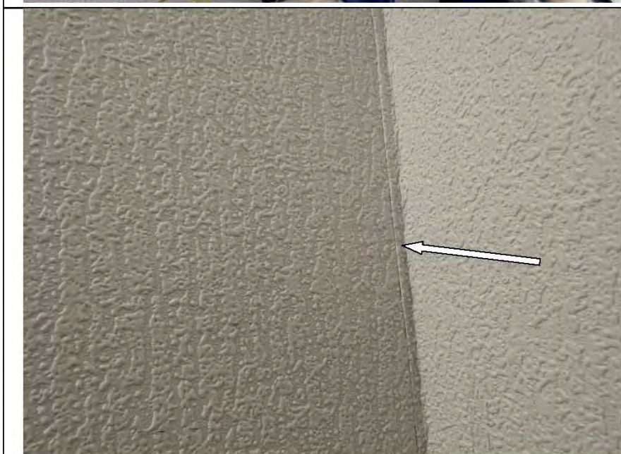
Фото №14. Читаемые обойные стыки в гардеробной.
