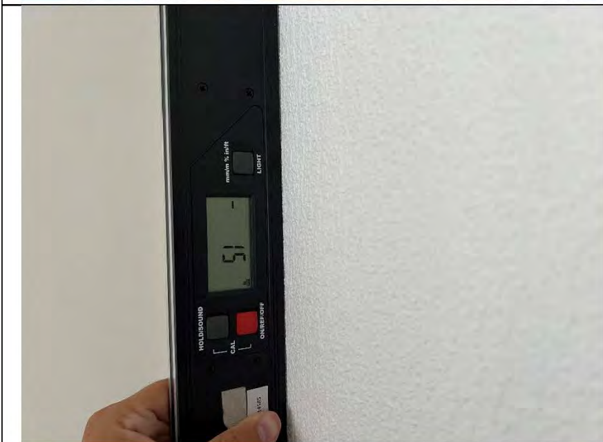
Фото №8. Измерение уровня стен в кухне.
