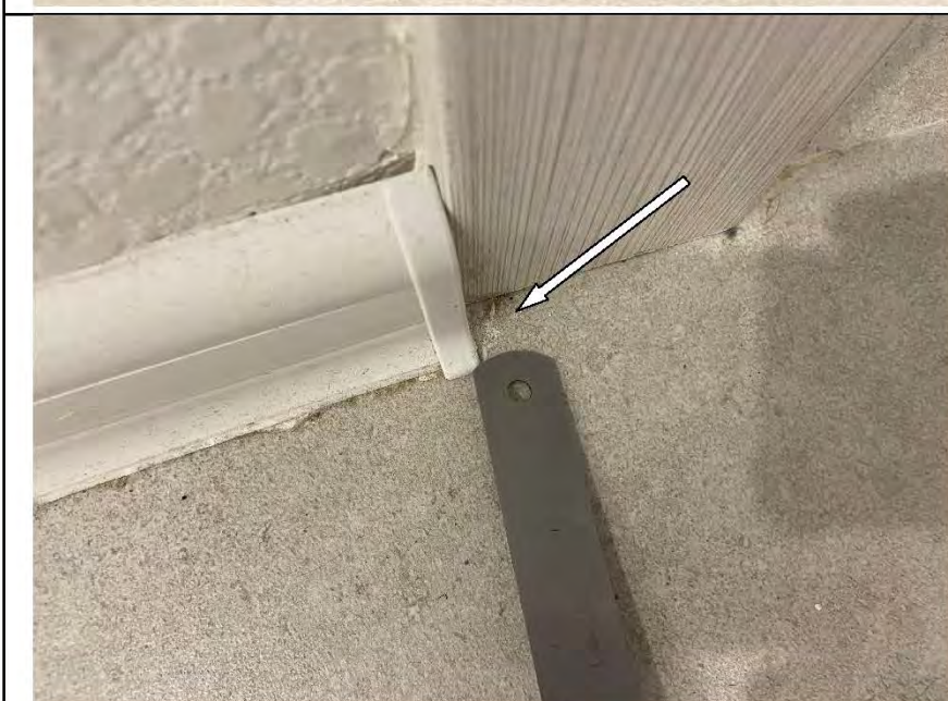
Фото №26. Загрязнения на напольной керамической плитке в коридоре.
