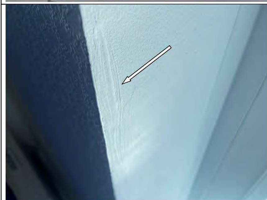
Фото №48. Неровности, выбоины, раковины на окрашенных откосах оконного блока ПВХ в кухне.
