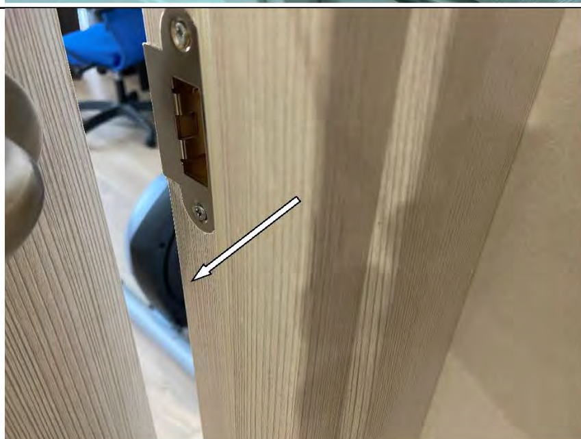
Фото №81. Не закрывается/открывается свободно дверь в кабинете.
