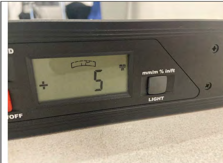
Фото №22. Отклонение напольного покрытия из керамической плитки в коридоре.
