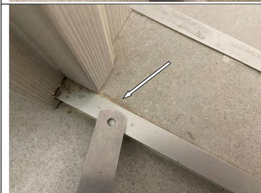
Фото №27. Загрязнения на напольной керамической плитке в ванной комнате.
