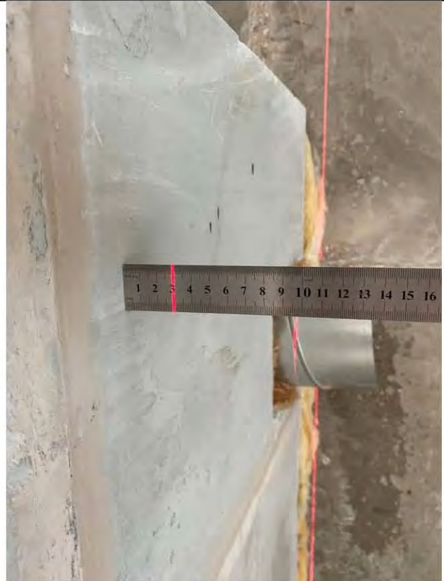
Фото 15-18. Кухня-Гостиная (15,4 кв.м.) 2.1 Отклонение перегородок от вертикали из пазогребневых плит 11 мм, 10 мм
