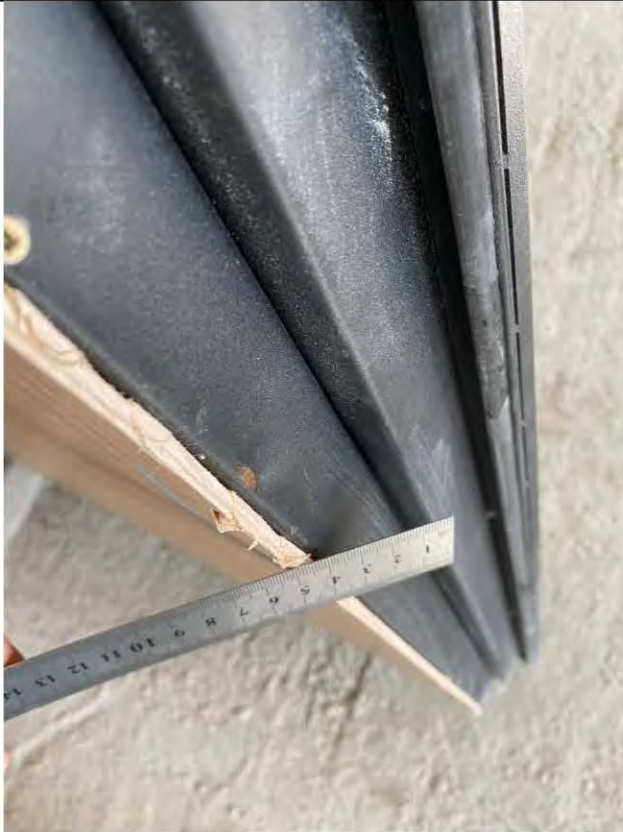
Фото 9-14. Коридор (3,7 кв.м.) 1.1 На входной двери имеются сколы, следы повреждения от возгорания
