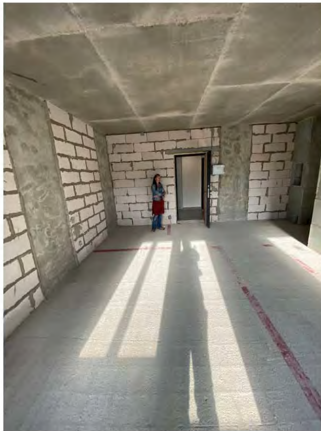
Фото 6. Комната 1 (12,7 кв.м.). Общий вид помещения.
