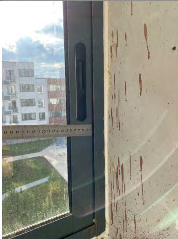
Фото 30. Лоджия (3,7 кв.м.) 4.2 При открывании и закрывании обнаружено отклонение в работе оконной створки
