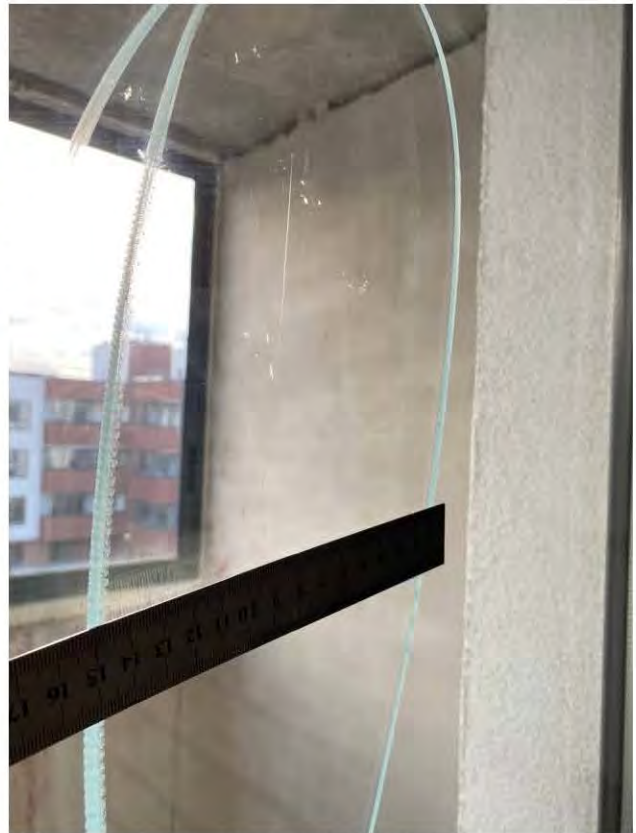
Фото 26, 27. Комната 1 (12,7 кв.м.) 3.2 Наличие царапин на стеклопакетах
