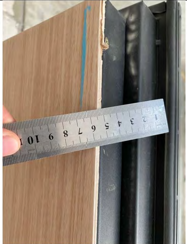
Фото 9-14. Коридор (3,7 кв.м.) 1.1 На входной двери имеются сколы, следы повреждения от возгорания
