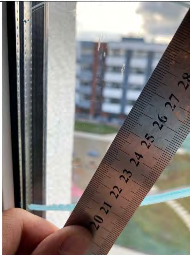
Фото 19-21. Кухня-Гостиная (15,4 кв.м.) 2.2 Наличие царапин на стеклопакетах, брака
