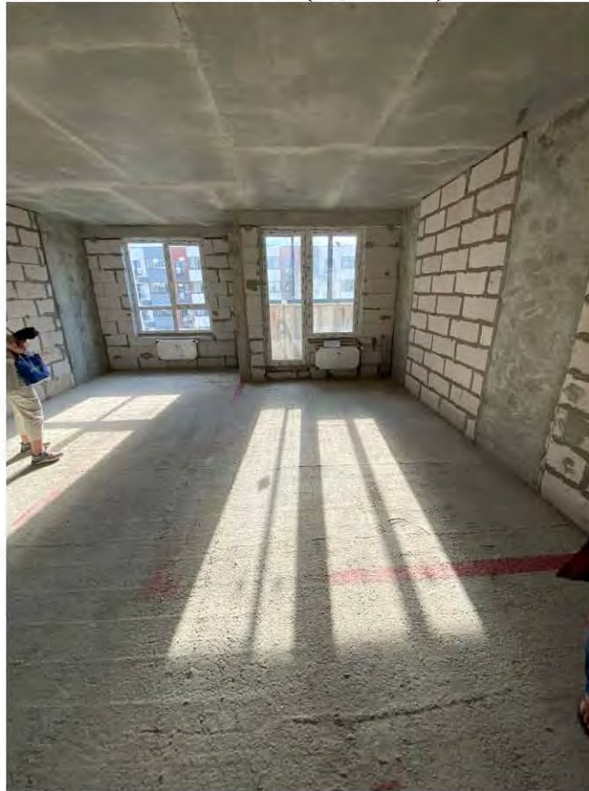
Фото 5. Комната 1 (12,7 кв.м.). Общий вид помещения.
