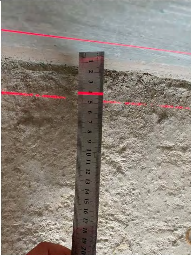
Фото 15-18. Кухня-Гостиная (15,4 кв.м.) 2.1 Отклонение перегородок от вертикали из пазогребневых плит 11 мм, 10 мм
