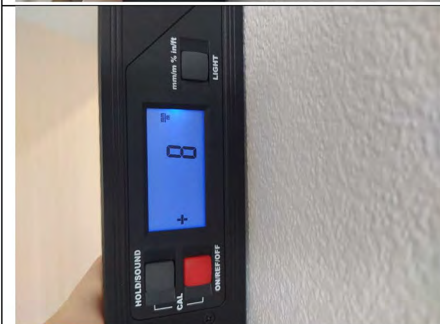
Фото №11. Измерение уровня стен в гостиной.
