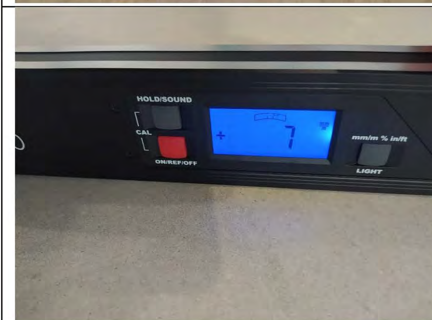
Фото №21. Измерение уровня напольного покрытия в кухне (керамическая плитка).
