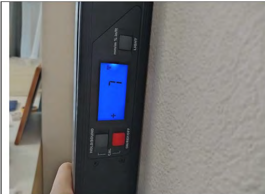
Фото №10. Измерение уровня стен в спальне.
