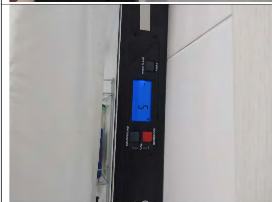
Фото №15. Измерение уровня стен в ванной комнате (керамическая плитка).
