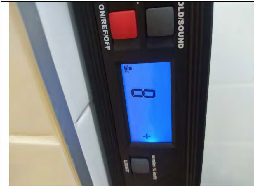
Фото №16. Измерение уровня стен в прачечной (керамическая плитка).
