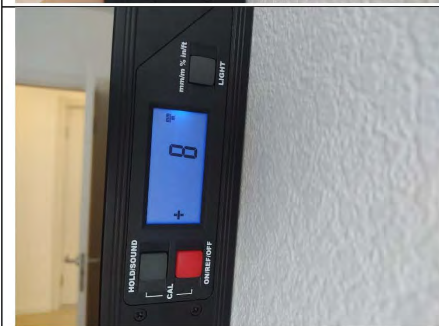
Фото №12. Измерение уровня стен в кабинете.
