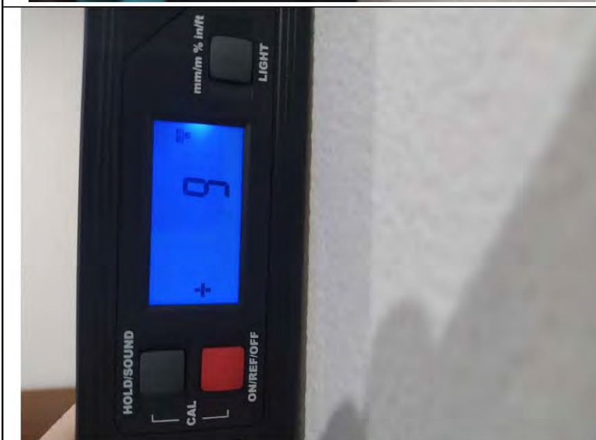
Фото №14. Измерение уровня стен в прихожей.
