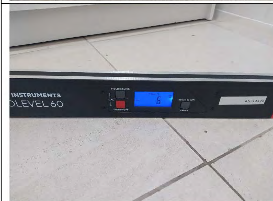
Фото №23. Измерение уровня напольного покрытия в ванной комнате (керамическая плитка).
