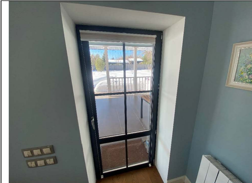
Фото №7. Общий вид оконных блоков в жилом доме.
