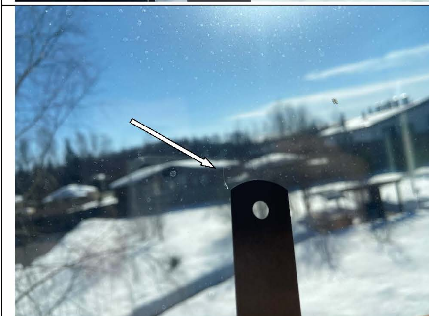
Фото №26. Царапины на стеклопакете оконного блока в жилом доме.
