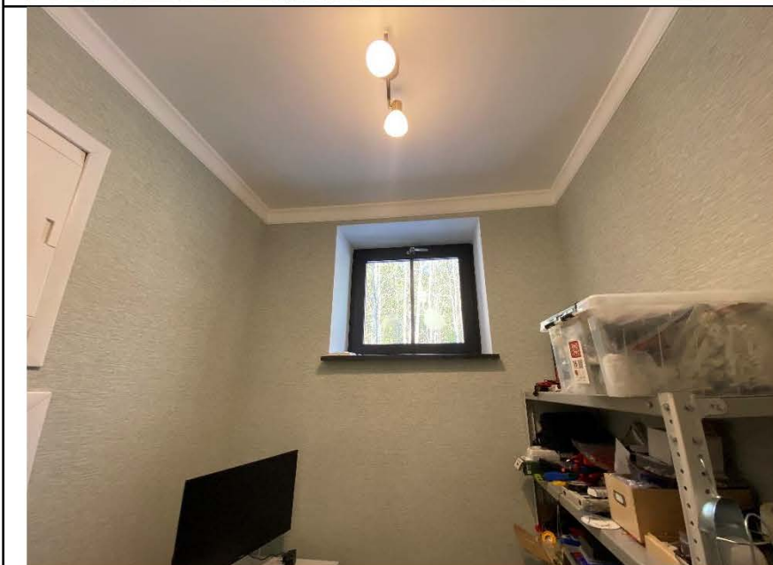
Фото №5. Общий вид оконных блоков в жилом доме.
