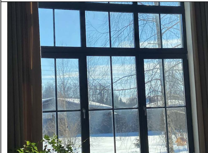
Фото №8. Общий вид оконных блоков в жилом доме.
