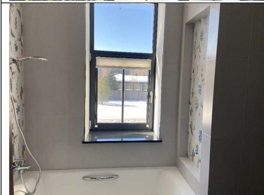
Фото №9. Общий вид оконных блоков в жилом доме.
