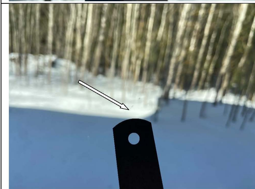
Фото №18. Царапины на стеклопакете оконного блока в жилом доме.
