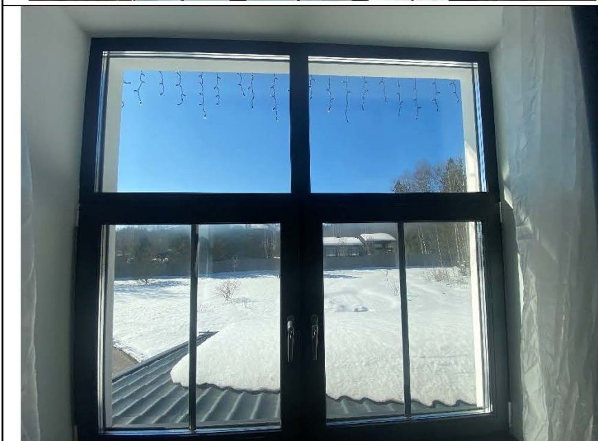
Фото №11. Общий вид оконных блоков в жилом доме.
