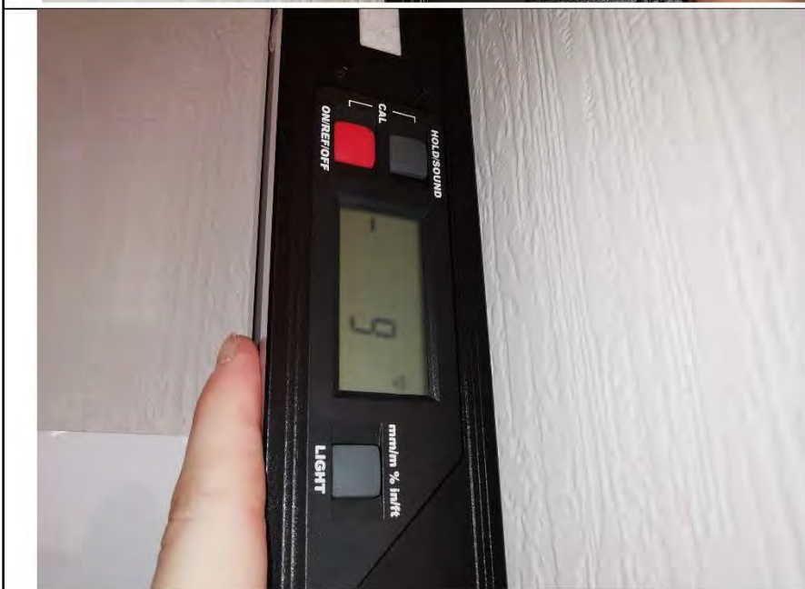
Фото №9. Измерение уровня стен в коридоре.
