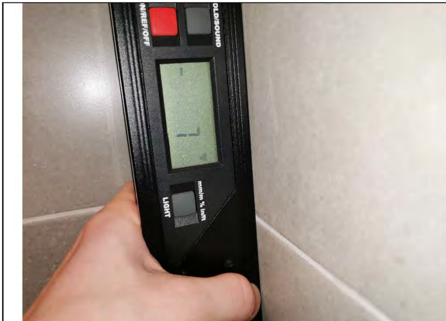
Фото №13. Измерение уровня стен в ванной комнате.
