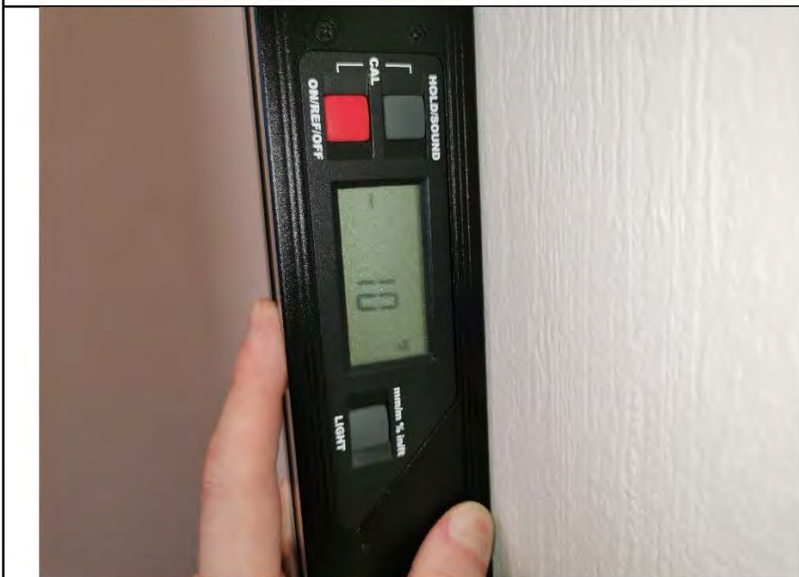
Фото №11. Измерение уровня стен на кухне.
