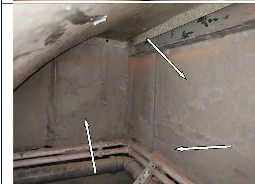
Фото №14. Частично отсутствует настенная керамическая плитка за ванной. Отсутствие гидроизоляции в ванной комнате.
