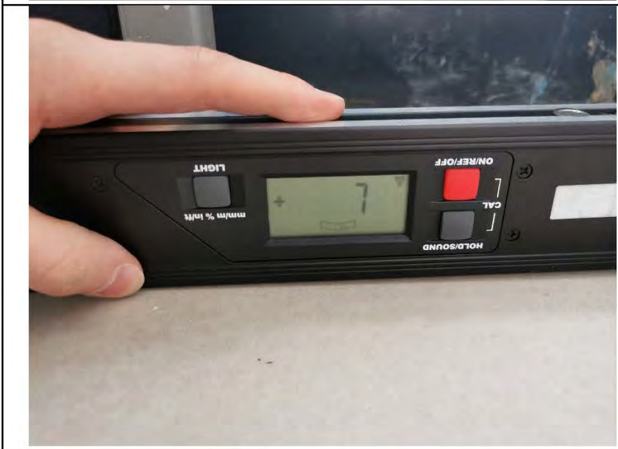
Фото №60. Измерение уровня пола на лоджии.
