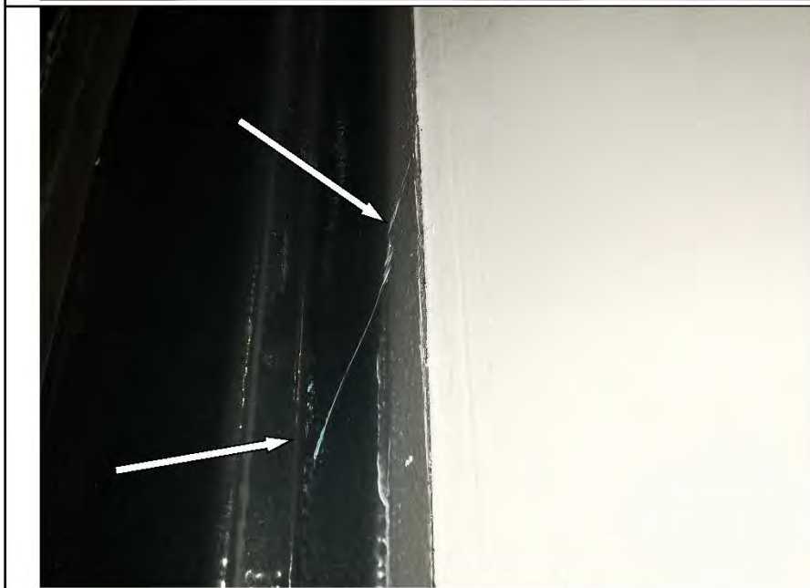
Фото №56. Царапины на коробе входного дверного блока.
