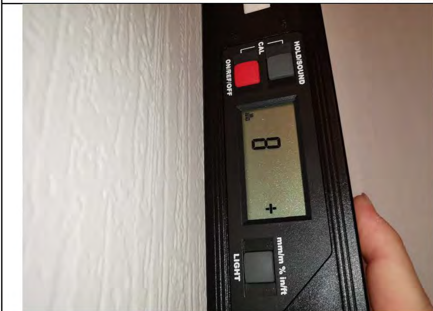
Фото №8. Измерение уровня стен в коридоре.
