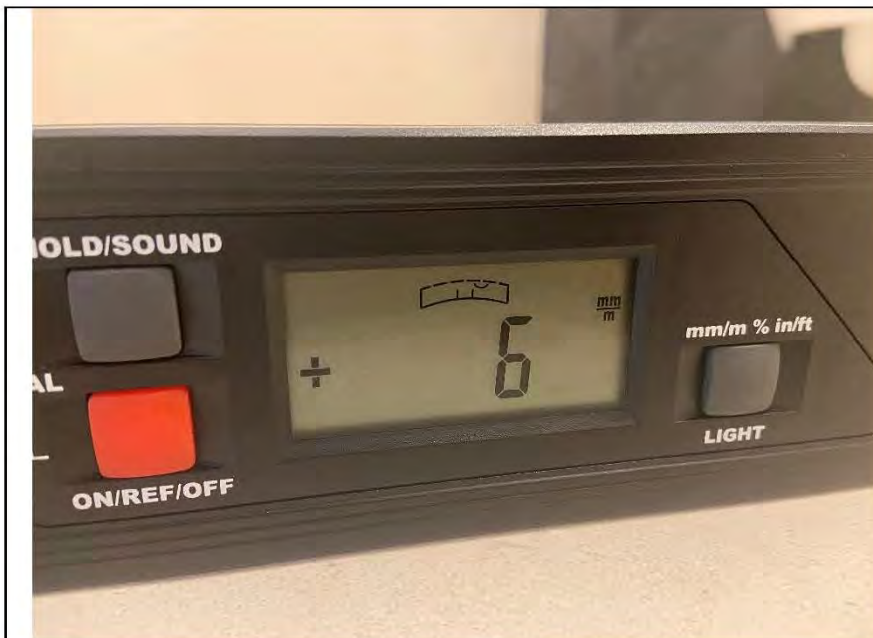
Фото №19. Отклонение поверхности напольного покрытия в ванной комнате.
