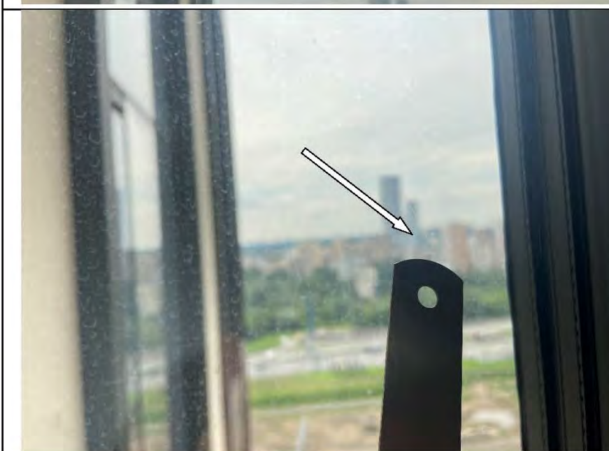
Фото №42. Царапина на стеклопакете алюминиевого оконного блока в кухне.
