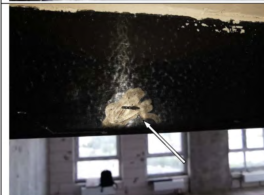
Фото №70. Механическое повреждение короба входного дверного блока.
