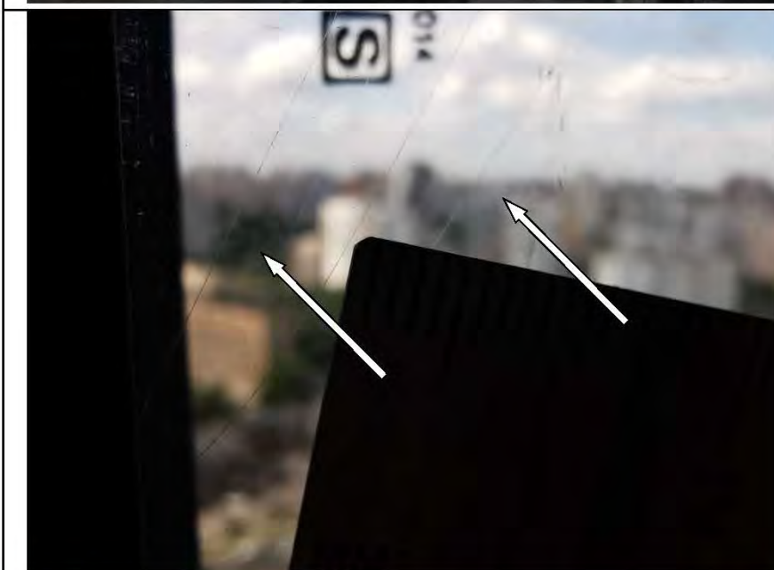
Фото №50. Царапины на стеклопакете оконного блока 3.
