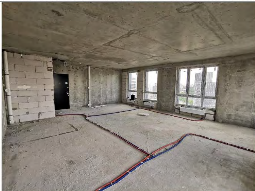
Фото №2. Общий вид помещения.
