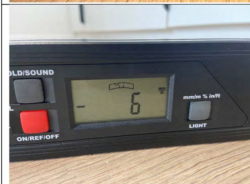
Фото №21. Отклонение напольного покрытия из ламината в детской.
