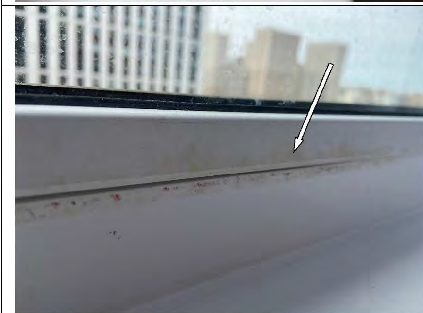
Фото №48. Загрязнения на профиле оконного блока ПВХ в детской.
