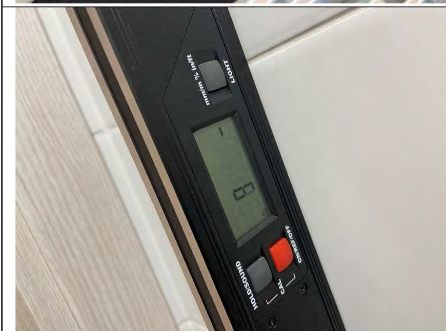
Фото №12. Измерение уровня стен в санузле.
