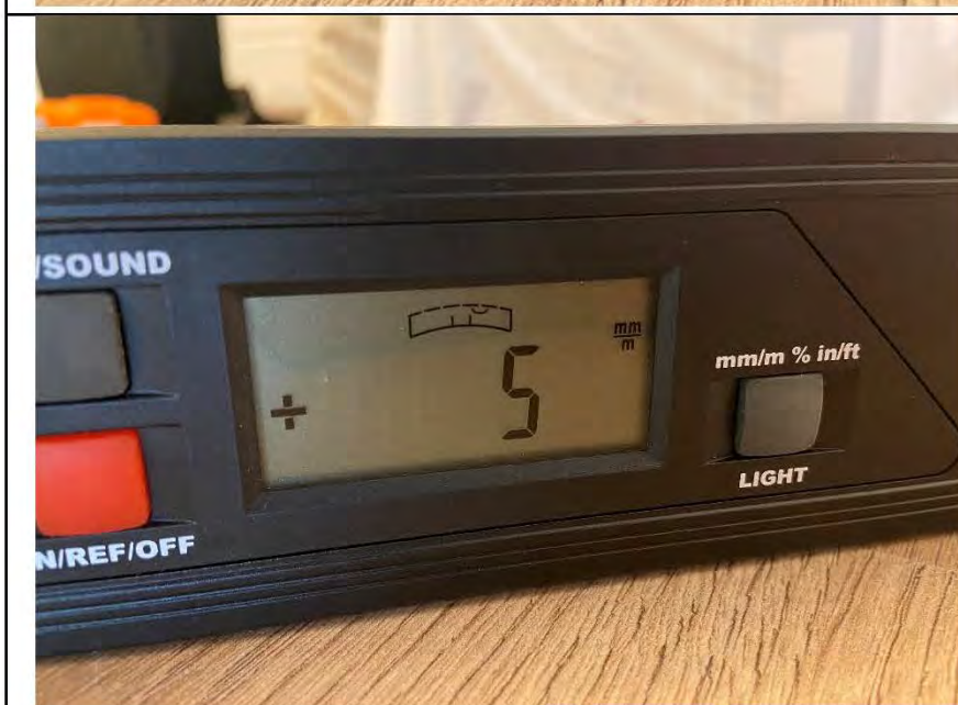
Фото №20. Отклонение напольного покрытия из ламината в коридоре.
