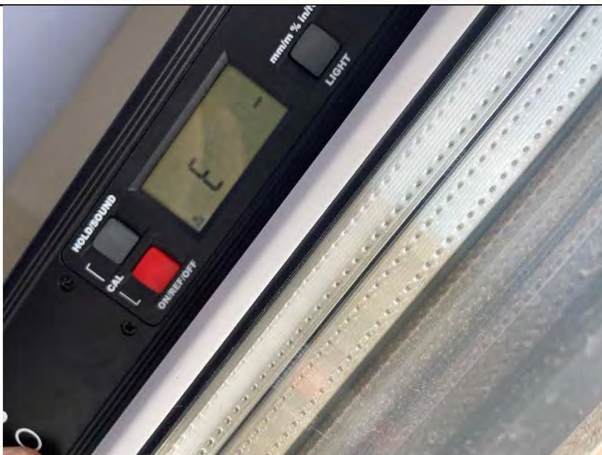
Фото №59. Отклонение оконного блока ПВХ по уровню вертикальности в детской.
