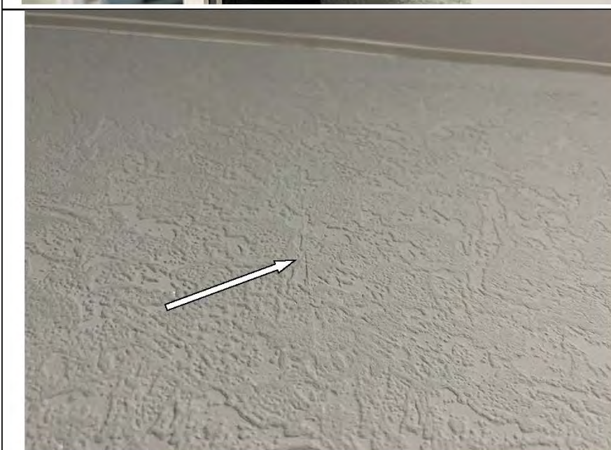
Фото №9. Читаемые обойные стыки в коридоре.
