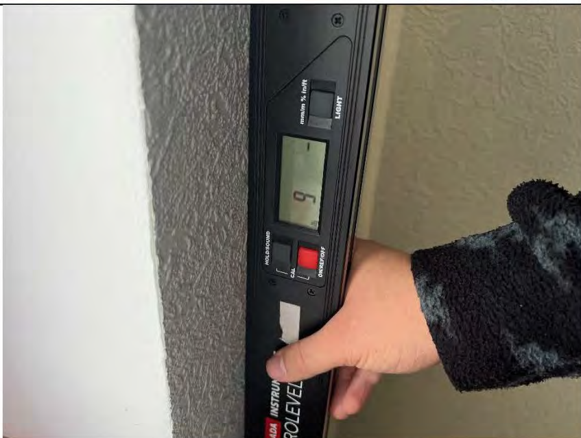
Фото №6. Измерение уровня стен в спальне.
