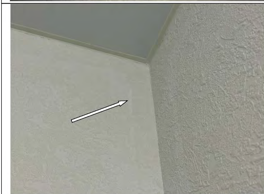
Фото №11. Скол обоевого полотна в гардеробной.
