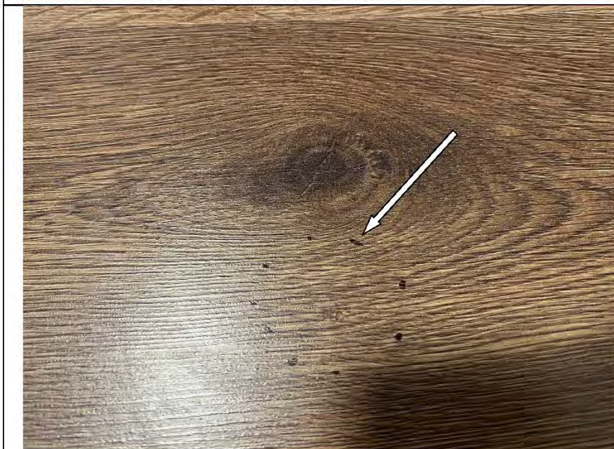
Фото №20. Механические повреждения ламината в коридоре.
