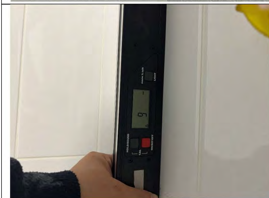
Фото №12. Измерение уровня стен в ванной комнате.
