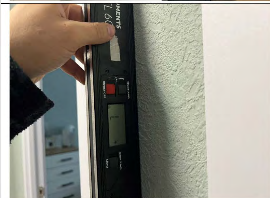
Фото №8. Измерение уровня стен в коридоре.
