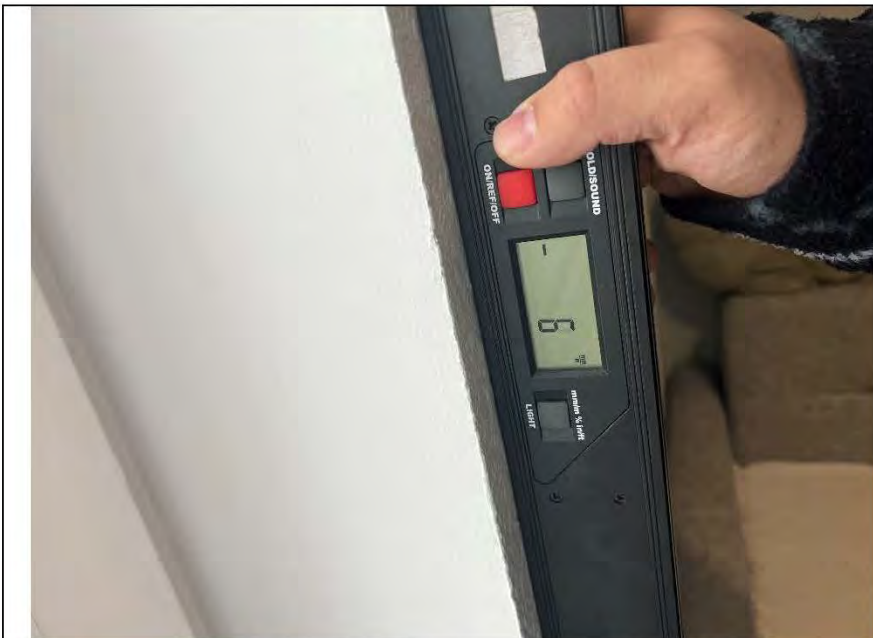
Фото №7. Измерение уровня стен в кухне.
