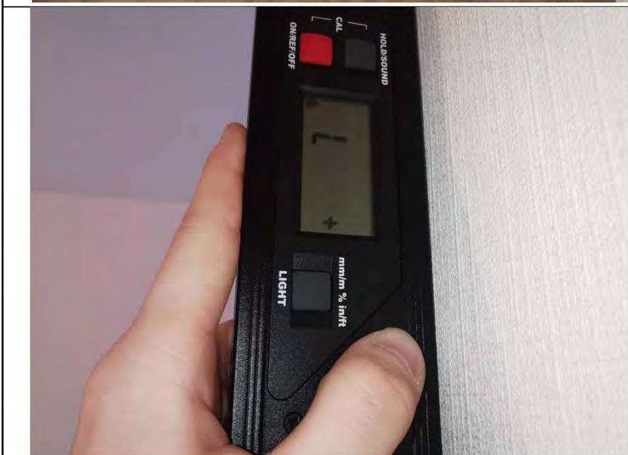
Фото №6. Измерение уровня стен в коридоре.
