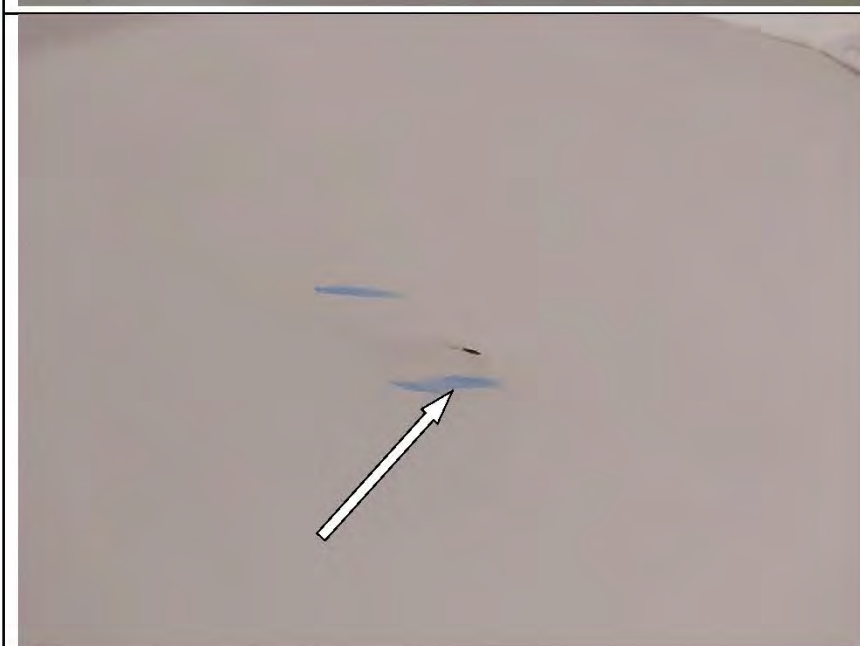
Фото №84. Дефекты (скол) на лицевой поверхности полотна входного дверного блока
