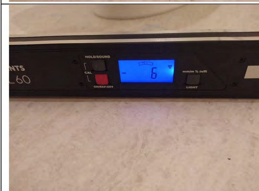
Фото №21. Измерение уровня напольного покрытия в санузле (керамическая плитка).
