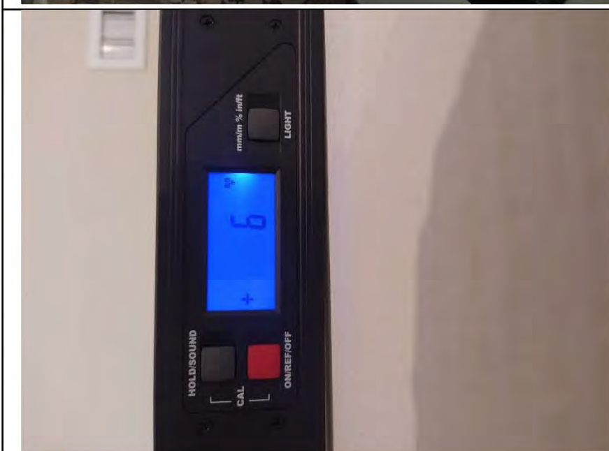
Фото №9. Измерение уровня стен в спальне.
