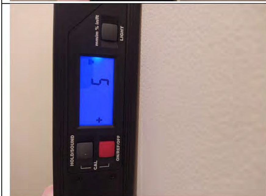
Фото №15. Измерение уровня стен в санузле (штукатуренные и окрашенные стены).
