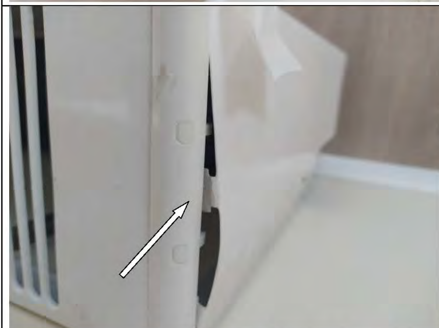
Фото №77. Отопительный прибор имеет дефект покраски защитного кожуха №2 в спальне (механическое повреждение)
