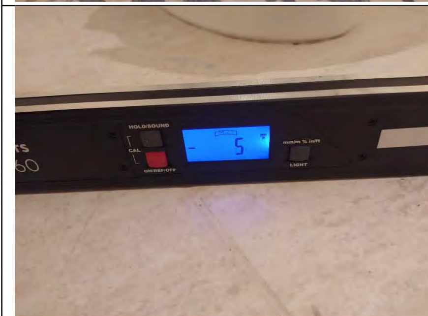
Фото №20. Измерение уровня напольного покрытия в ванной комнате (керамическая плитка).
