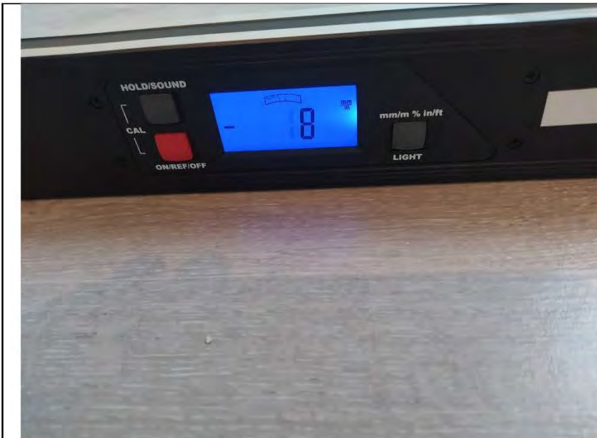
Фото №16. Измерение уровня напольного покрытия в гостиной.
