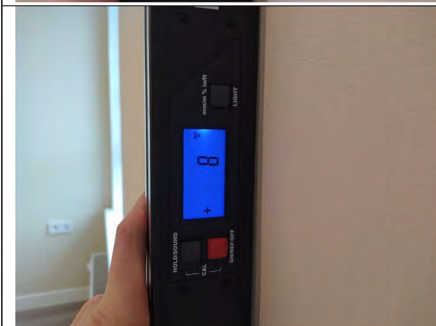
Фото №12. Измерение уровня стен в гостиной.
