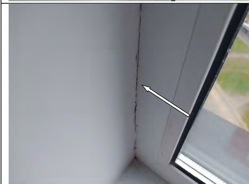
Фото №24. Оконный блок №2 в спальне имеет щели, через которые происходит инfiltrация воздуха внутри помещения.
