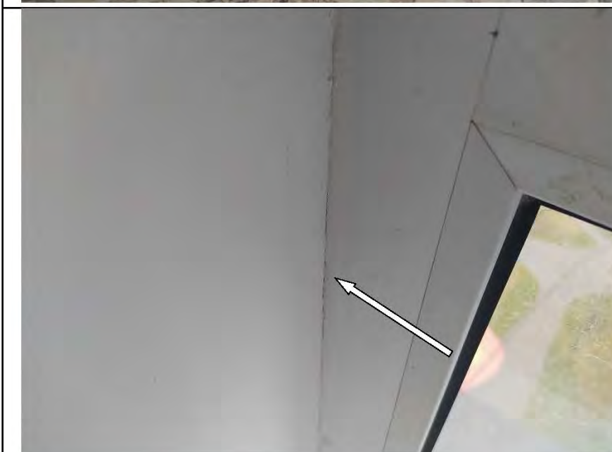
Фото №23. Оконный блок №1 в спальне имеет щели, через которые происходит инfiltrация воздуха внутри помещения.
