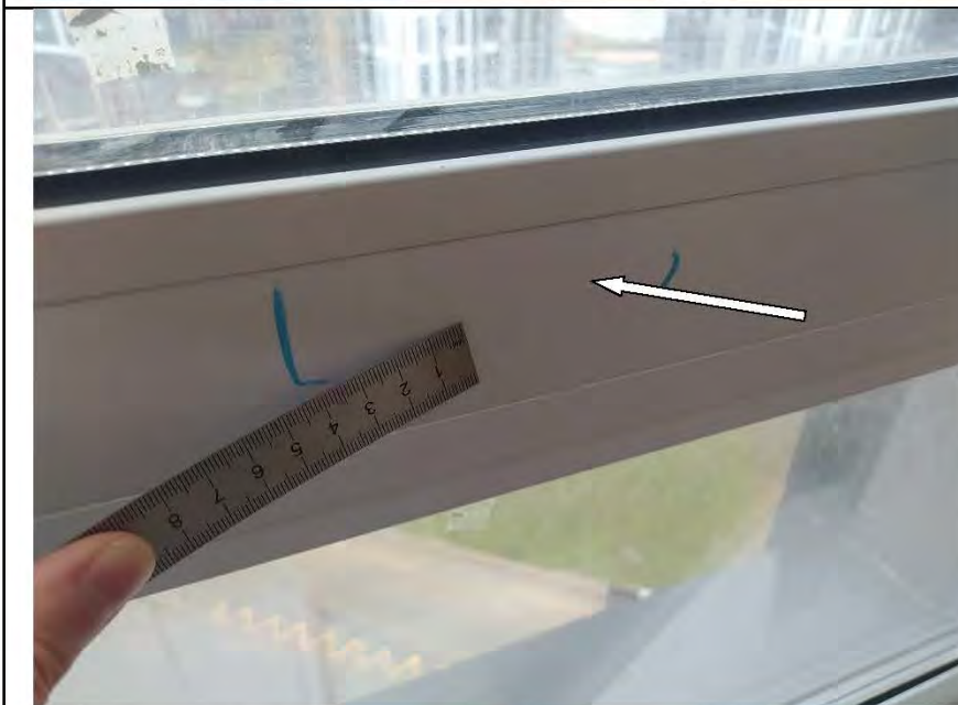
Фото №32. Профиль ПВХ оконного блока №2 в спальне имеет дефекты (царапины).
