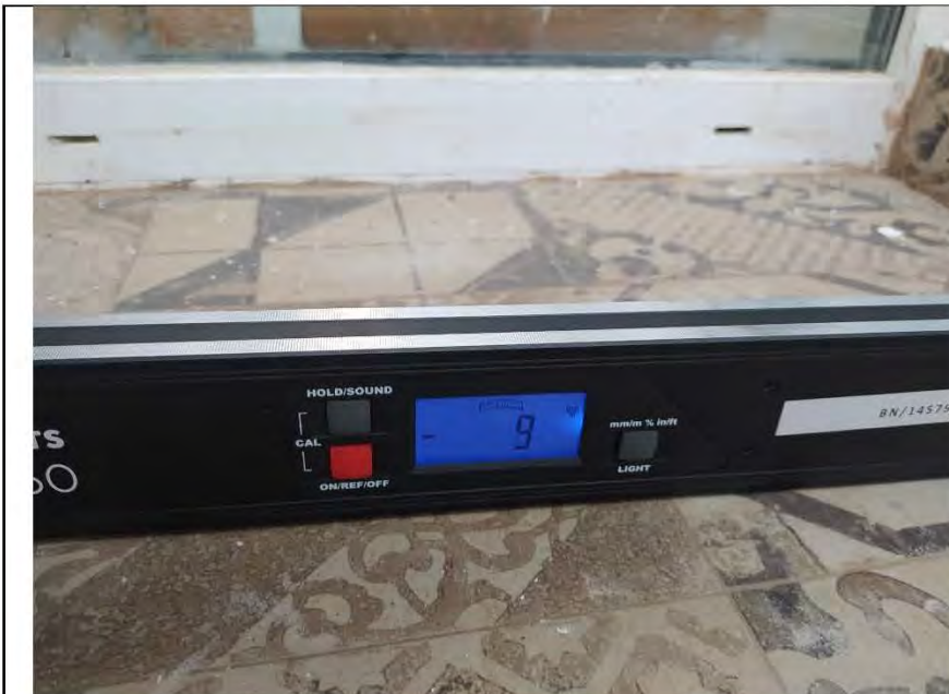
Фото №22. Измерение уровня напольного покрытия на балконе (керамическая плитка).
