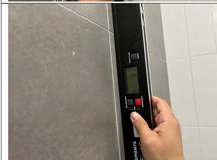
Фото №18. Измерение уровня стен в ванной комнате.
