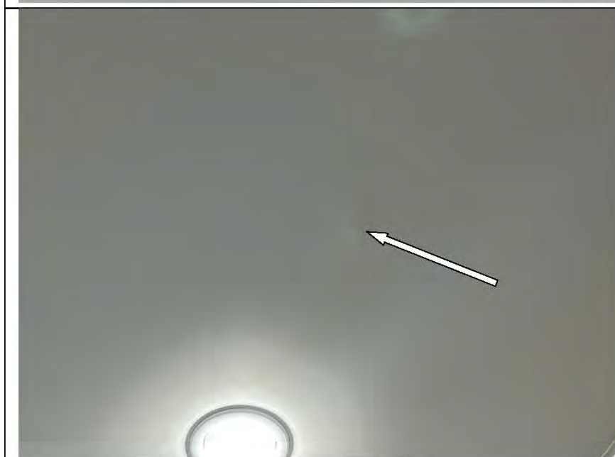
Фото №51. Видимые инженерные сети на поверхности полотна натяжного потолка в ванной комнате.
