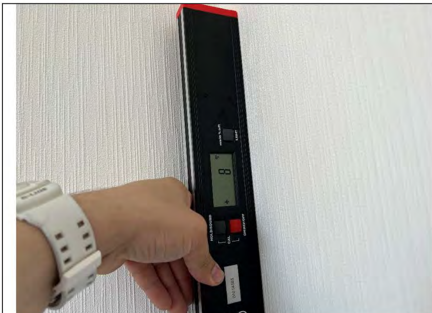
Фото №10. Измерение уровня стен в спальне.
