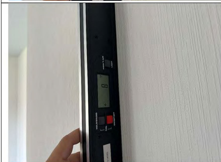
Фото №12. Измерение уровня стен в кухне.
