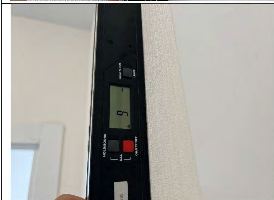
Фото №11. Измерение уровня стен в прихожей.
