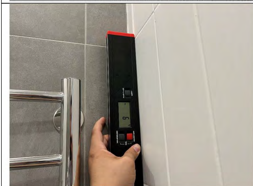
Фото №17. Измерение уровня стен в ванной комнате.
