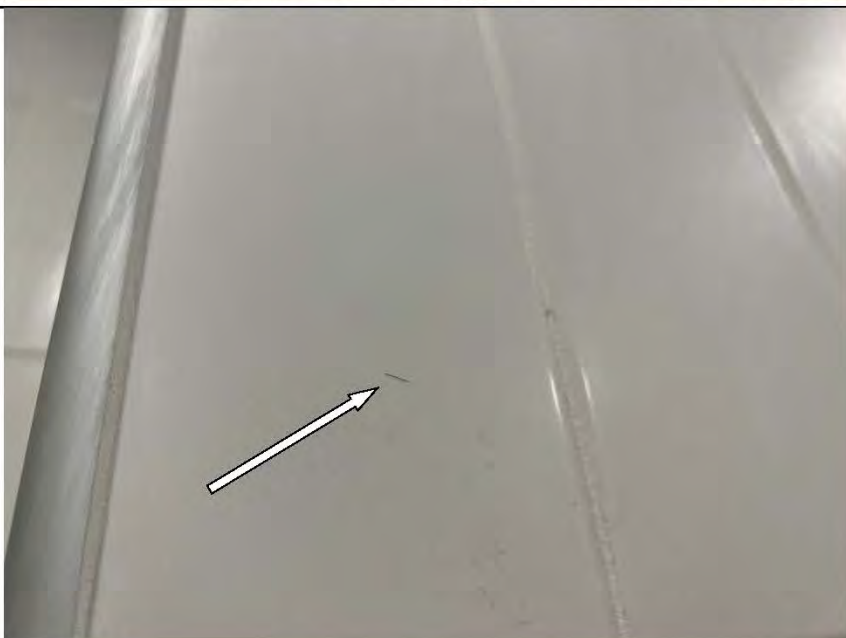
Фото №20. Царапины на лицевой поверхности настенной керамической плитки в ванной комнате.
