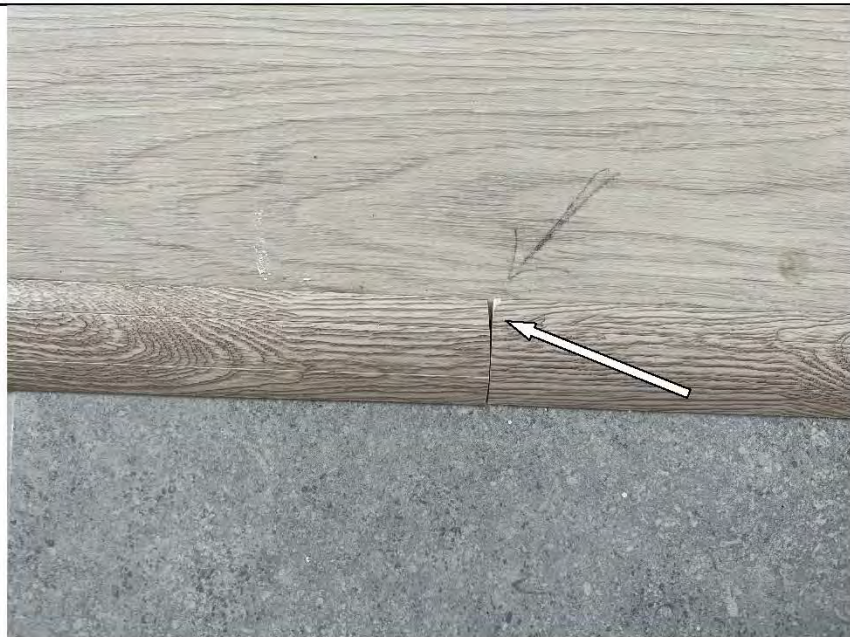
Фото №60. Зазор в стыке металлических порошков в кухне.
