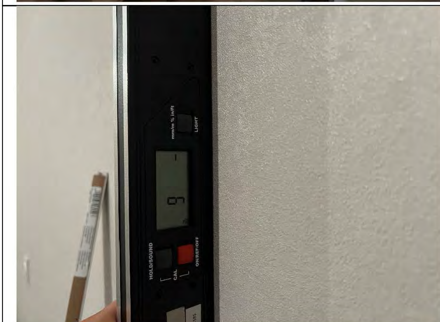
Фото №8. Измерение уровня стен в кухне.
