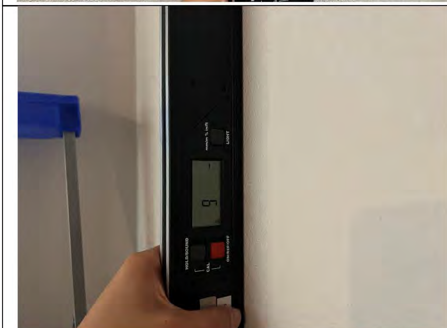
Фото №11. Измерение уровня стен в коридоре.
