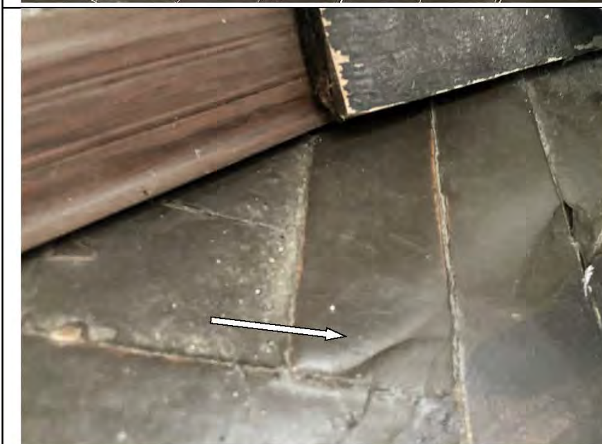
Фото №20. Вздутие кромок досок паркета (штучного) в кабинете.
