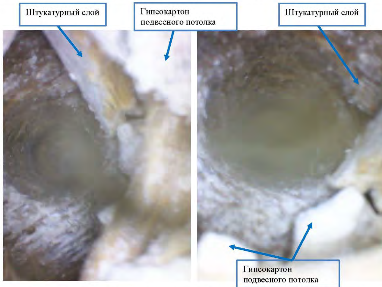
Фото 9, 10. Кухня. Потолок, отслоение штукатурного слоя в запотолочном пространстве
