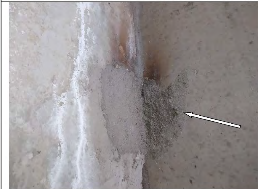
Фото №6. Не удален лишний раствор от заделки неровности стен в спальне.
