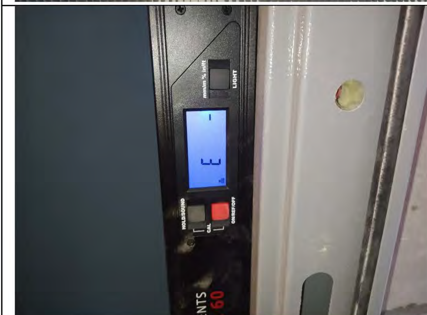
Фото №47. Отклонение коробки дверного блока равно 3 мм.
