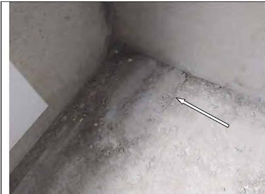
Фото №16. Наплывы и выступы на поверхности полов в спальне.
