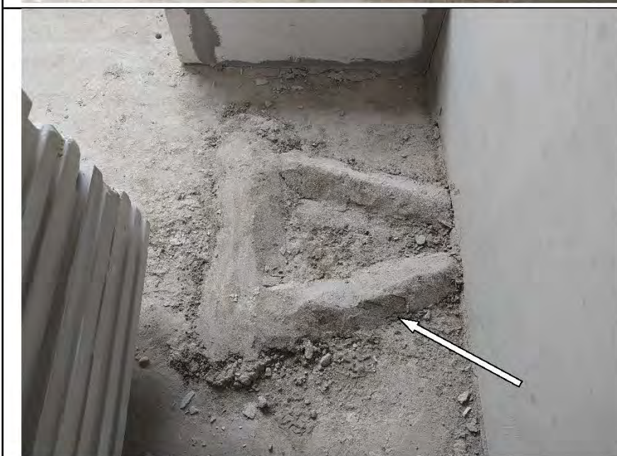
Фото №18. Наплывы и выступы на поверхности полов в кухне.
