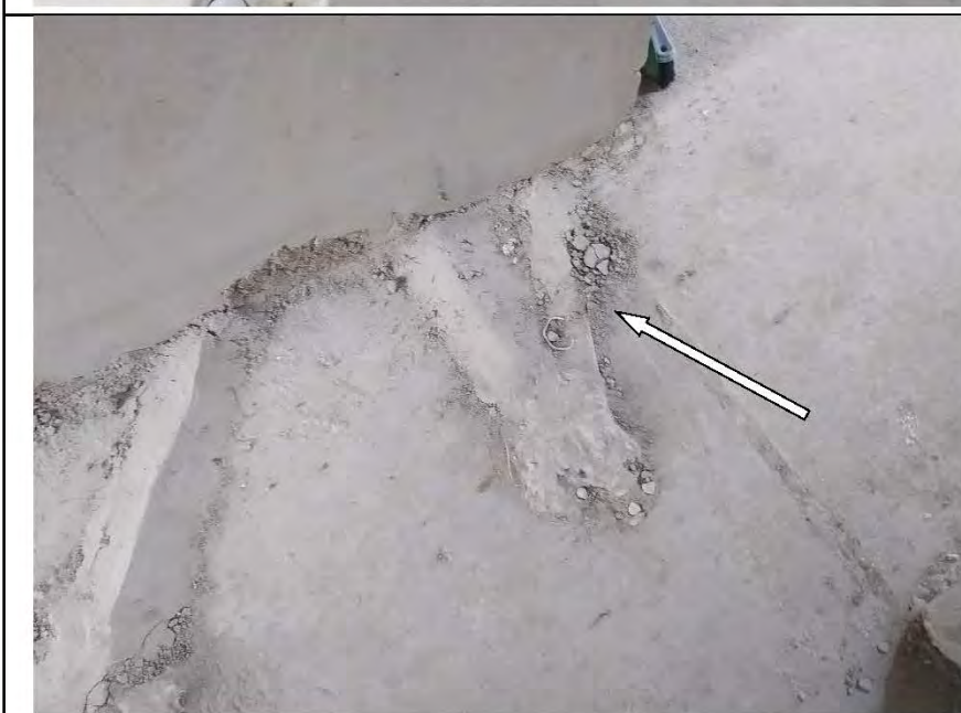
Фото №15. Наплывы и выступы на поверхности полов в спальне.
