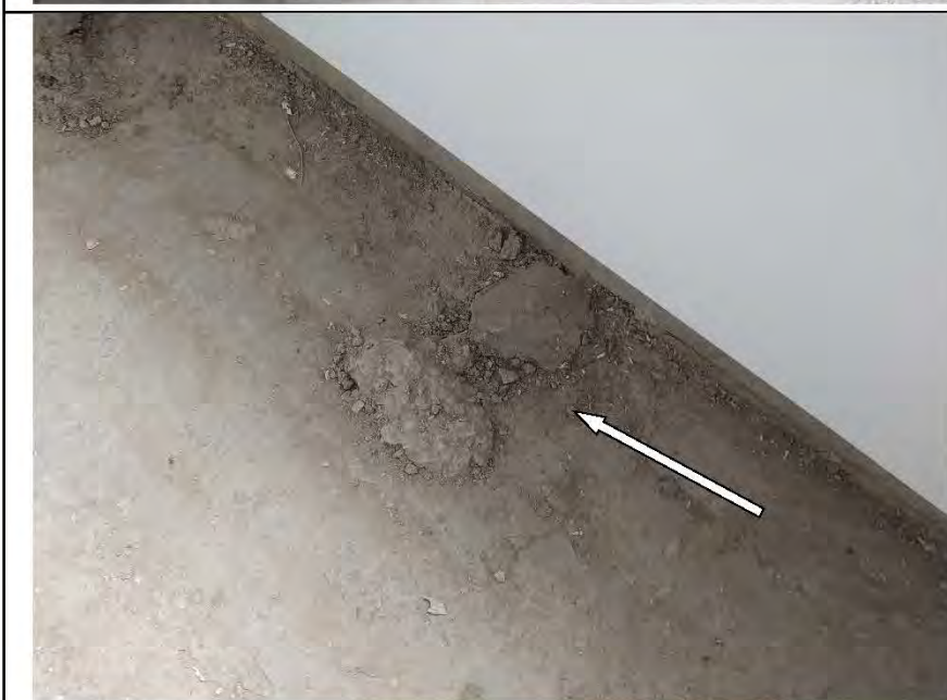
Фото №17. Наплывы и выступы на поверхности полов в кухне.
