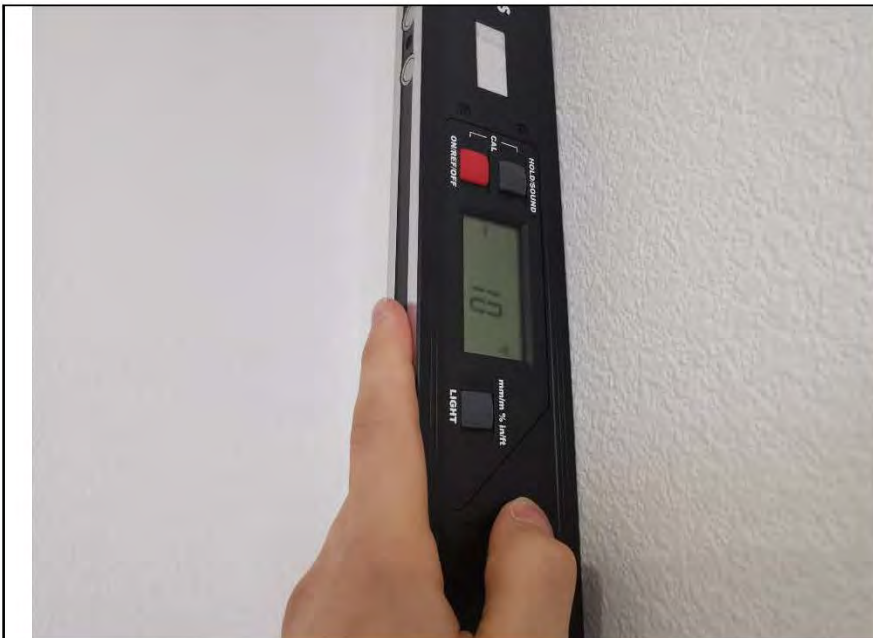
Фото №7. Измерение уровня стен в коридоре.
