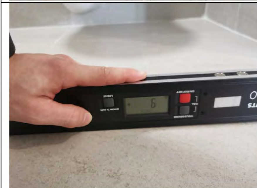
Фото №26. Измерение уровня пола в ванной комнате.
