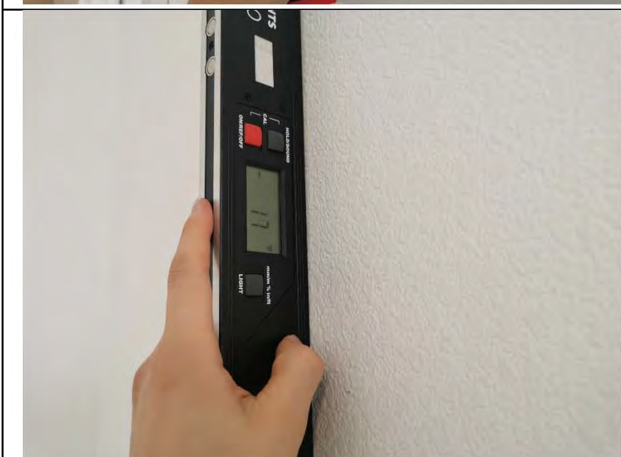
Фото №9. Измерение уровня стен в спальне.
