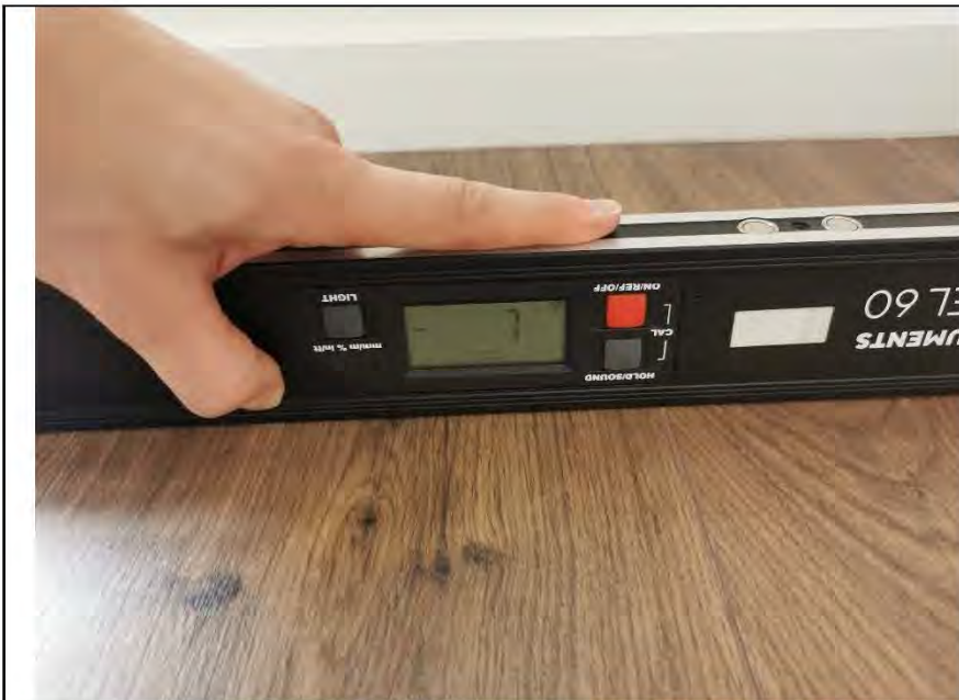
Фото №22. Измерение уровня пола в спальне.
