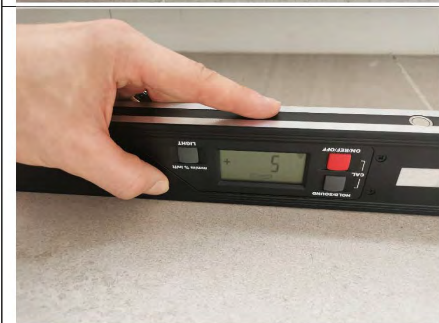
Фото №27. Измерение уровня пола в кухне.
