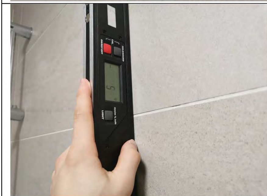
Фото №18. Измерение уровня стен в ванной комнате.
