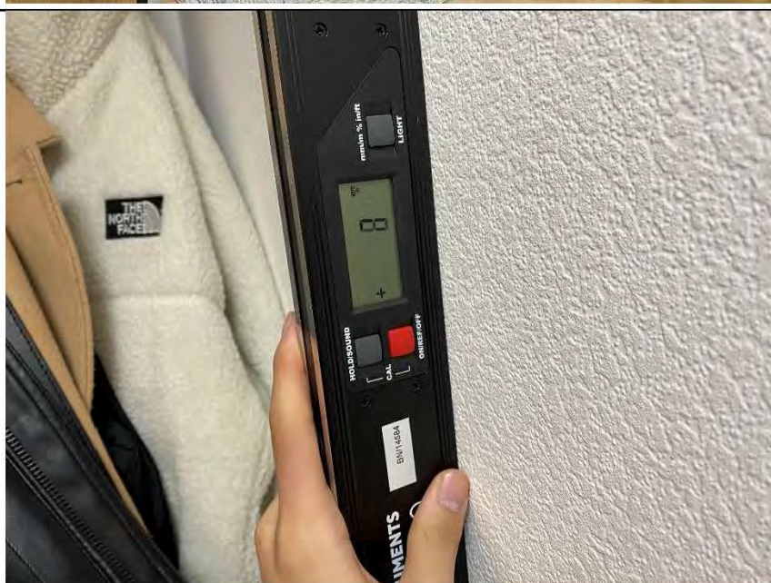
Фото №5. Измерение уровня стен в коридоре.
