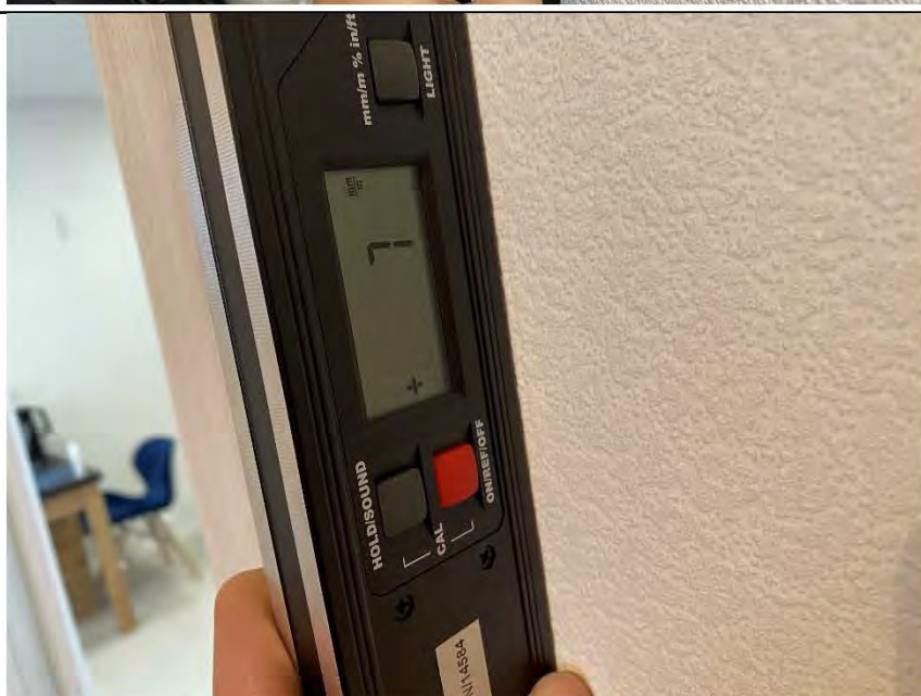
Фото №6. Измерение уровня стен в спальне.
