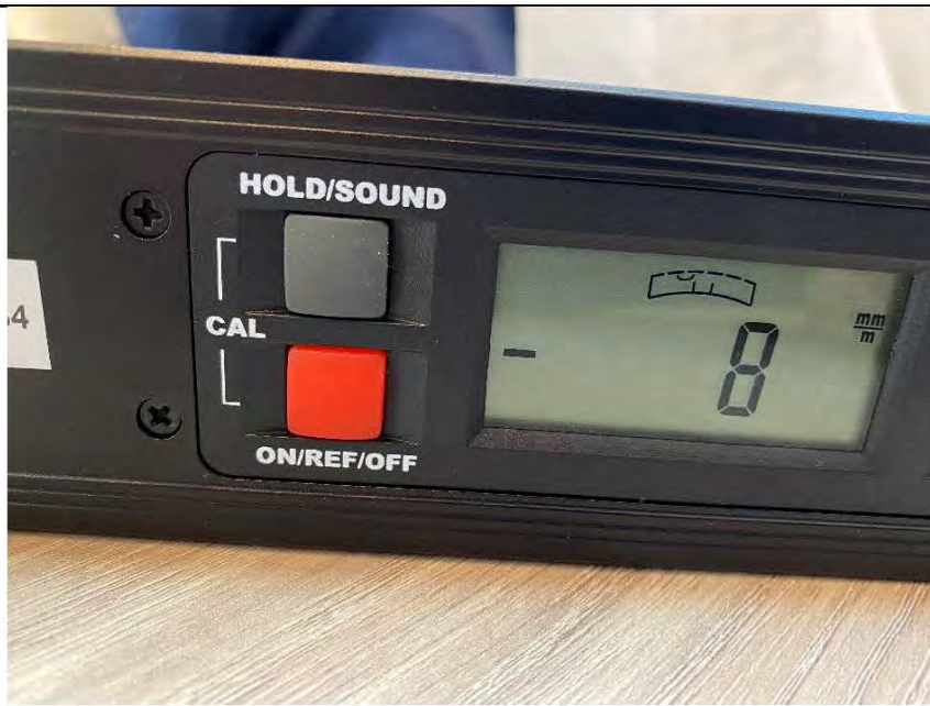
Фото №10. Измерение уровня напольного покрытия в кухне.
