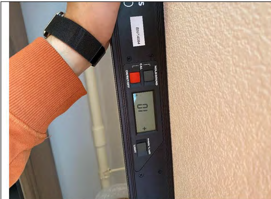
Фото №7. Измерение уровня стен в кухне.
