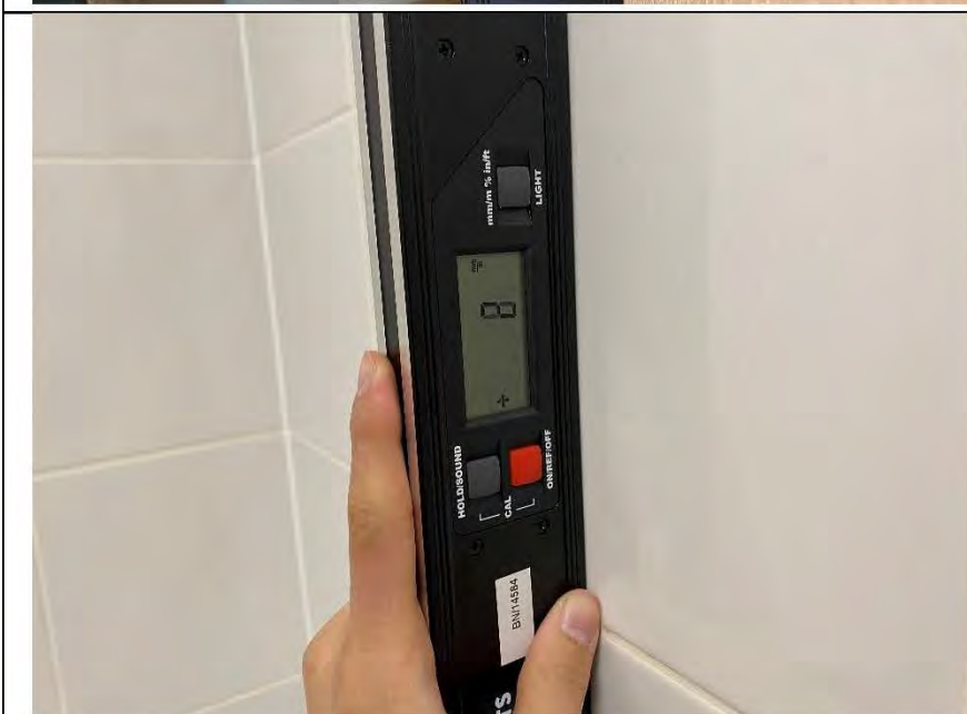
Фото №8. Измерение уровня стен в ванной комнате.
