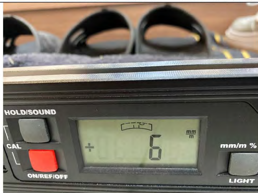
Фото №11. Измерение уровня напольного покрытия в коридоре.
