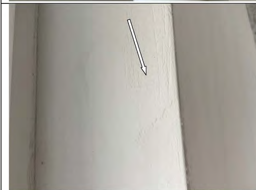
Фото №21. Неровности, выбоины на откосах оконного блока ПВХ в кухне в квартире.
