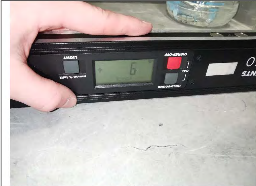
Фото №28. Измерение уровня пола в ванной комнате.
