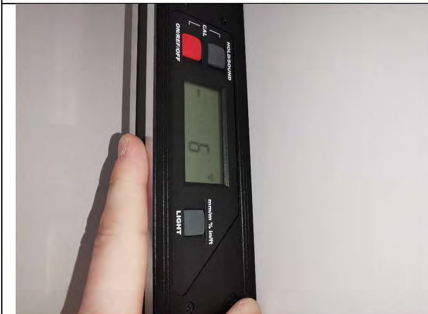
Фото №8. Измерение уровня стен в коридоре.
