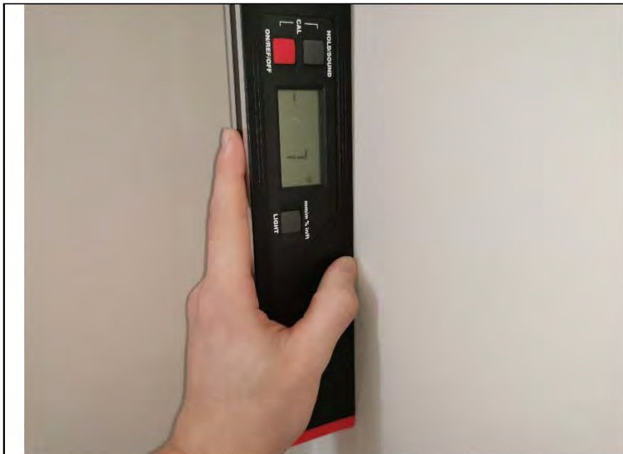
Фото №10. Измерение уровня стен в кухне.
