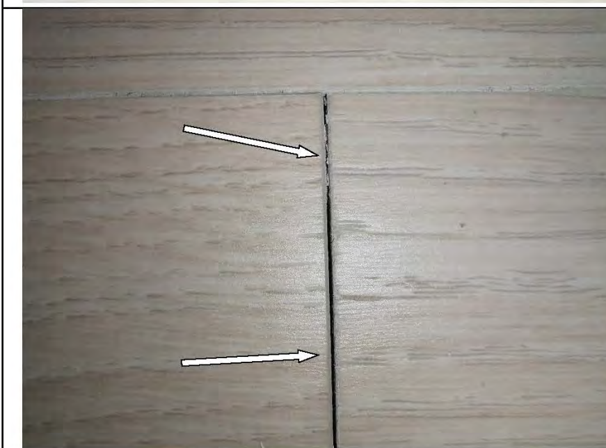
Фото №21. Зазоры между соседними досками ламината в спальне.
