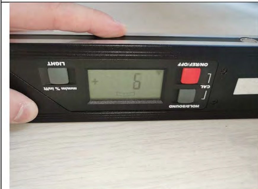
Фото №20. Измерение уровня пола в кухне.
