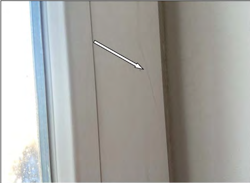
Фото №16. Царапина на профиле оконного блока ПВХ в детской в квартире.
