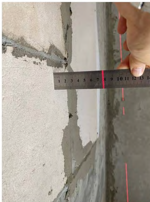
Фото 32, 33. Комната 2 (13,0 кв.м.) 5.1 Отклонение поверхности перегородок из газобетонных блоков от вертикали 14 мм
