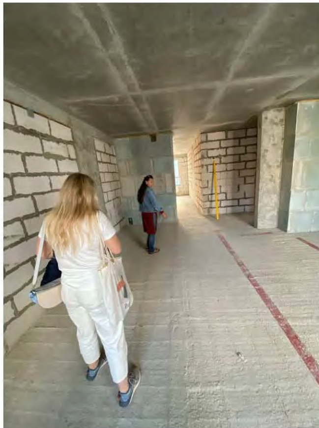
Фото 6. Комната 1 (14,7 кв.м.). Общий вид помещения.
