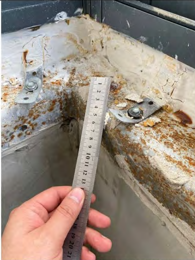
Фото 28, 29. Лоджия (1,9 кв.м.) 4.1 Отслоение окрасочного слоя, наличие коррозии на металлических ограждениях
