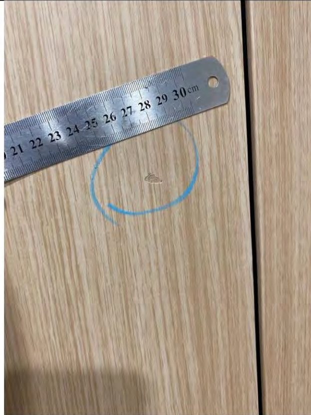
Фото 12-16. Коридор (7,9 кв.м.) 1.1 На входной двери имеются сколы, отслоение ламинации, царапины
