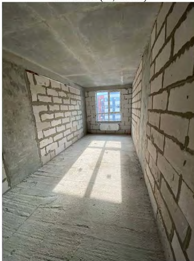
Фото 10. Комната 2 (13,0 кв.м.) Общий вид помещения.
