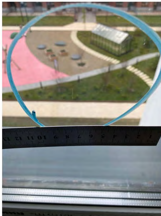
Фото 34-36. Комната 2 (13,0 кв.м.) 5.2 Наличие царапин и окалин на стеклопакетах
