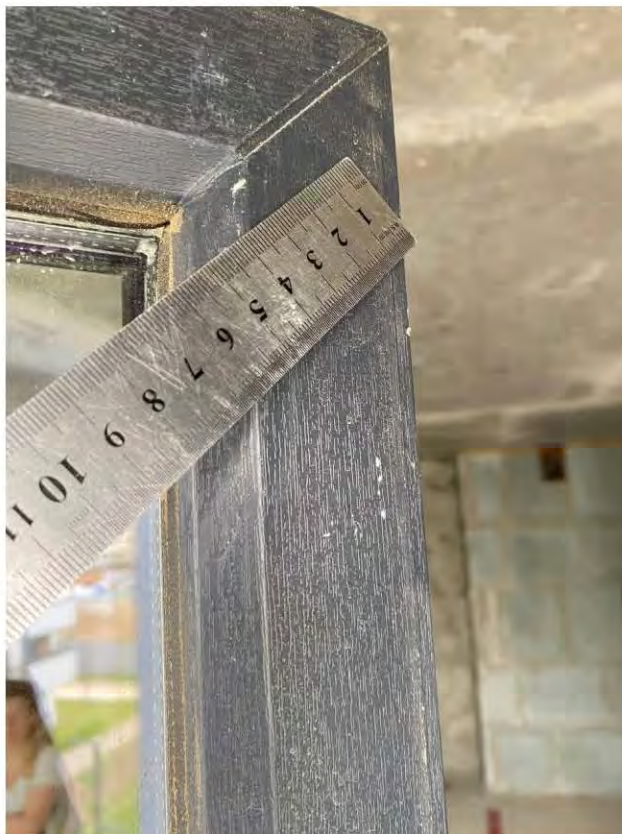
Фото 12-16. Коридор (7,9 кв.м.) 1.1 На входной двери имеются сколы, отслоение ламинации, царапины
