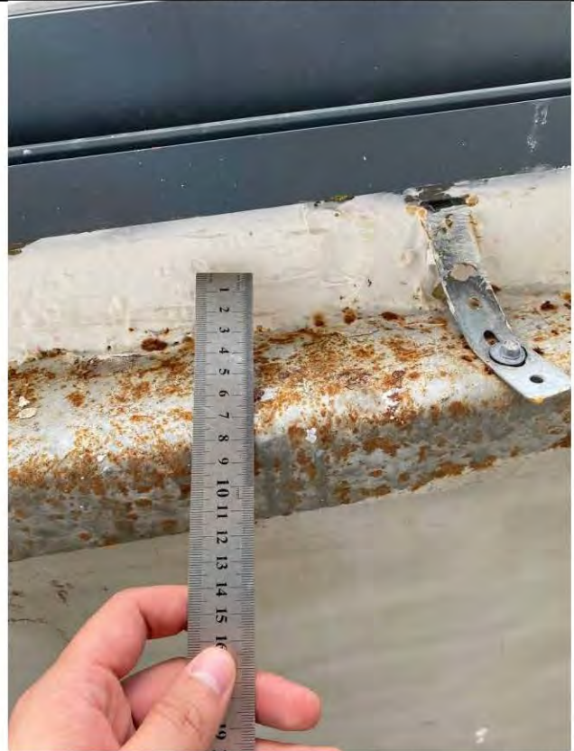
Фото 28, 29. Лоджия (1,9 кв.м.) 4.1 Отслоение окрасочного слоя, наличие коррозии на металлических ограждениях
