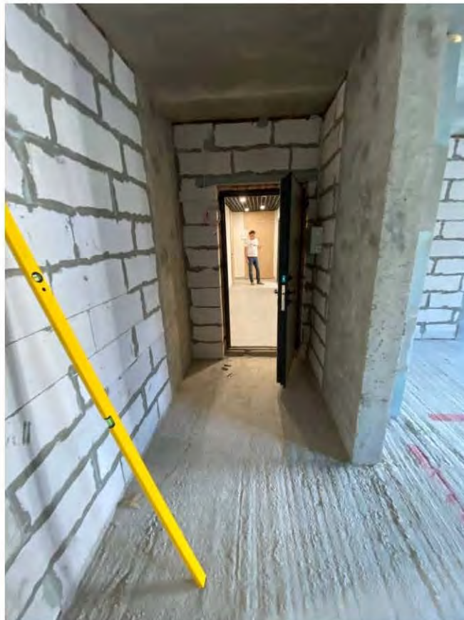
Фото 2. Коридор (7,90 кв.м.). Общий вид помещения.
