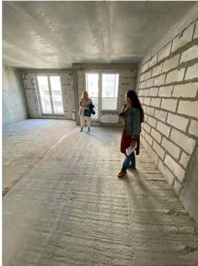
Фото 5. Комната 1 (14,7 кв.м.). Общий вид помещения.
