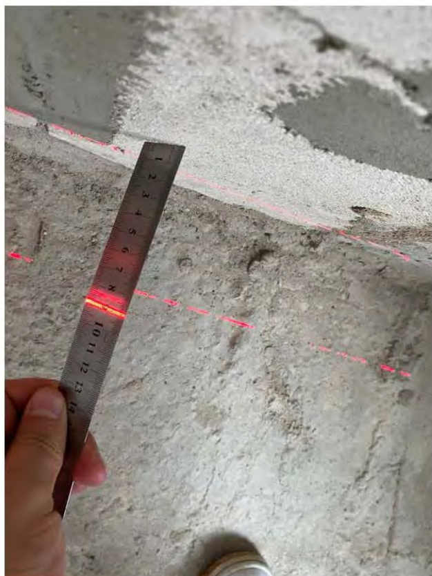
Фото 32, 33. Комната 2 (13,0 кв.м.) 5.1 Отклонение поверхности перегородок из газобетонных блоков от вертикали 14 мм
