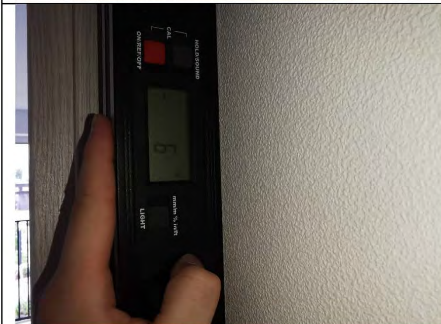
Фото №8. Измерение уровня стен в коридоре.
