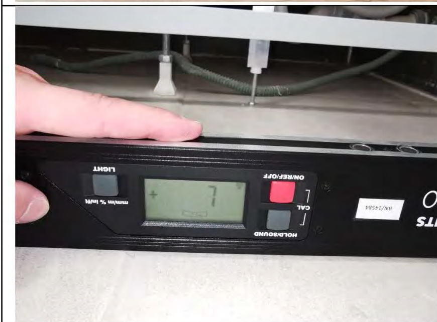
Фото №26. Измерение уровня пола в санузле.
