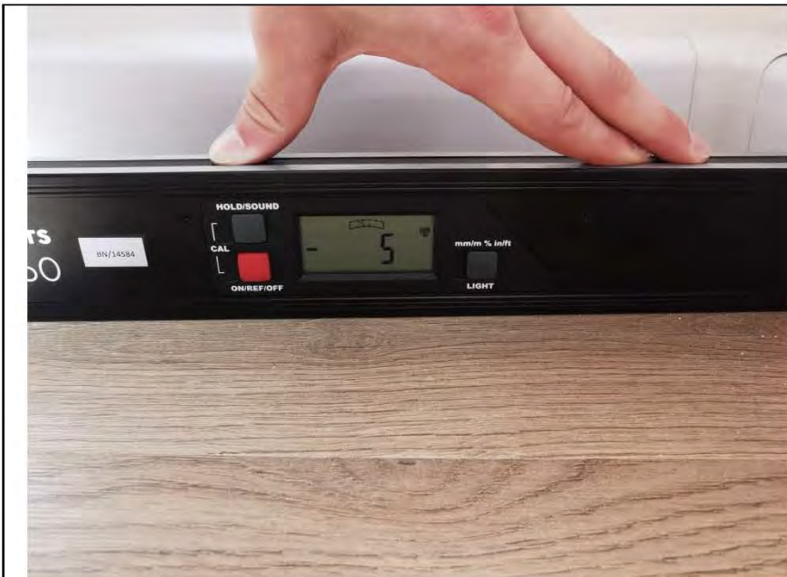
Фото №25. Измерение уровня пола в кухне.
