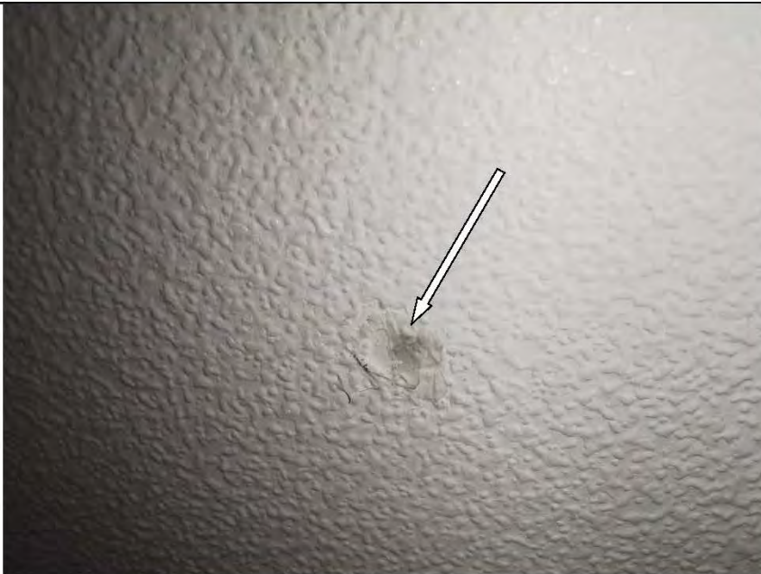
Фото №14. Потертости на обойном полотне в коридоре.
