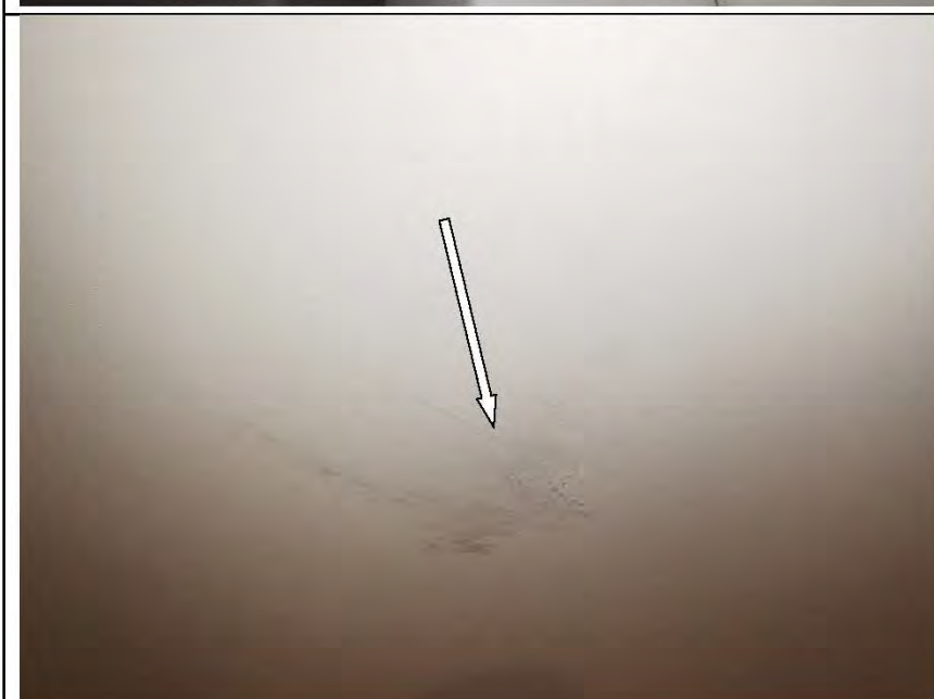
Фото №59. Загрязнения на полотне входного дверного блока.
