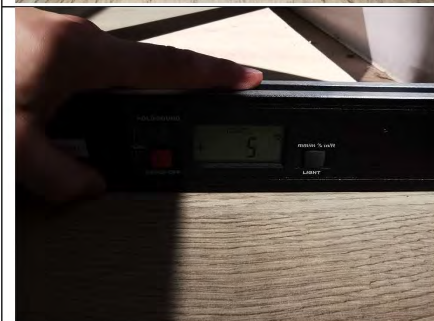
Фото №24. Измерение уровня пола в спальне.
