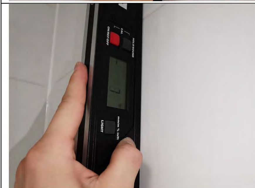
Фото №11. Измерение уровня стен в санузле.
