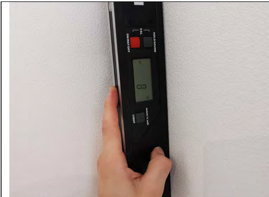
Фото №10. Измерение уровня стен в кухне.
