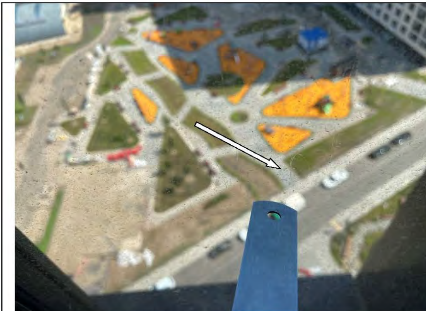
Фото №40. Царапина на стеклопакете конного блока ПВХ на лоджии.
