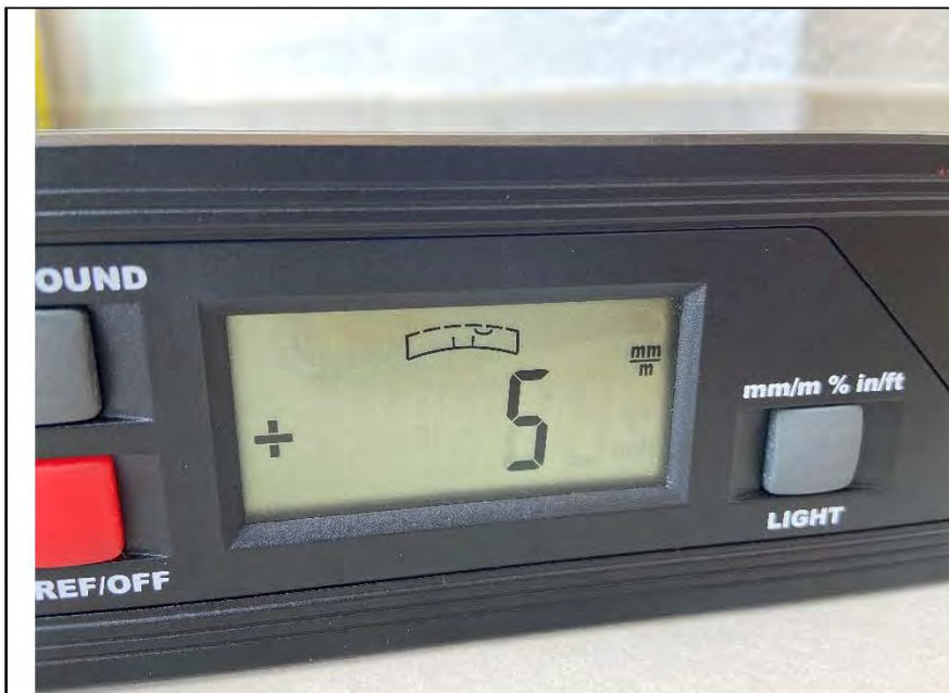
Фото №19. Отклонения поверхности напольного покрытия из керамической плитки на лоджии.
